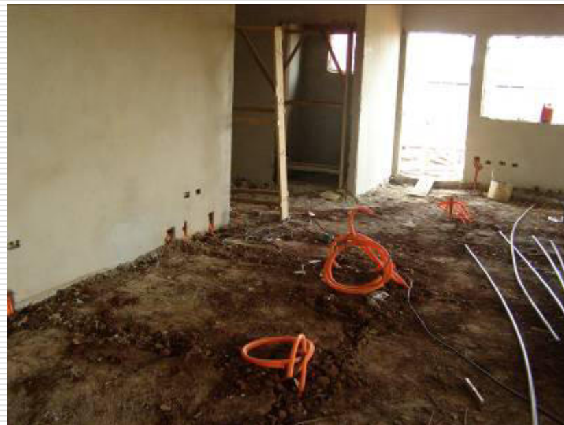
Detalhe da instalação da infraestrutura elétrica
