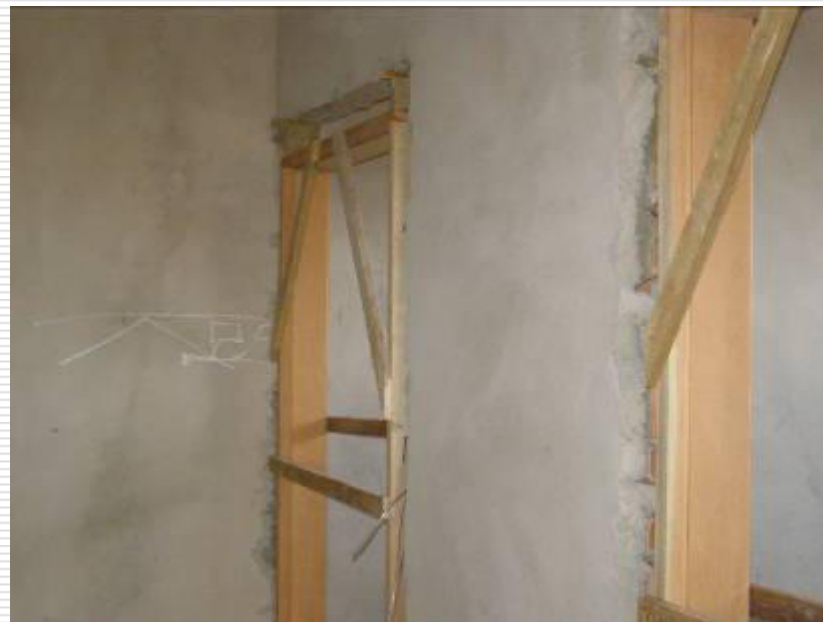
Detalhe dos batentes instalados na alvenaria
