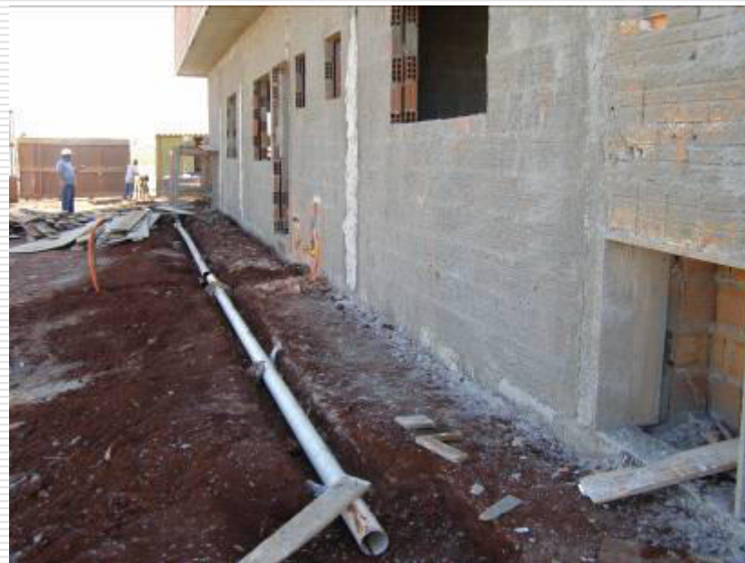
Escavação de valas e assentamento de tubulação para água pluvial
