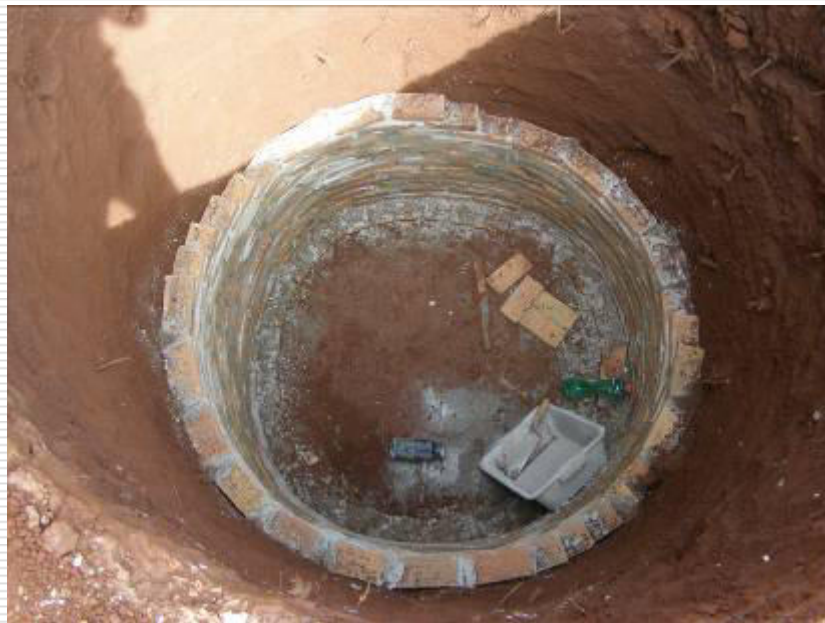
Detalhe da alvenaria da fossa séptica
