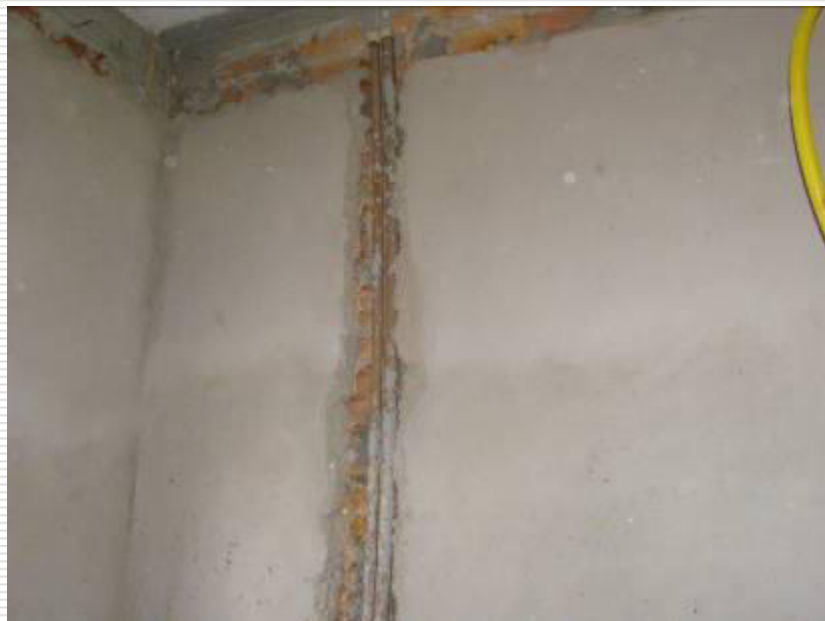
Detalhe da instalação hidráulica de água fria no banheiro
