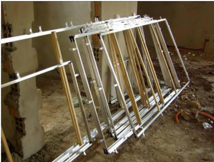
Detalhe dos contra-marcos das janelas
