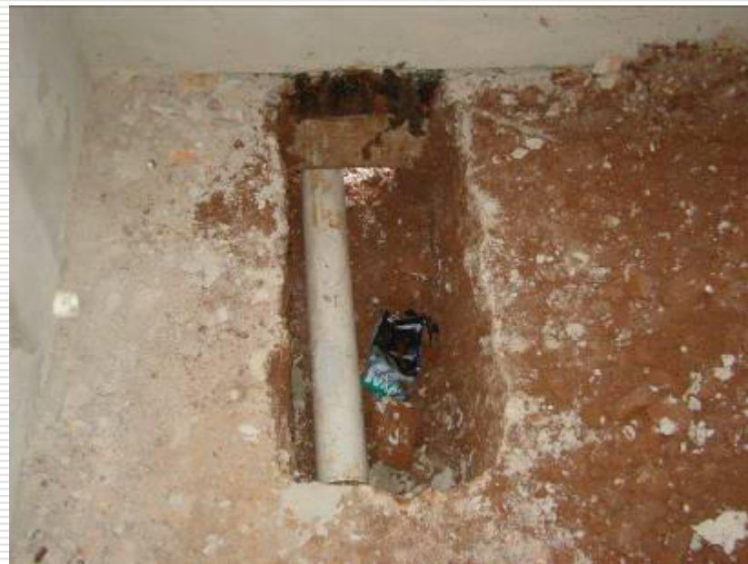
Detalhe da instalação hidráulica do esgoto no banheiro
