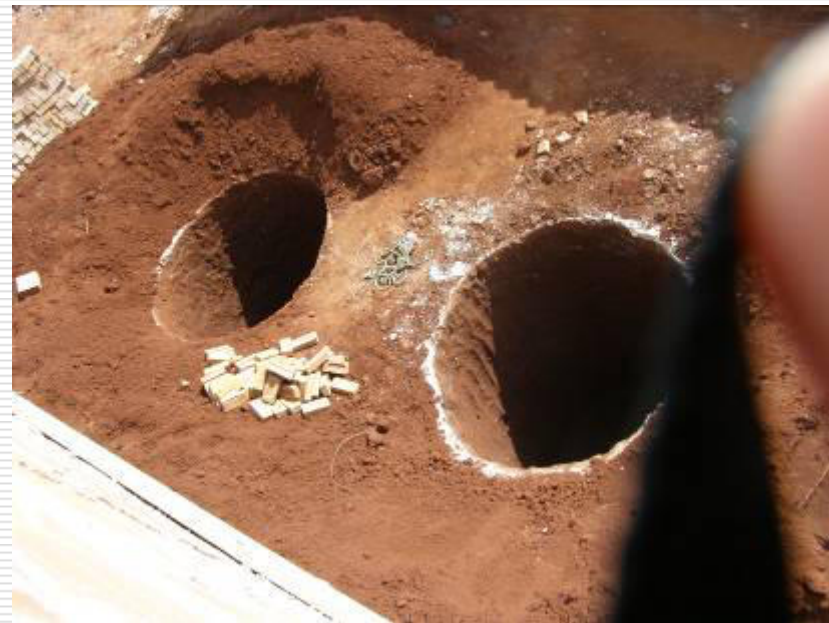
Vista da escavação da fossa séptica e sumidouro
