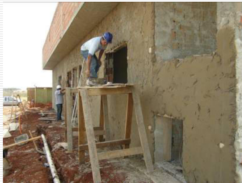
Detalhe do serviço de reboco na alvenaria de vedação externa
