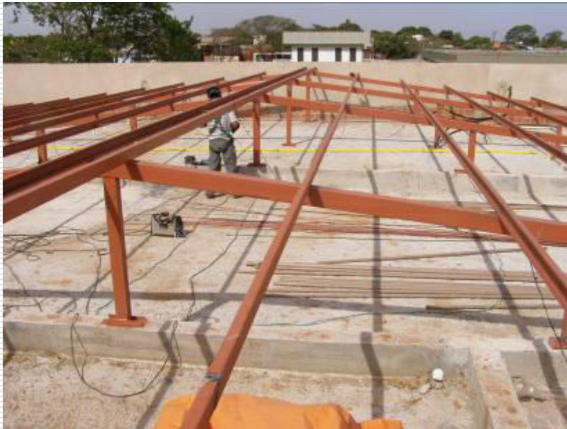
Instalação e soldagem da estrutura metálica do telhado
