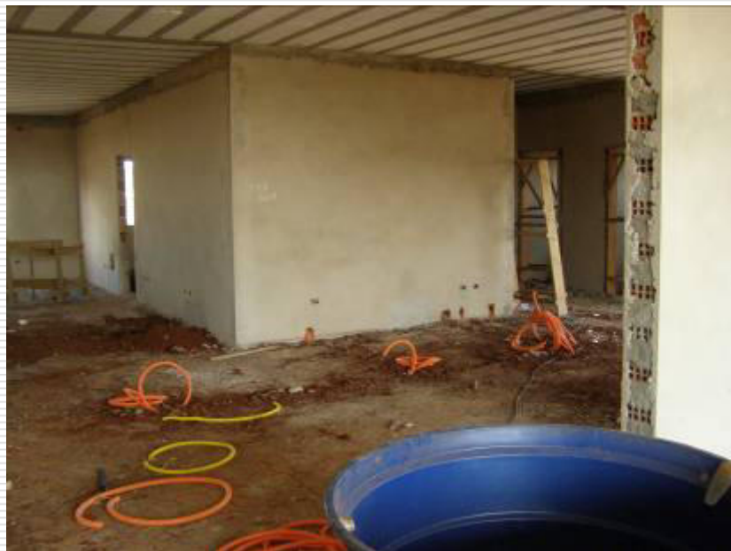
Detalhe da alvenaria rebocada e das instalações da infraestrutura elétrica
