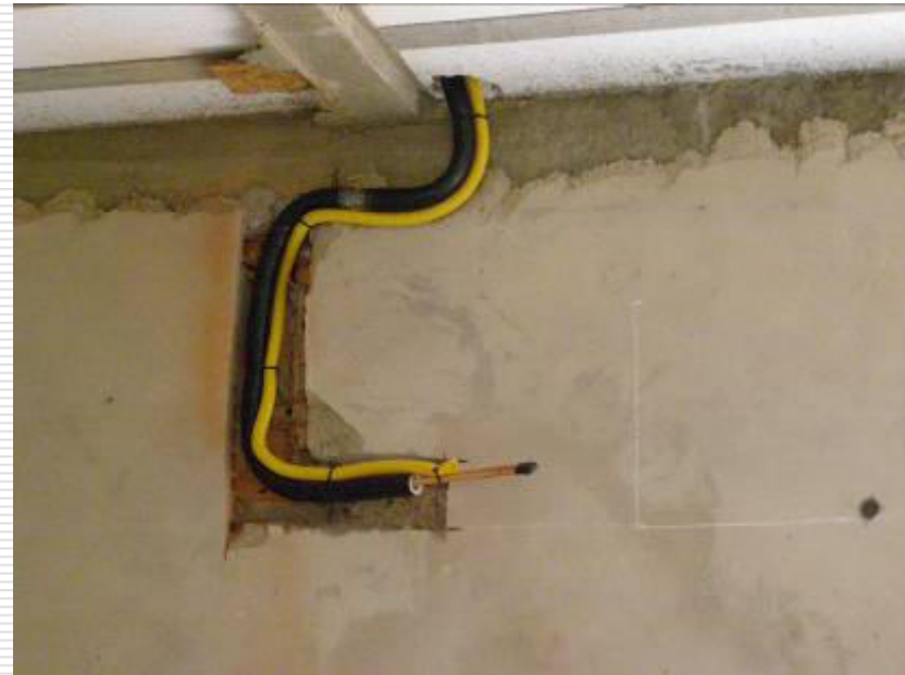
Detalhe da instalação infraestrutura hidráulica e elétrica do ar condicionado split (tubulação de drenagem e frigorígena da unidade evaporadora)
