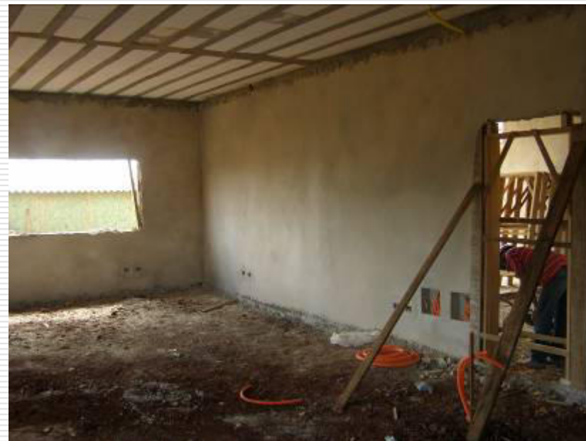
Paredes internas rebocadas e assentamento do batente de porta
