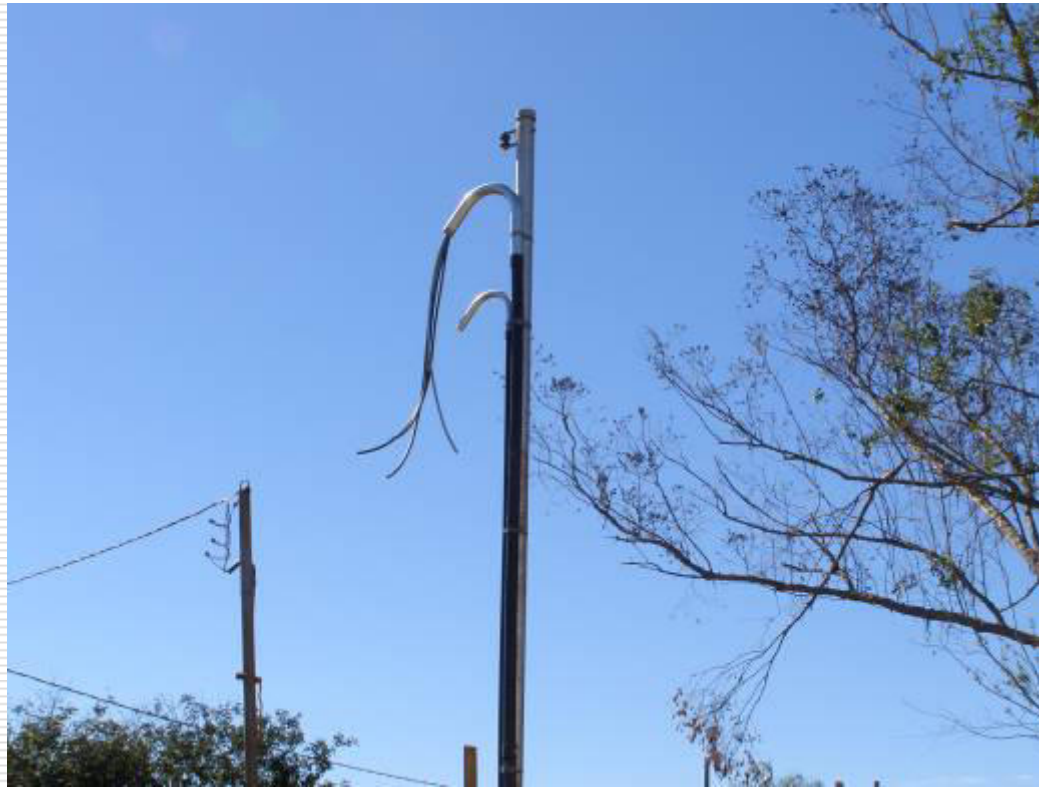
Detalhe do cabeamento aéreo que será ligado no poste de iluminação pública
