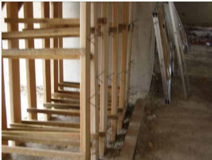
Detalhe dos batentes que serão instalados na alvenaria
