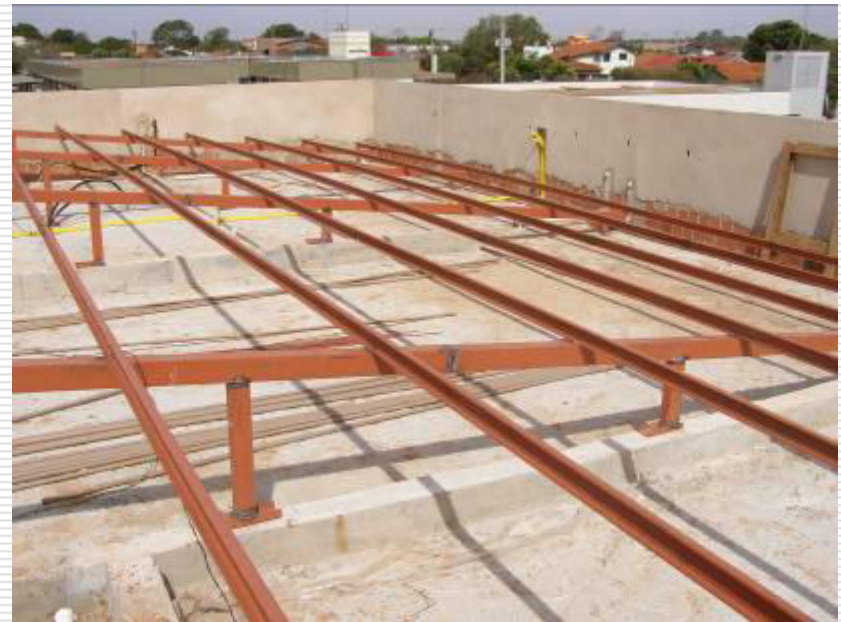
Detalhe da estrutura metálica do telhado
