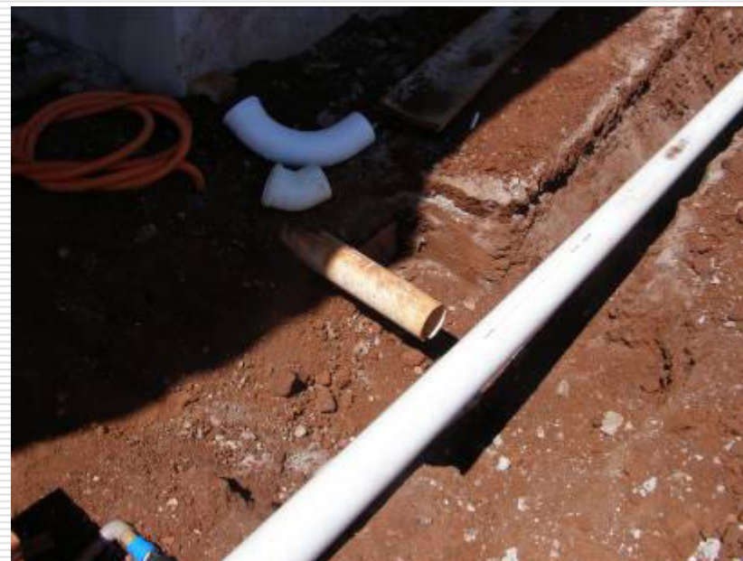
Assentamento da tubulação de esgoto
