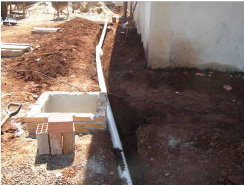
Caixa de passagem de água pluvial
