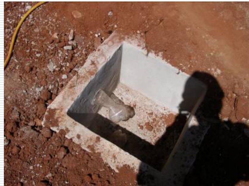
Caixa de passagem de água pluvial
