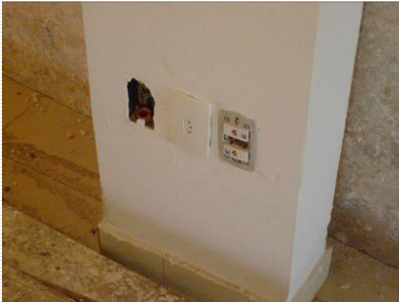
Pontos de tomada e lógica sendo instalados
