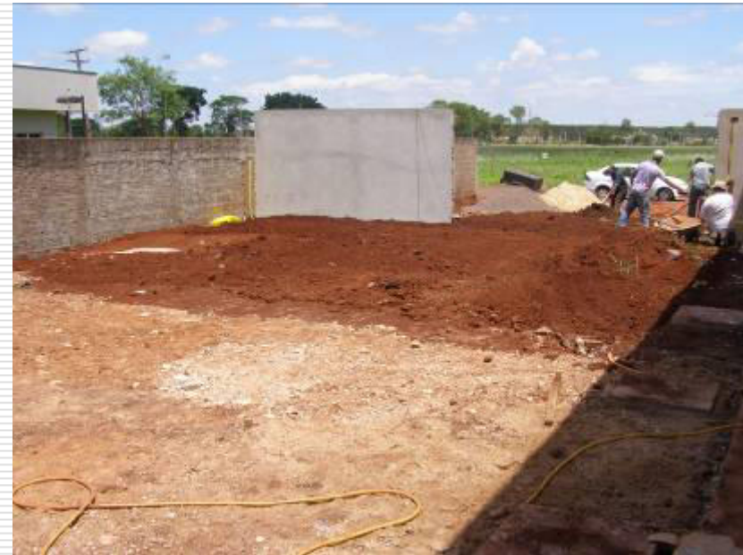
Regularização do terreno para concretagem do piso do estacionamento
