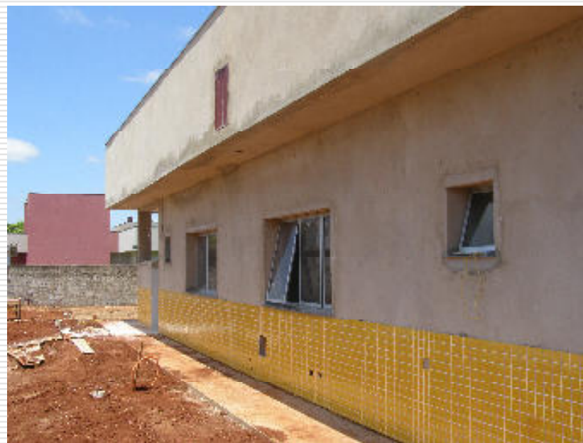
Detalhe das janelas já com os vidros 4,0mm instalados
