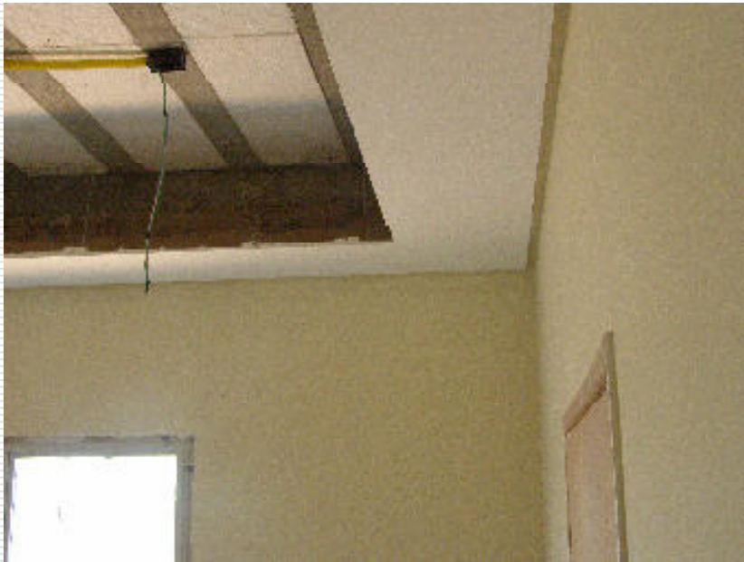
Instalação e preparação do forro de gesso nas salas onde haverá forro metálico
