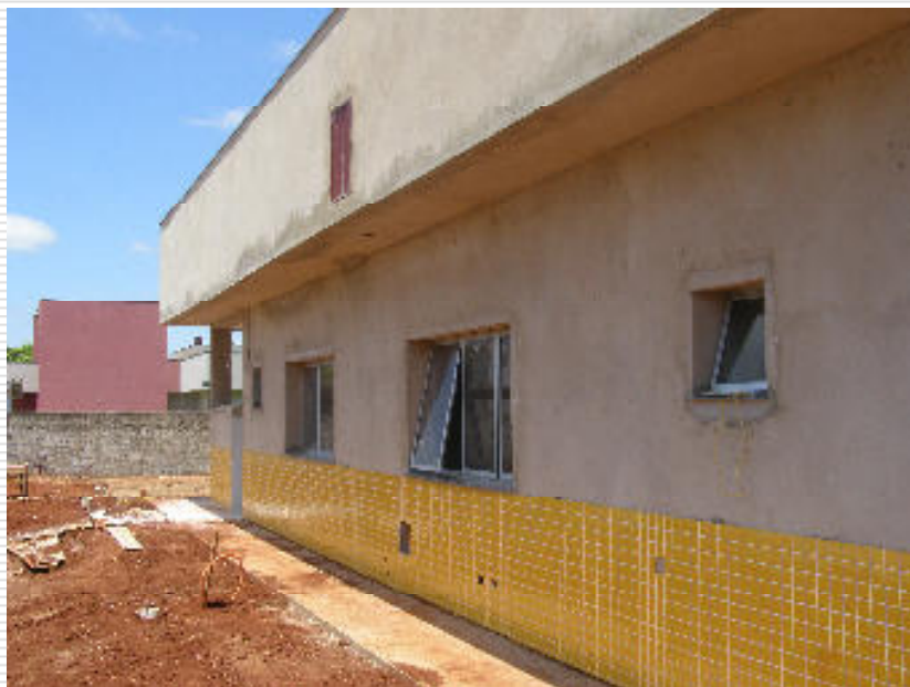
Portinhola instalada na platibanda para acesso da área técnica entre laje e o telhado
