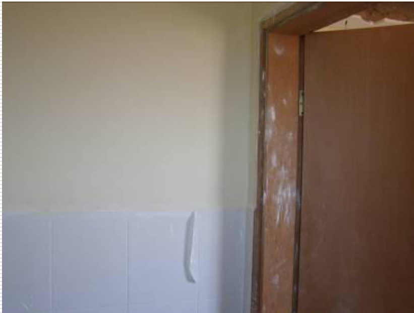
Detalhe da porta de madeira já instalada no batente.
