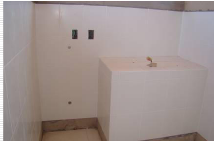
Paredes da lavanderia com o revestimento cerâmico instalado e rejuntado
