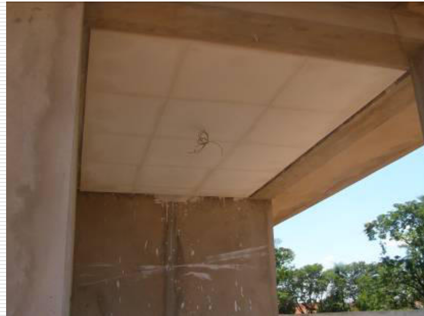
Detalhe do forro de gesso instalado sob a laje da área de serviço
