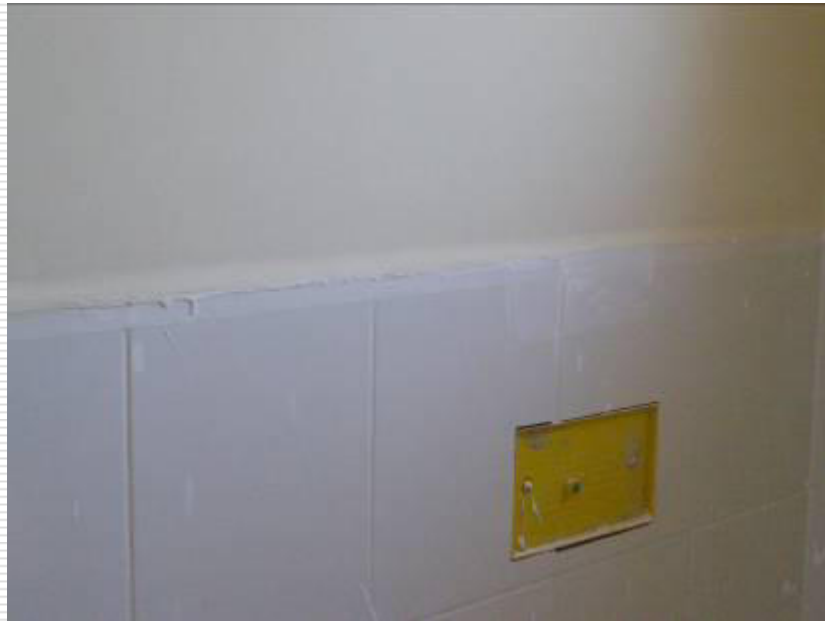
Paredes dos banheiros com o revestimento cerâmico instalado e rejuntado
