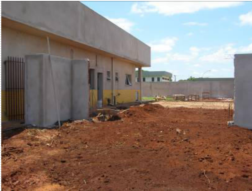
Detalhe do muro sendo executado na fachada.
