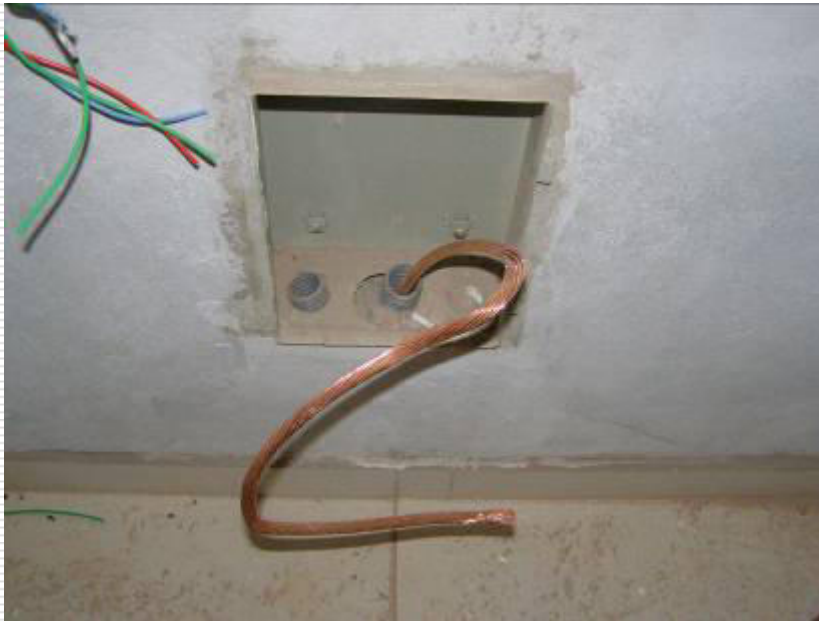
Detalhe da montagem da infra estrutura do sistema de proteção contra descargas atmosféricas
