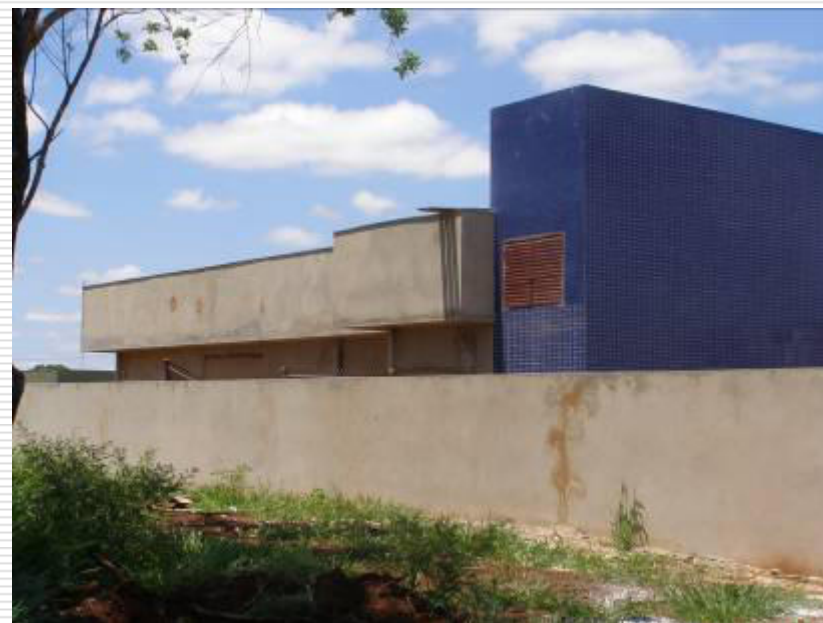
Portinhola instalada na parede lateral da edificação que dá acesso ao local onde está instalada a caixa d'água
