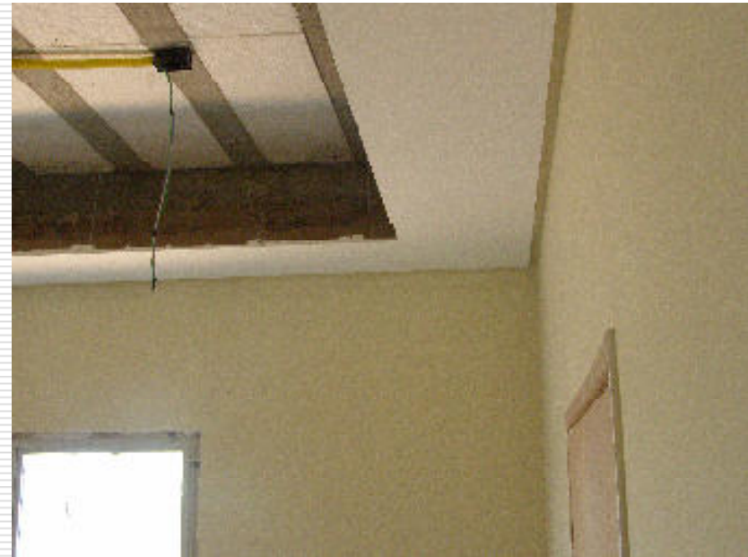
Paredes de todo o interior da edificação regularizada com massa PVA, lixada e com fundo selador aplicado para receber a pintura PVA definitiva
