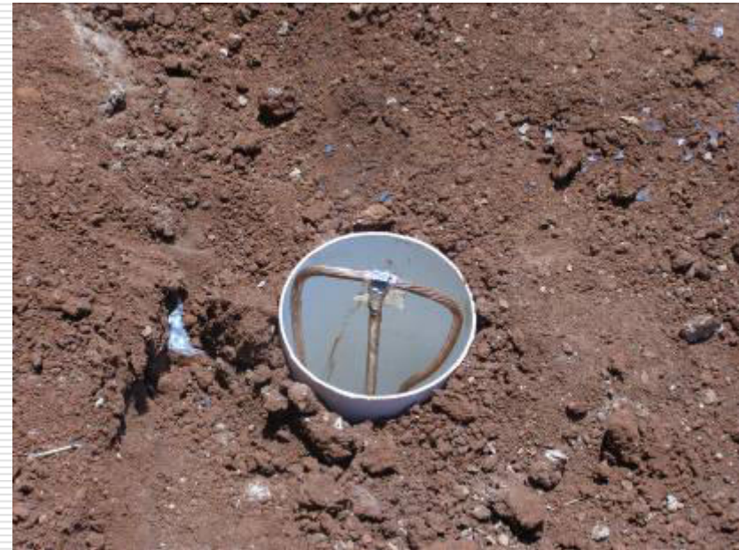
Detalhe da montagem da infra estrutura do sistema de proteção contra descargas atmosféricas
