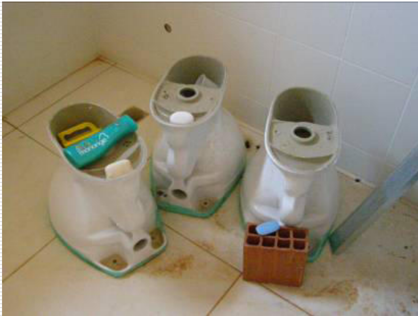
Detalhe das louças que serão instaladas nos banheiros
