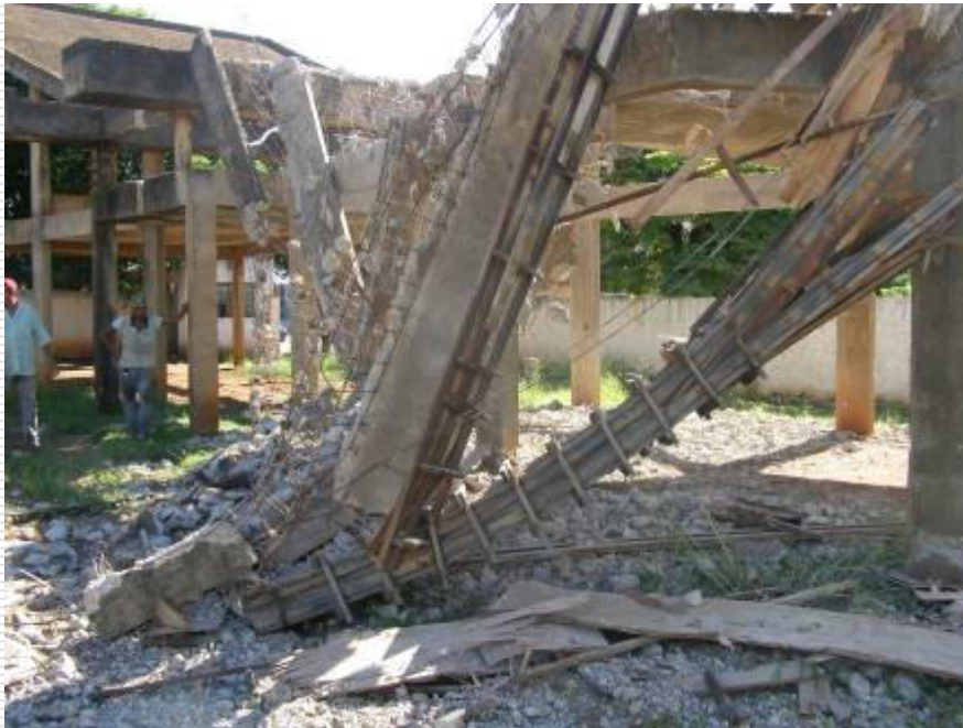
Demolição da estrutura
