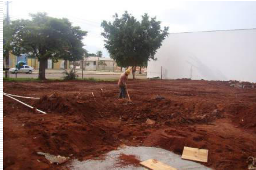
Terreno raspado mecanicamente (detalhe ao fundo da ausência do muro que foi demolido)
