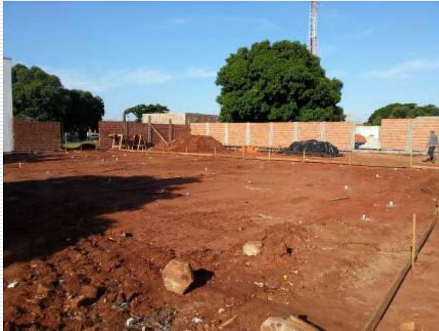
Detalhe da locação da obra com gabarito e pontaletes sinalizando as estacas a serem escavadas
