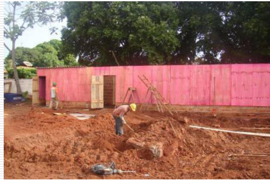
Detalhe da construção do barraco para depósito da obra
