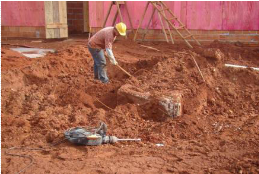
Detalhe da retirada do bloco de fundação existente
