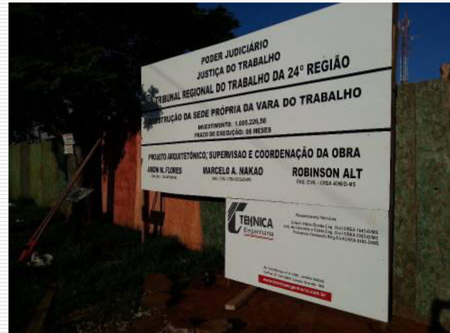
Detalhe das placas de identificação da obra
