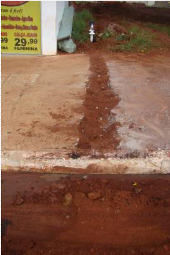
Detalhe das instalações provisórias de energia elétrica e de água
