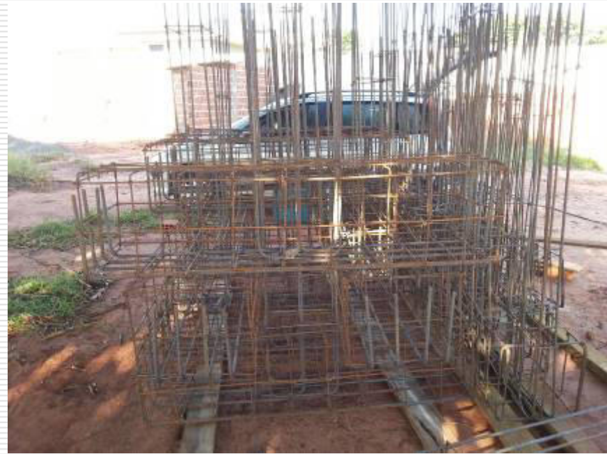
Detalhe das armações dos blocos de fundação juntamente com os arranque dos pilares
