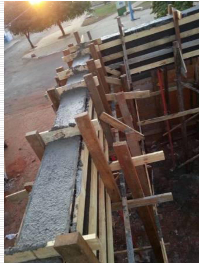
Detalhe do escoramento, infraestrutura de eletrodutos no piso e da viga aparente concretada
