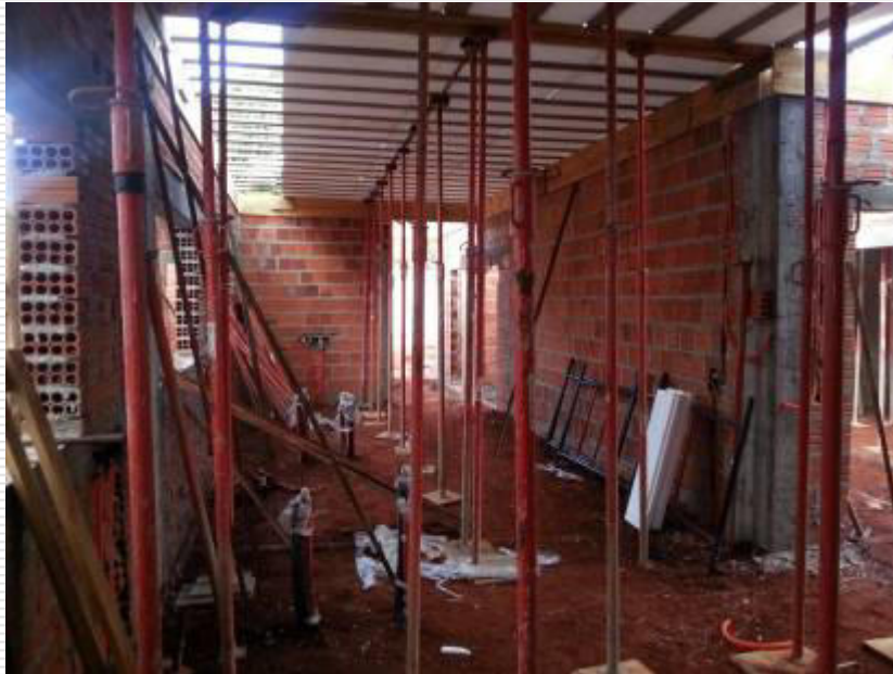
Detalhe do escoramento, infraestrutura de eletrodutos no piso e da viga aparente concretada
