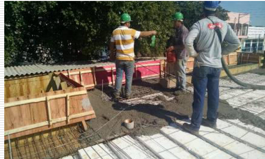
Detalhe da concretagem. Fator de resistência do concreto f_{ck} 30 MPa
