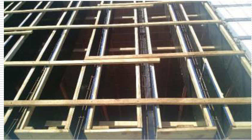
Forma compensado resinado para vigas do pergolado
