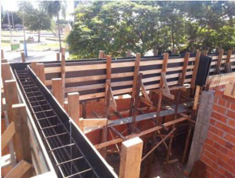
Detalhe da forma compensada plastificada para viga concreto aparente
