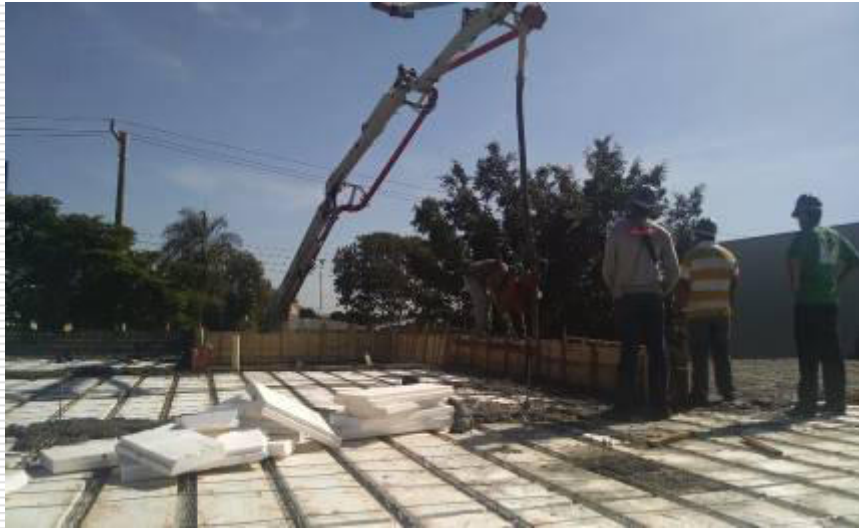
Concreto usinado para vigas de cobertura e laje
