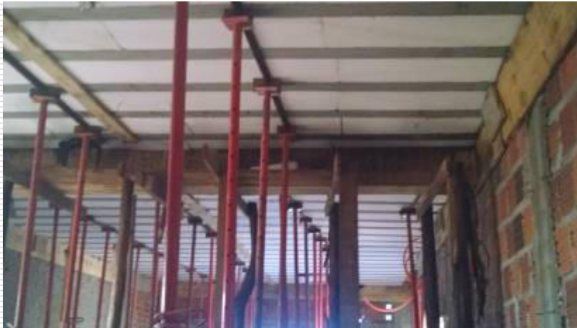
Detalhe do escoramento da laje
