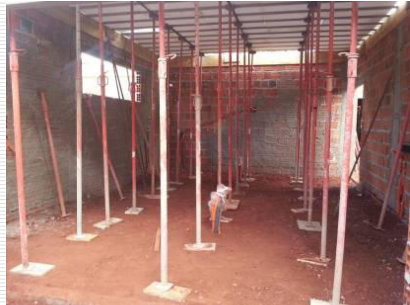
Escoramento da laje e detalhe do chapisco nas paredes internas
