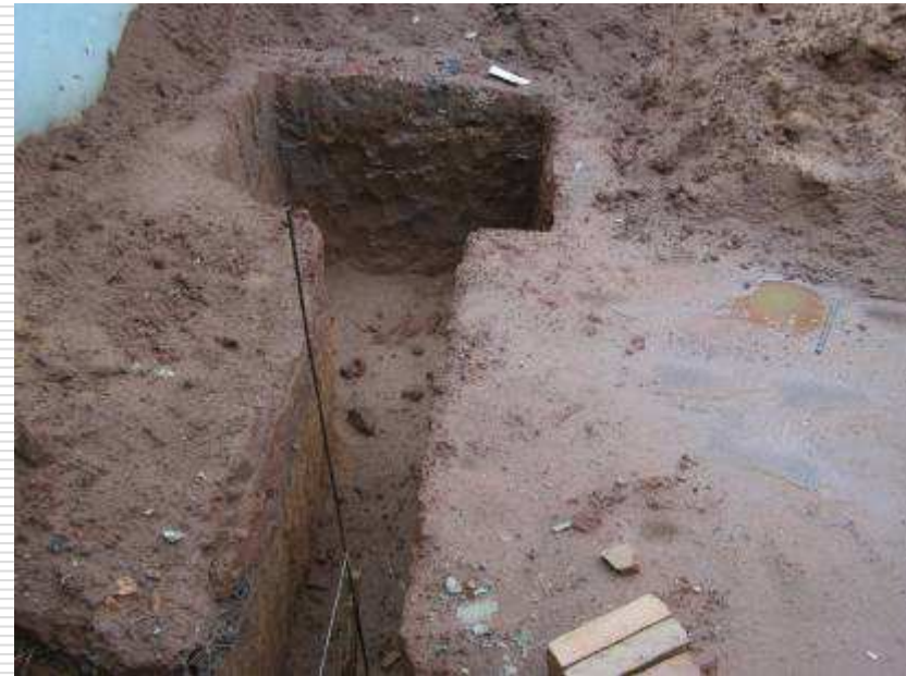
Escavação para infraestrutura
