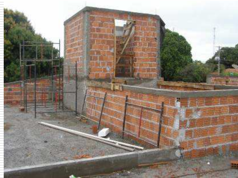
Abrigo onde será alojada a caixa d'água
