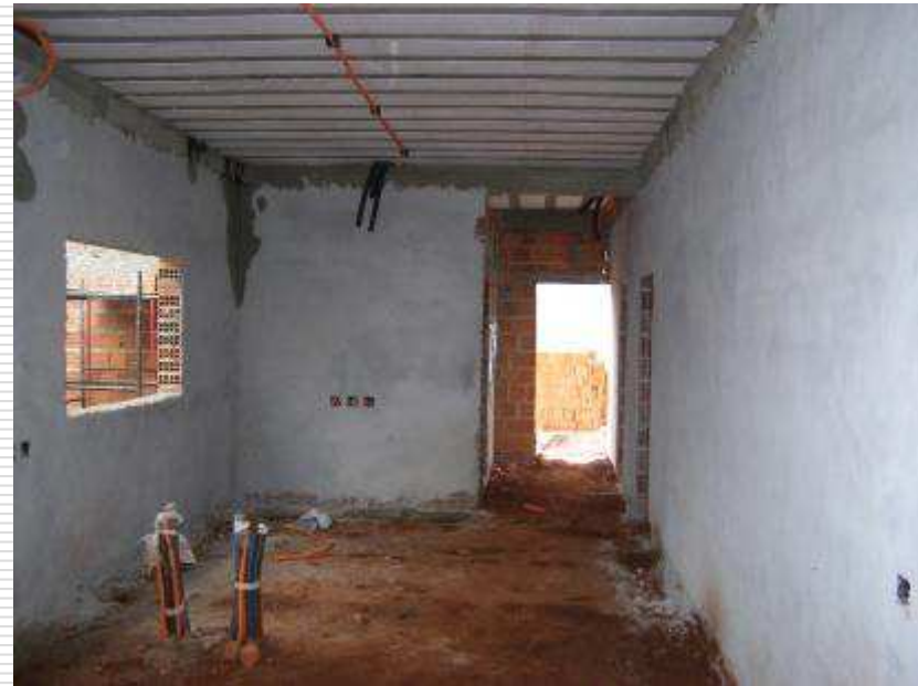
Reboco de paredes internas e infraestrutura das instalação elétricas
