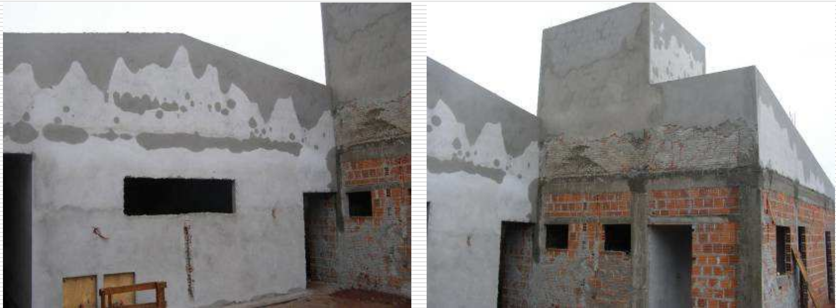
Detalhe dos serviços de revestimento, chapisco e reboco em paredes externas
