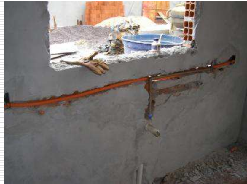
Infraestrutura hidráulica para água fria
