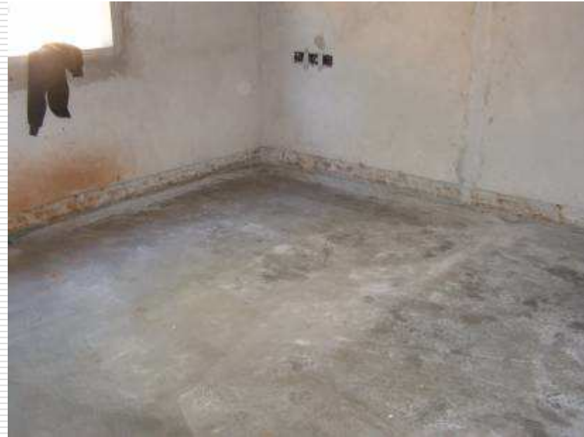
Contrapiso de concreto magro, inclusive regularização
