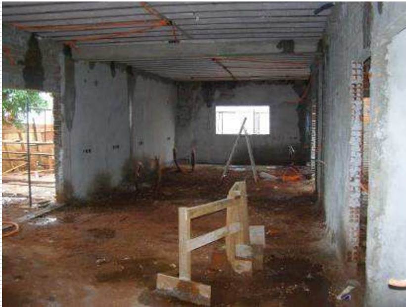
Chapisco e reboco das paredes internas
