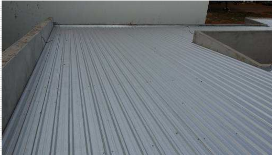
Telha de aço zincado trapezoidal sendo montada
