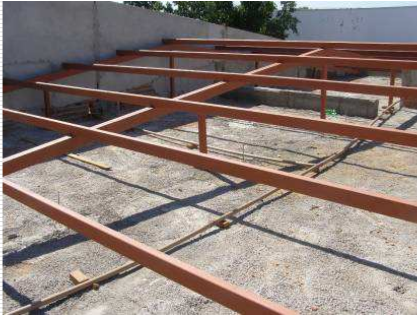
Estrutura metálica do telhado sendo montada
