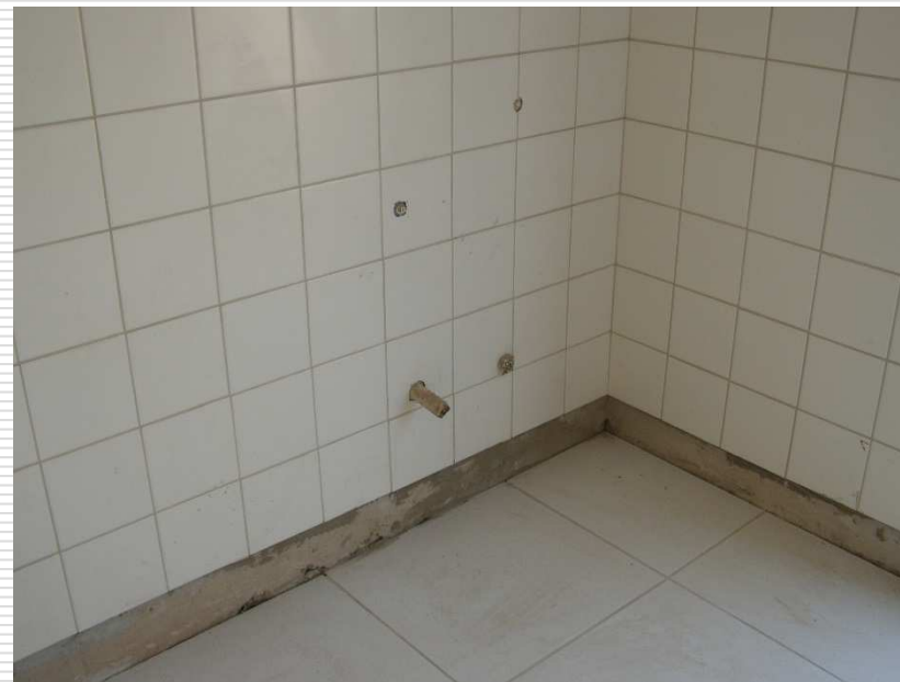
Detalhe do revestimento de paredes interna com rejuntamento
