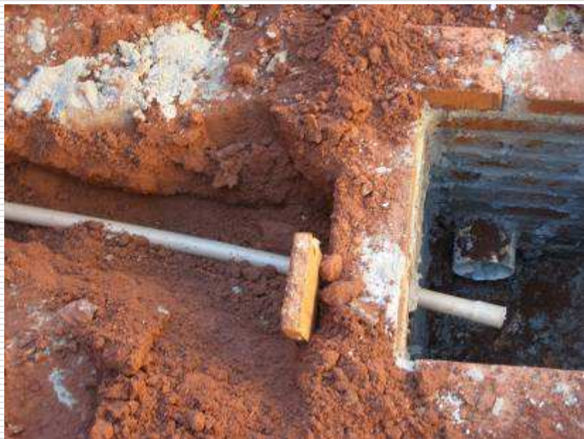
Detalhe das instalações de esgoto e hidráulica
