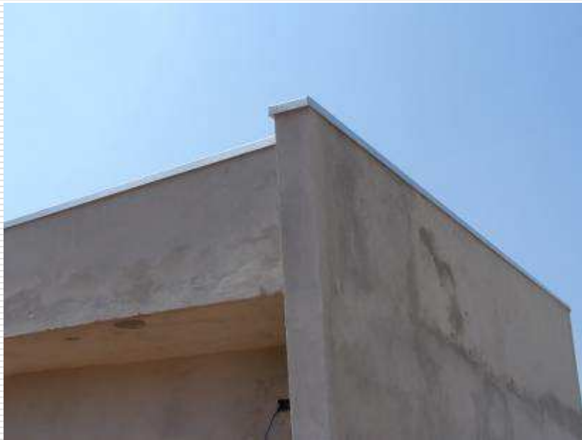
Detalhe do rufo de chapa galvanizada
