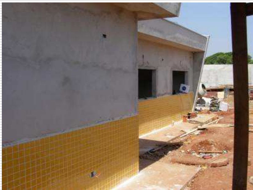
Revestimento cerâmico 10x10cm das paredes externas
