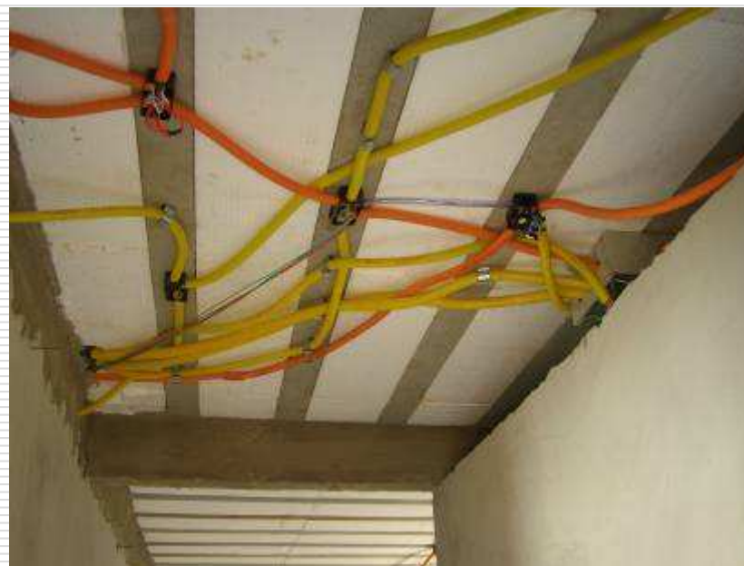
Detalhe das instalações elétrica e cabeamento estruturado
