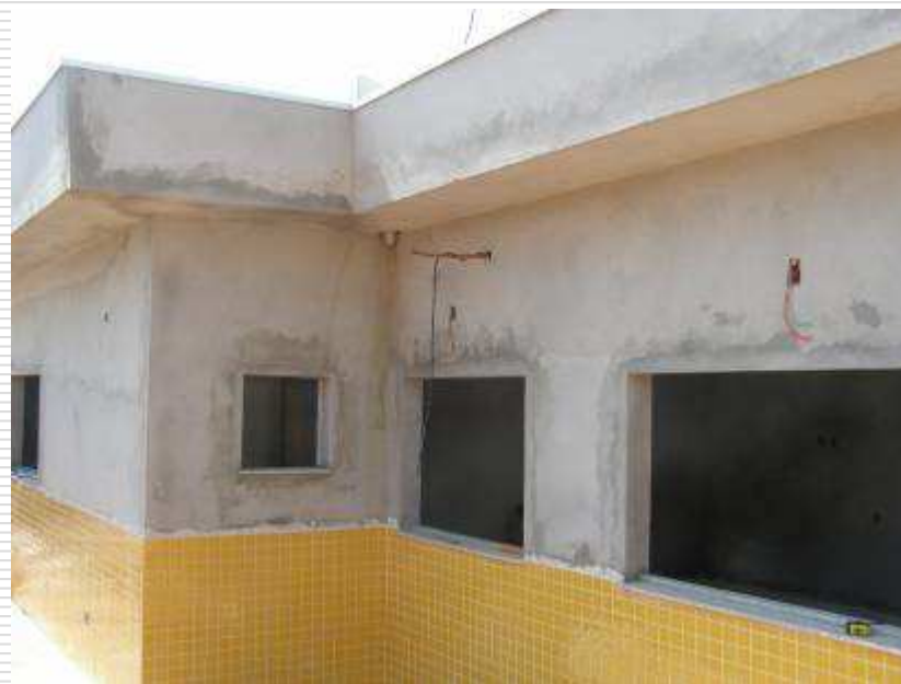
Revestimento cerâmico 10x10cm das paredes externas
