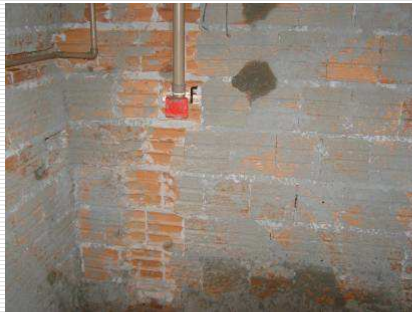
Detalhe das instalações de esgoto e hidráulica
