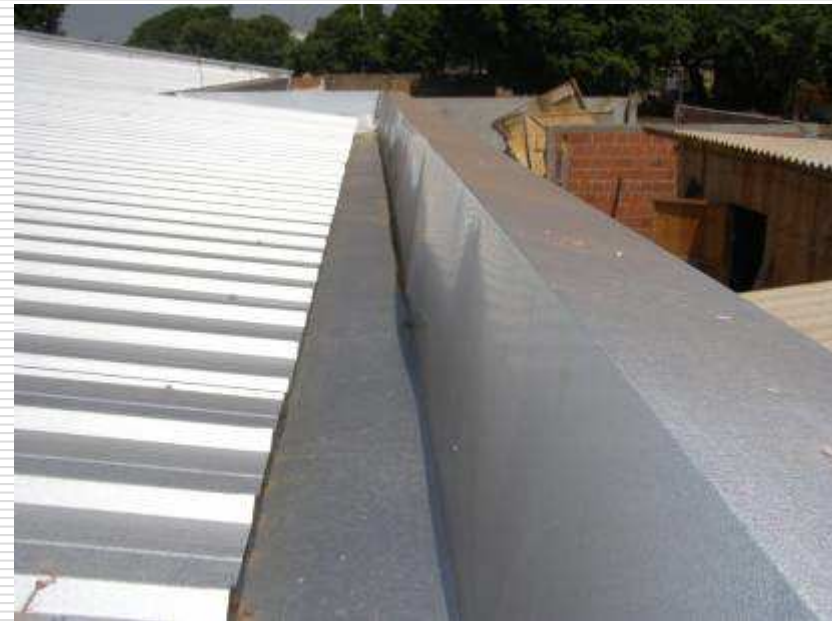
Detalhe da telha de aço trapezoidal 0,50mm e da calha de chapa galvanizada
