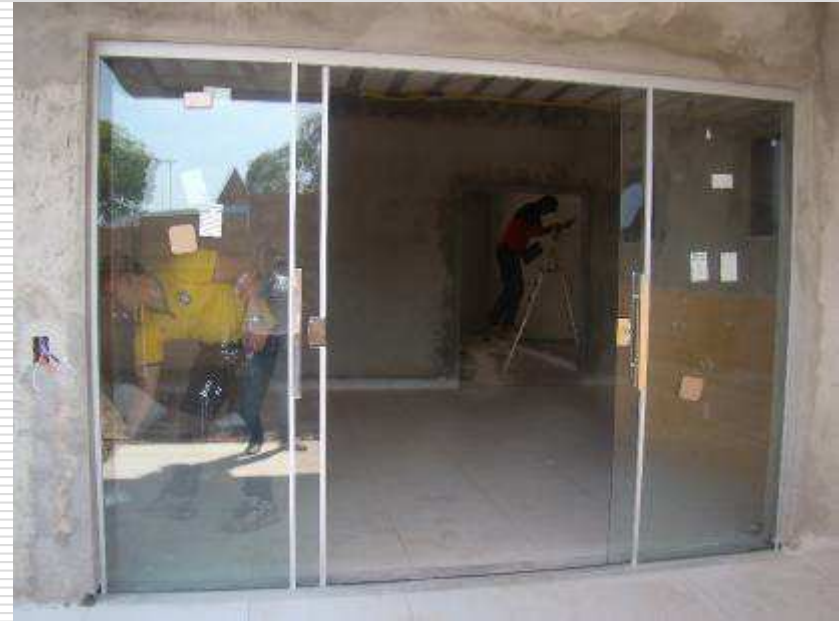
Detalhe das portas em vidro blindex instaladas
