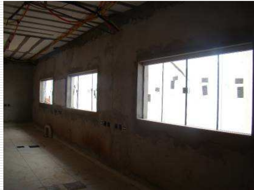
Detalhe das janelas em vidro blindex instaladas
