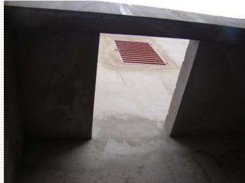
Detalhe da porta de ferro do alçapão para acesso ao compartimento da caixa d'água
