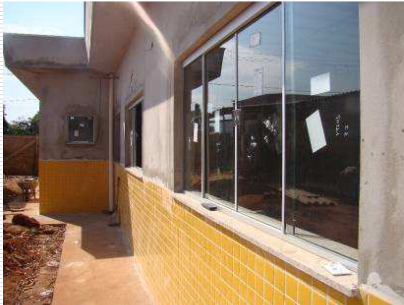
Detalhe das janelas em vidro blindex instaladas
