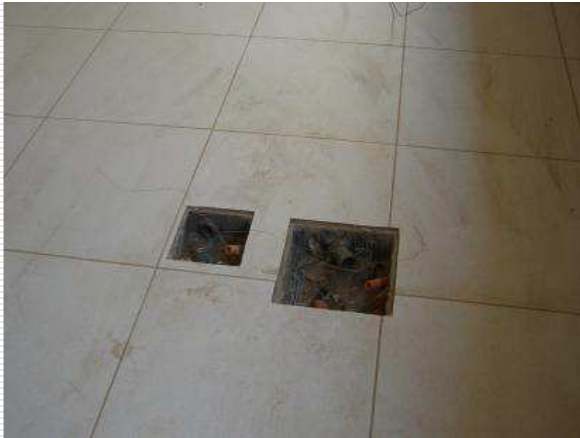
Detalhe das caixas de passagem de piso
