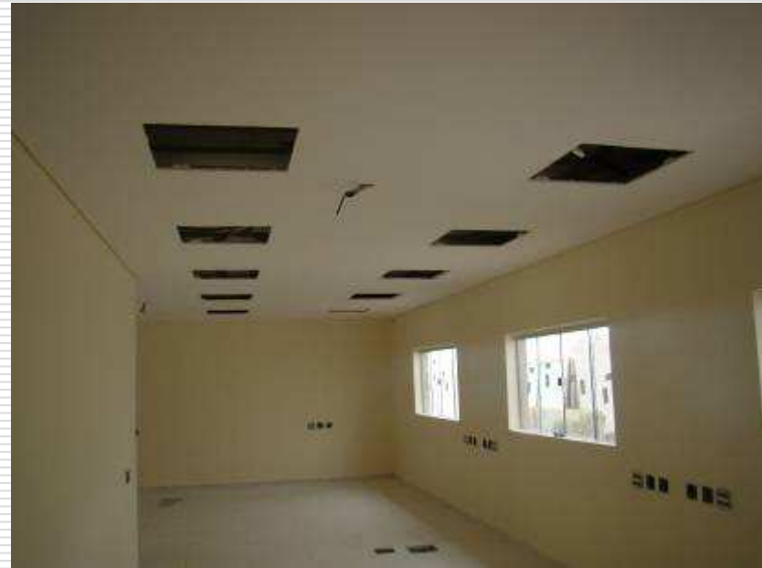
Detalhe do revestimento de teto elaborado com gesso. Nas laterais percebe-se a junta paulista. Vista geral do piso e rodapé cerâmicos.
