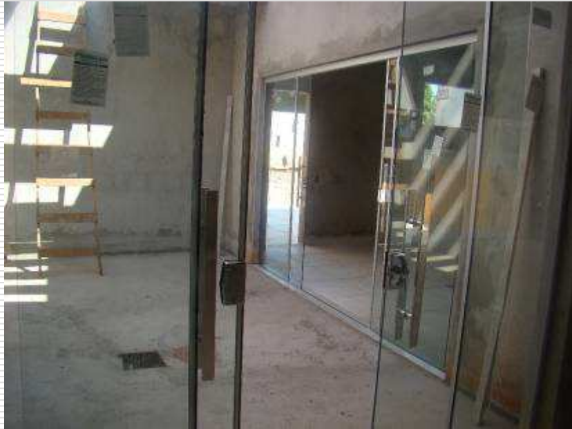
Detalhe das portas em vidro blindex instaladas
