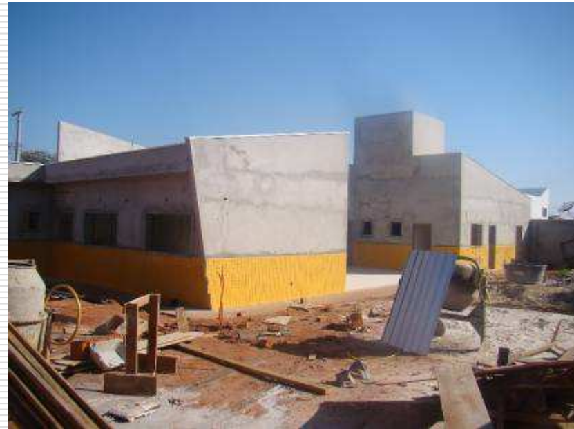
Detalhe do revestimento cerâmico amarelo (todo o perímetro do imóvel)
