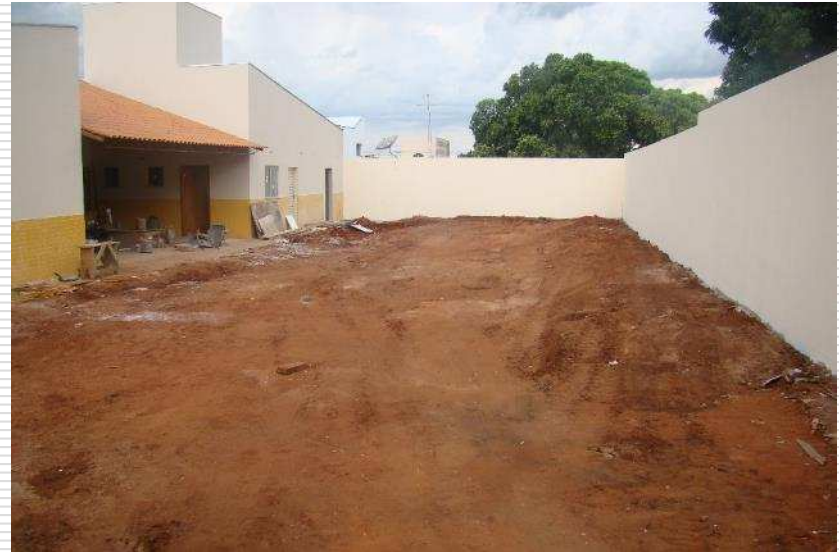
Detalhe da pintura dos muros
