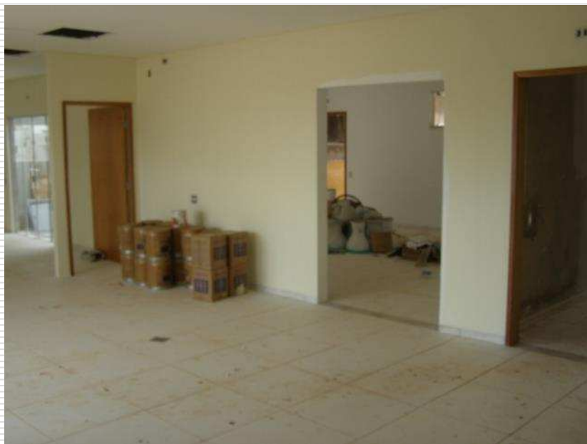
Detalhe dos pisos cerâmicos com soleiras de granito
