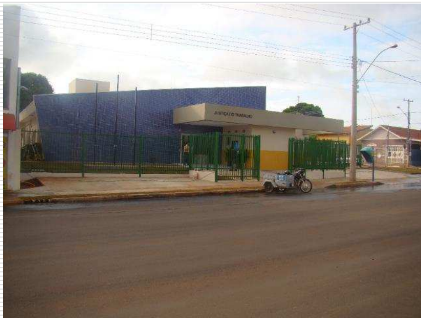
Vista geral da obra
