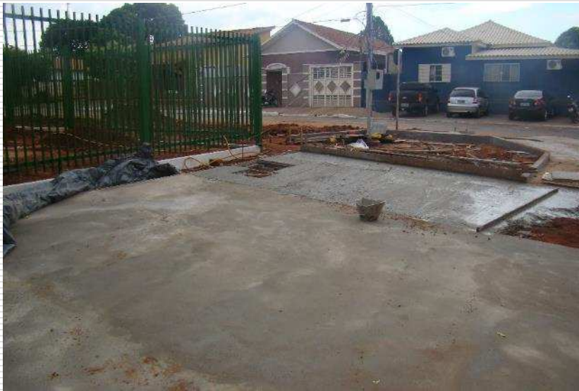
Execução da concretagem do estacionamento externo
