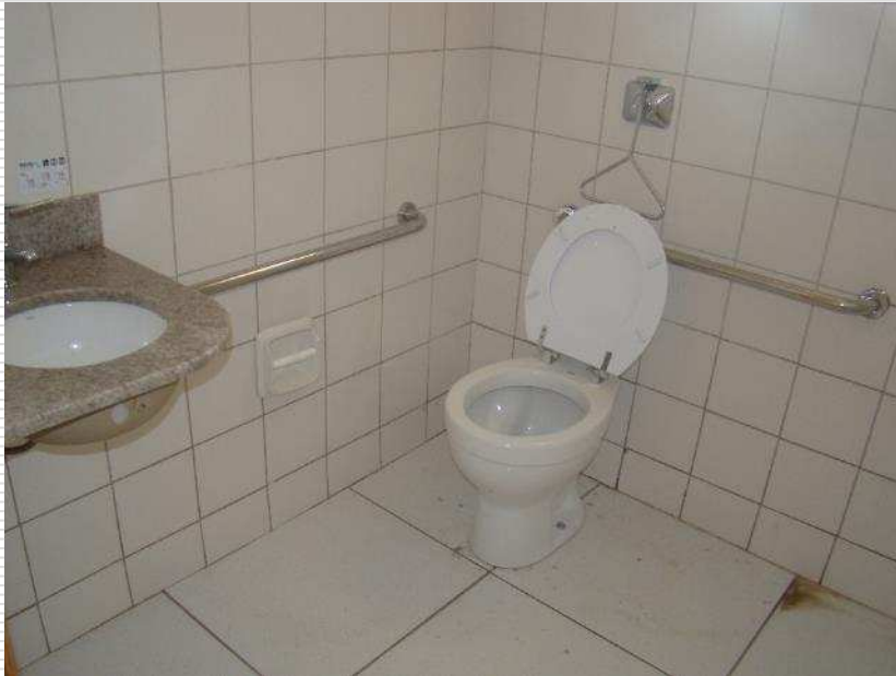
Detalhe do banheiro: louças e metais
