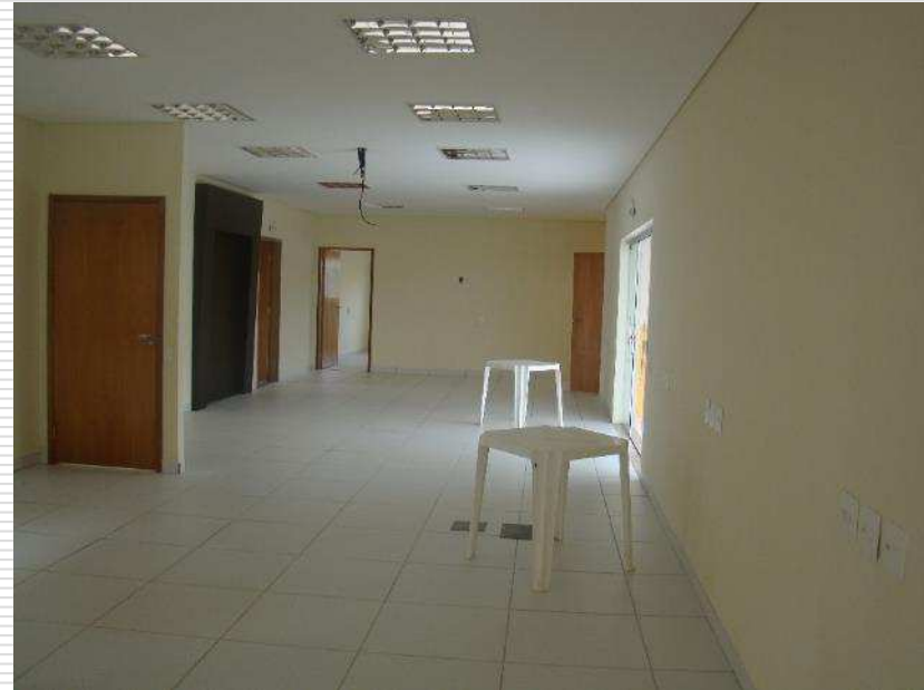
Detalhe das luminárias, interruptores e tomadas.
