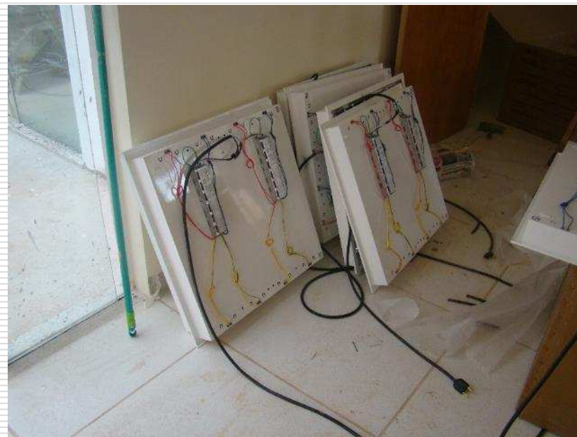
Luminárias sendo montadas
