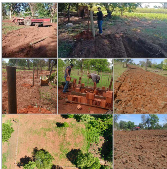
Cercamento, preparo de solo e construção da base das caixas d'água nos quintais
