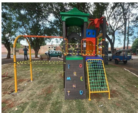
FOTO 27: 30/10/2024 – Segundo dia da montagem do playground
