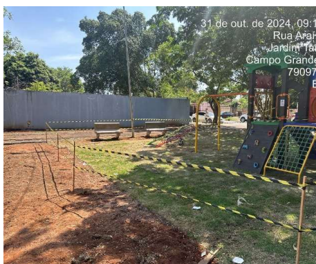
FOTO 30: 31/10/2024 – Término da montagem do playground e área isolada
