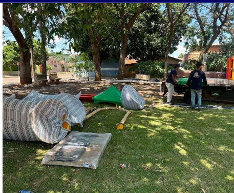
FOTO 14: 29/10/2024 – Início da montagem do playground
