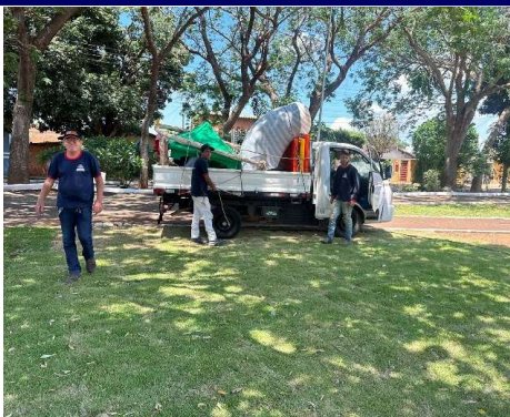
FOTO 13: 29/10/2024 – Início da montagem do playground
