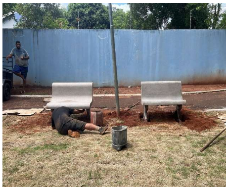
FOTO 10: 28/10/2024 – Serviço de instalação dos bancos de concreto
