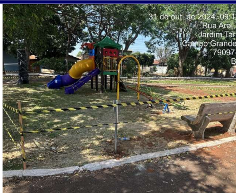
FOTO 31: 31/10/2024 – Término da montagem do playground e área isolada
