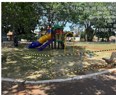
FOTO 33: 31/10/2024 – Término da montagem do playground e área isolada
