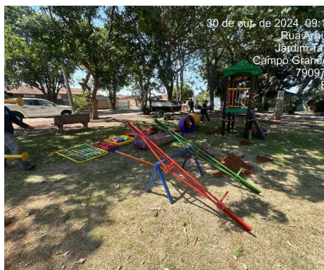
FOTO 24: 30/10/2024 – Segundo dia da montagem do playground
