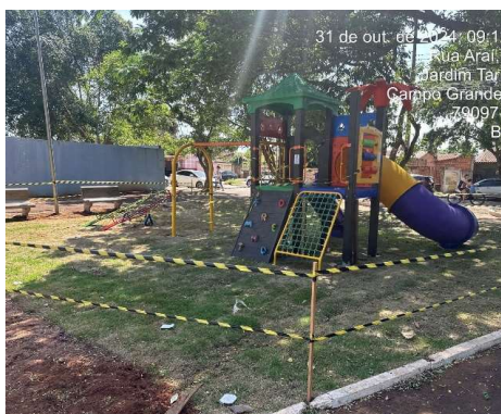
FOTO 29: 31/10/2024 – Término da montagem do playground e área isolada
