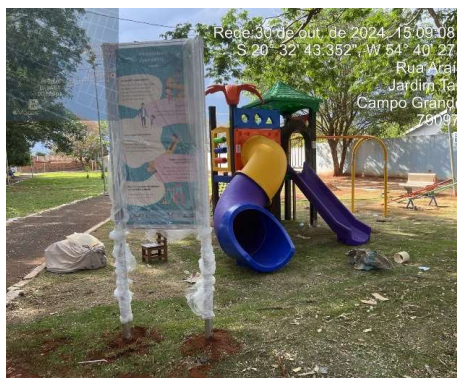
FOTO 28: 30/10/2024 – Segundo dia da montagem do playground
