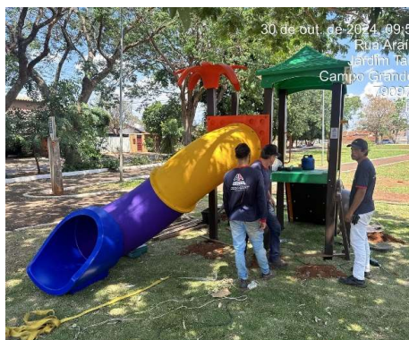
FOTO 22: 30/10/2024 – Segundo dia da montagem do playground
