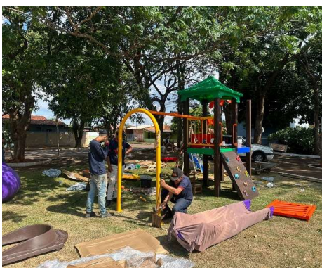
FOTO 17: 29/10/2024 – Início da montagem do playground
