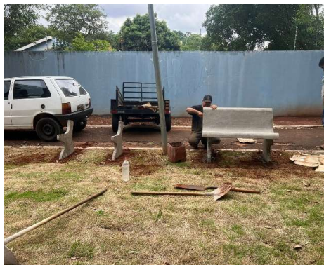
FOTO 09: 28/10/2024 – Serviço de instalação dos bancos de concreto
