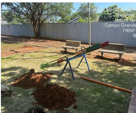
FOTO 23: 30/10/2024 – Segundo dia da montagem do playground
