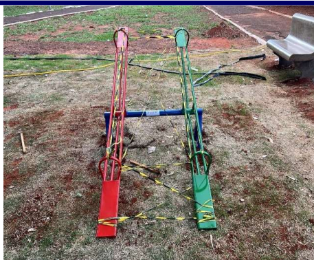
FOTO 26: 30/10/2024 – Segundo dia da montagem do playground
