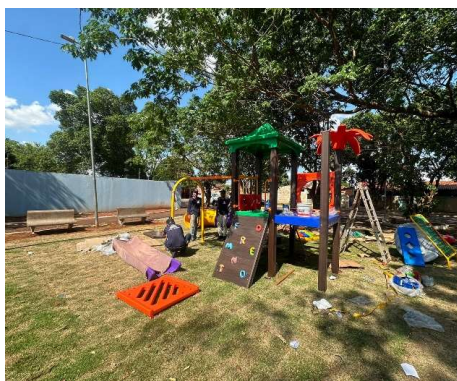
FOTO 18: 29/10/2024 – Início da montagem do playground
