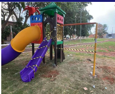
FOTO 25: 30/10/2024 – Segundo dia da montagem do playground
