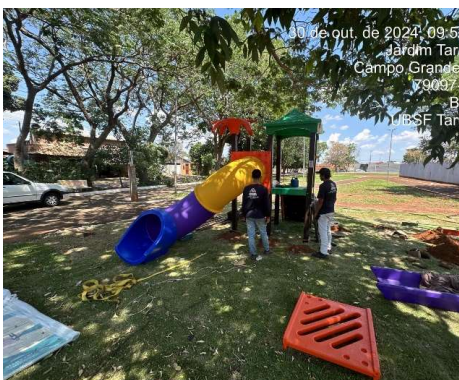
FOTO 21: 30/10/2024 – Segundo dia da montagem do playground
