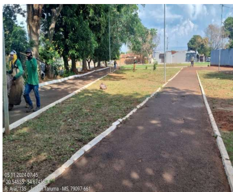
FOTO 35: 05/11/2024 – Limpeza do local do playground
