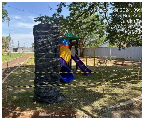
FOTO 34: 31/10/2024 – Término da montagem do playground e área isolada
