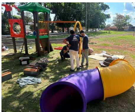
FOTO 16: 29/10/2024 – Início da montagem do playground
