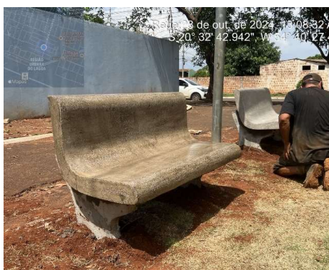
FOTO 11: 28/10/2024 – Serviço de instalação dos bancos de concreto
