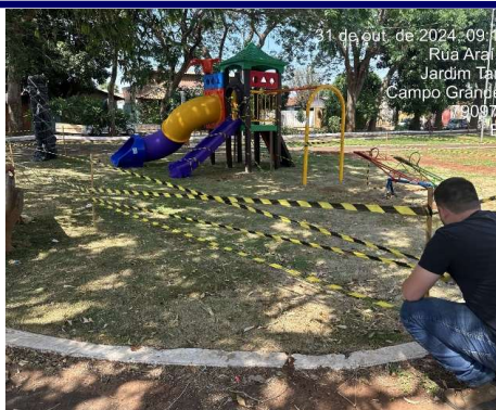
FOTO 32: 31/10/2024 – Término da montagem do playground e área isolada
