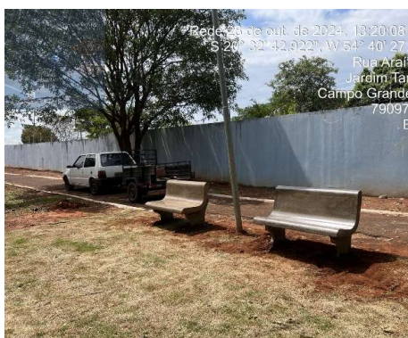
FOTO 12: 28/10/2024 – Serviço de instalação dos bancos de concreto
