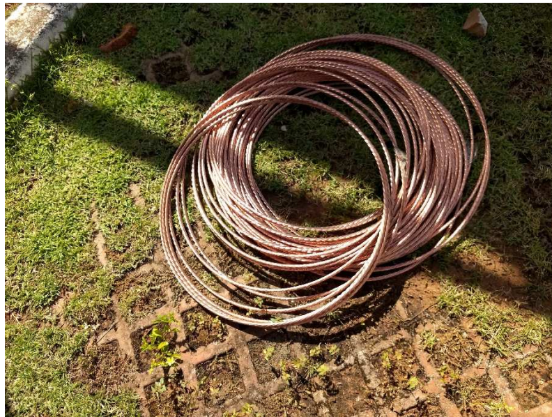
Cabo de cobre nu de 35 e 50mm 2 e escavação de vala para o SPDA
