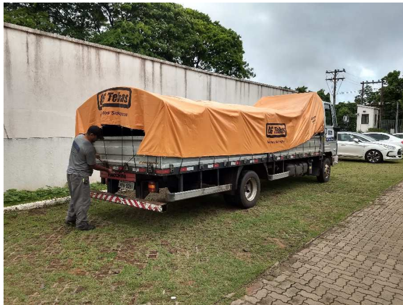
Mobilização de Canteiro de obra
