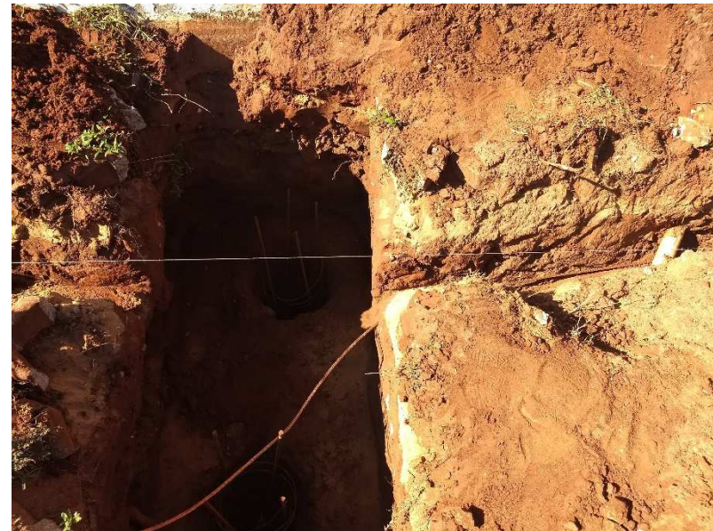
Cabo de cobre nu de 35 e 50mm 2 e escavação de vala para o SPDA
