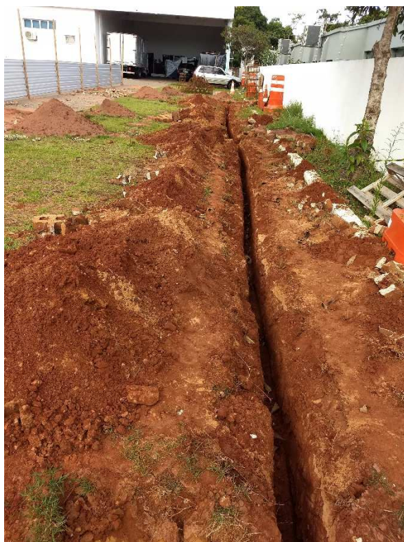
Vala para o SPDA, conector ou terminal para cabo com parafuso
