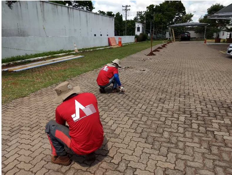
Execução dos Tapumes
