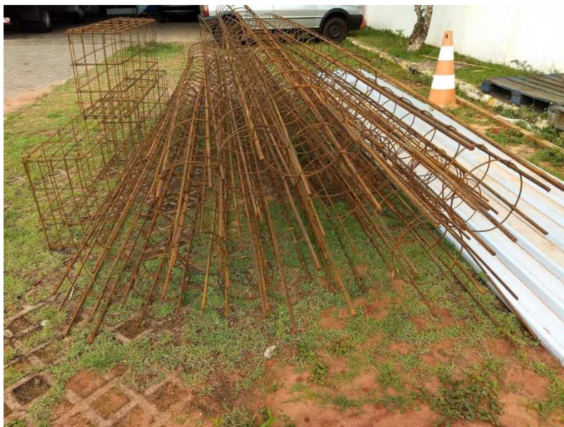
Detalhes das armaduras das estacas e dos blocos de transição
