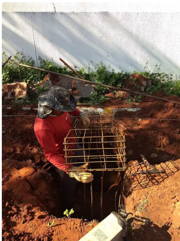
Detalhes da instalação das ferragens dos blocos e do posicionamento do chumbador
