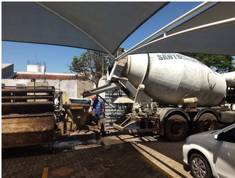
Detalhe da bomba e do caminhão betoneira lacrado
