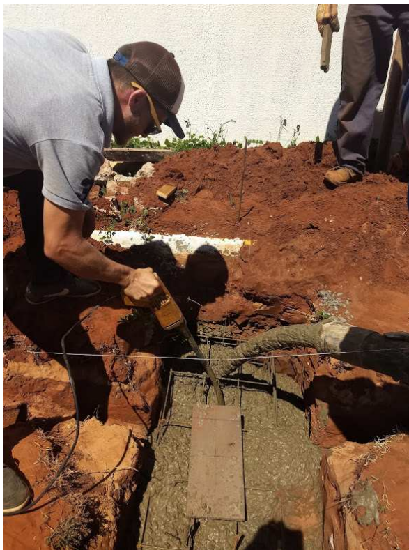
Detalhe do lançamento e vibração do concreto na fundações
