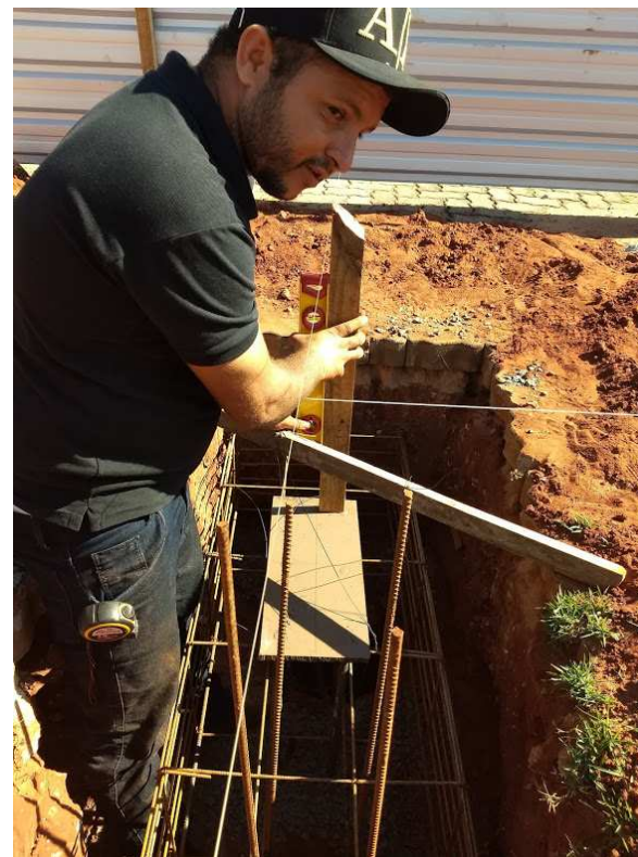
Detalhes da instalação das ferragens dos blocos e do posicionamento do chumbador
