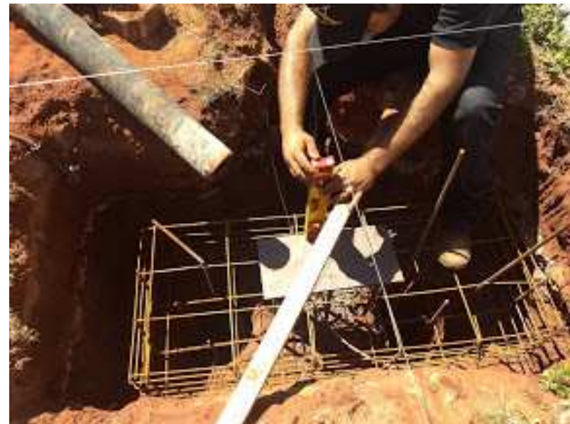
Detalhes dos chumbadores e da conferência dos eixo dos pilares no chumbador
