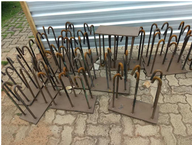
Detalhes dos chumbadores e da conferência dos eixo dos pilares no chumbador
