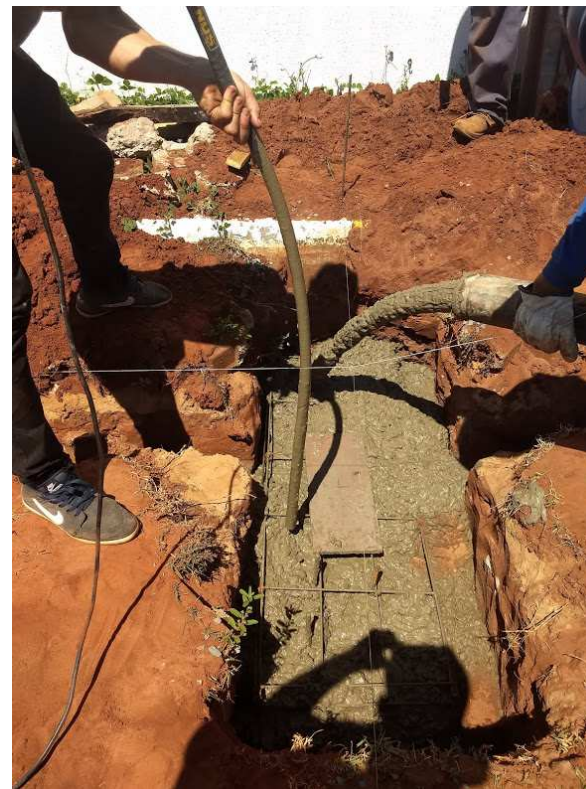
Detalhe do lançamento e vibração do concreto na fundações
