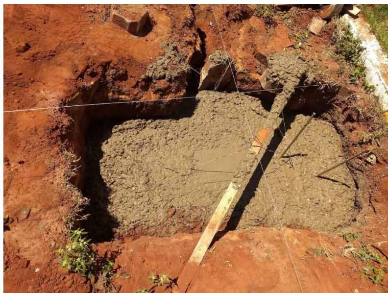
Detalhe do bloco concretado e da especificação do concreto usinado
