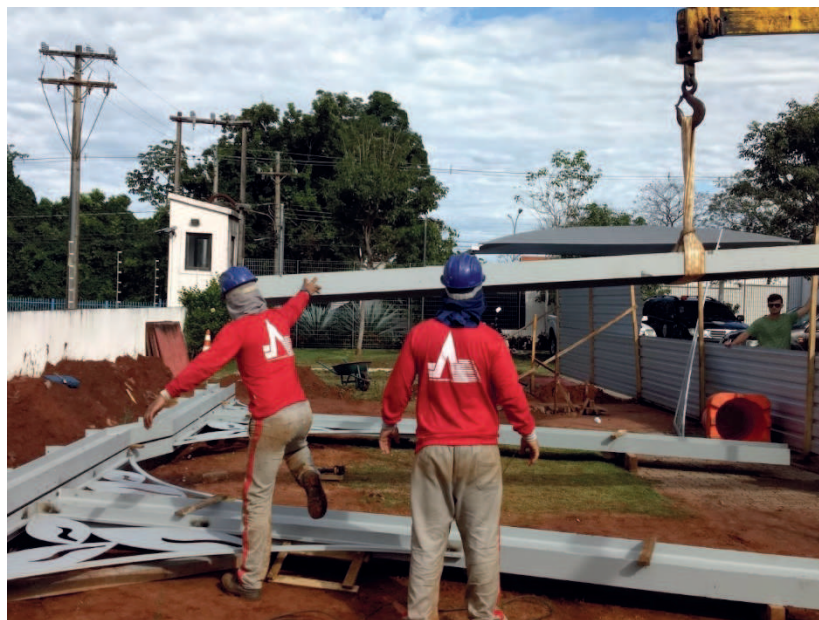
Detalhe da montagem dos pórticos no chão
