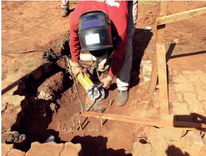
Detalhe da preparação da base para soldagem
