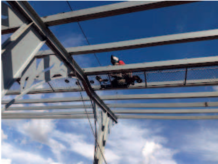
Detalhe do terçamento
