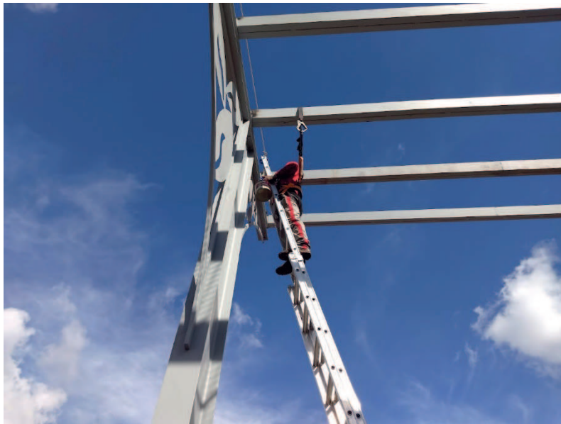
Detalhe da pintura da estrutura
