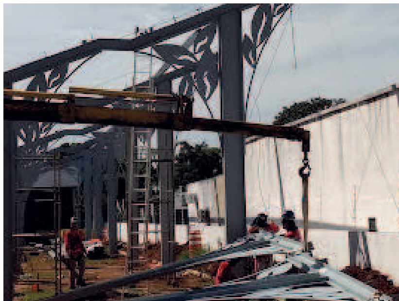
Detalhe do içamento e instalação dos pórticos
