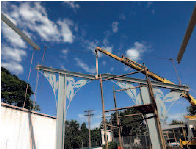
Detalhe do posicionamento dos pórticos
