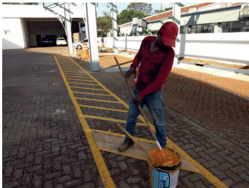
Detalhe da pintura de sinalização horizontal e dos tachões refletivos
