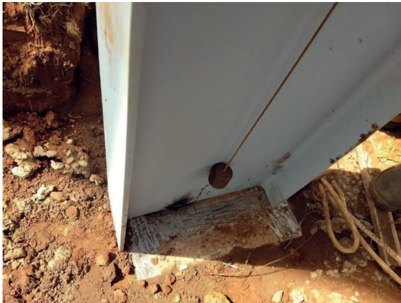
Detalhe da conferência do prumo e soldagem dos pórticos
