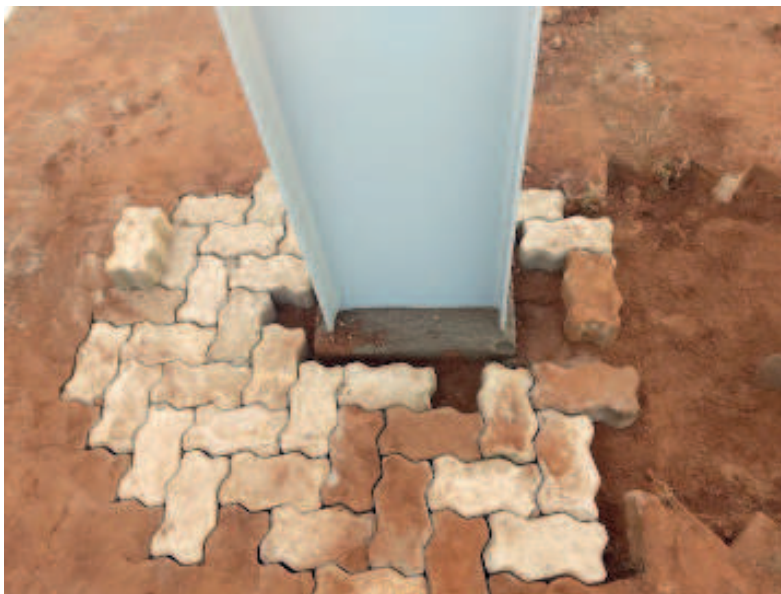
Detalhes da recomposição do piso intertravado e do piso-grama
