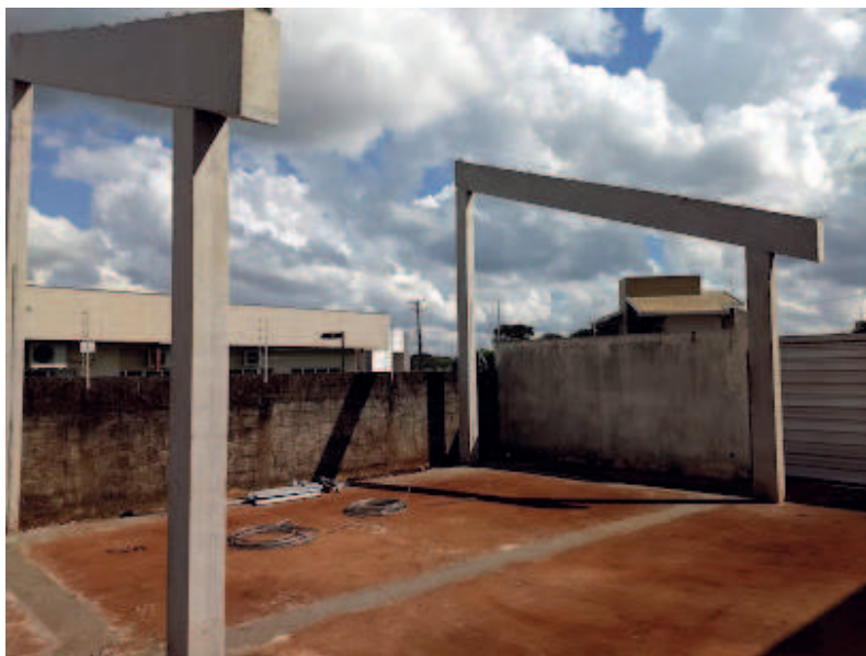
Detalhe das vigas pré-moldadas conferindo os pórticos
