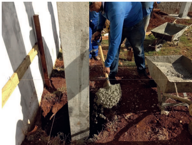
Detalhe da concretagem e da compactação da base do pilar
