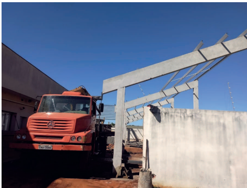
Detalhe do terçamento
