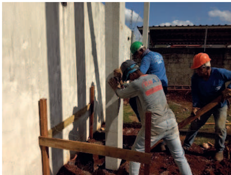
Detalhe da instalações dos pilares e conferência de prumo
