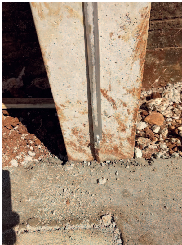
Detalhes das descidas com chapas de alumínio e da caixa de passagem da malha de aterramento
