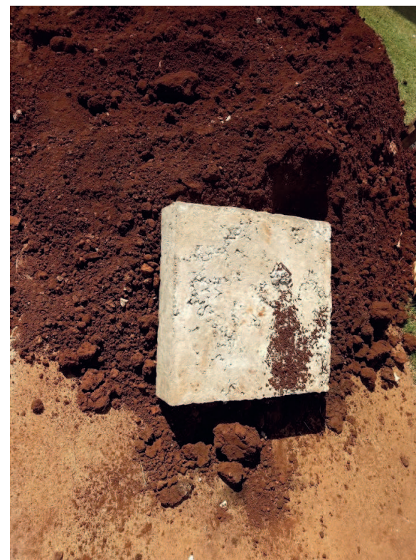
Detalhes das bases ou camas dos pilares pré-moldados
