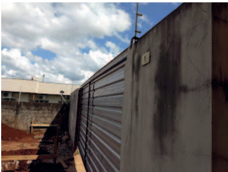
Detalhes do portão provisório e locação das fundações
