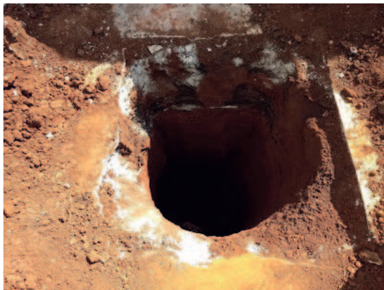
Detalhes da escavação e das fundações
