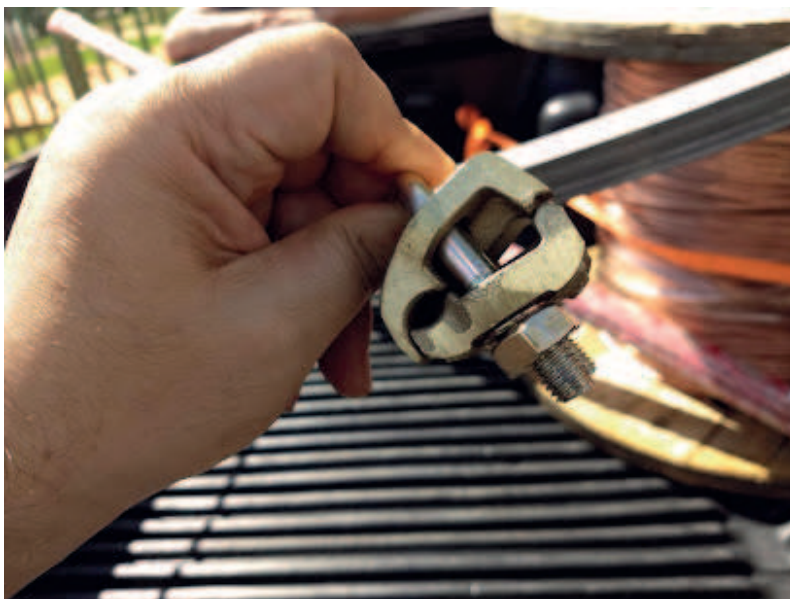
Detalhes das conexões do SPDA
