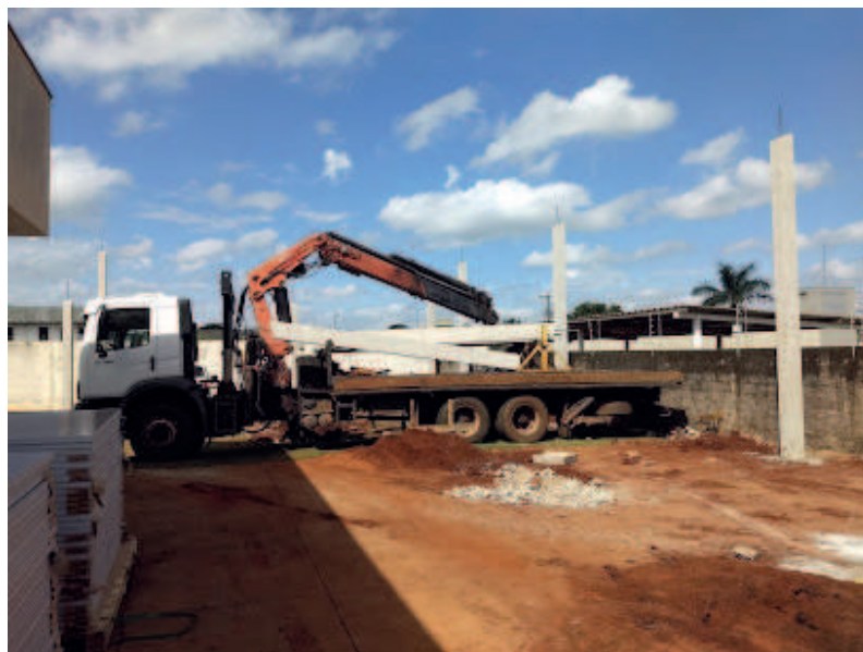
Detalhe do içamento e posicionamento dos pilares pré-moldados
