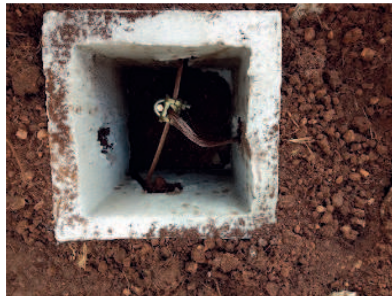
Detalhes das descidas com chapas de alumínio e da caixa de passagem da malha de aterramento
