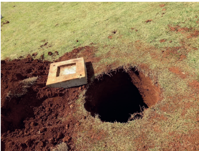
Detalhes das bases ou camas dos pilares pré-moldados
