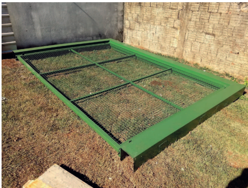
Detalhes do portão adaptado e do terçamento e estrutura concluídos
