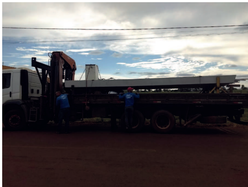
Detalhe do caminhão com munk e parte dos pilares pré-moldados
