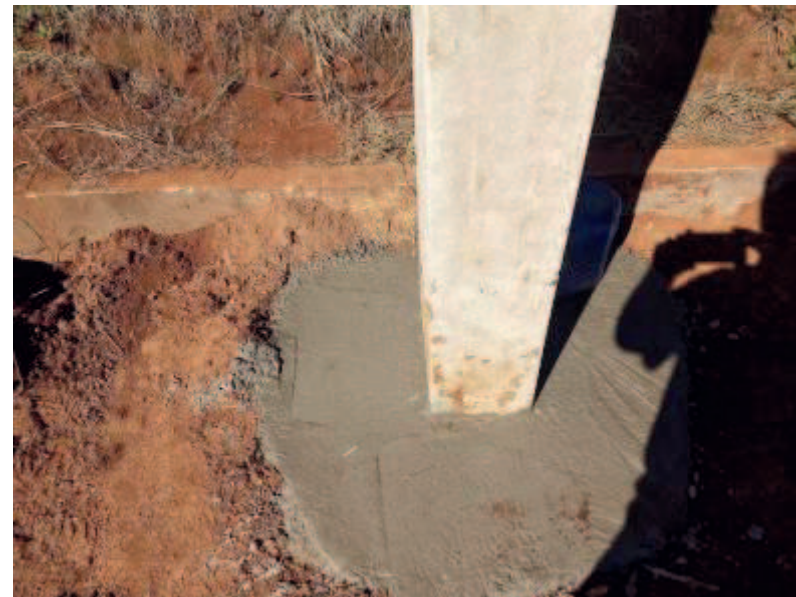
Detalhe da fixação dos pilares (aterramento, compactação e concretagem)
