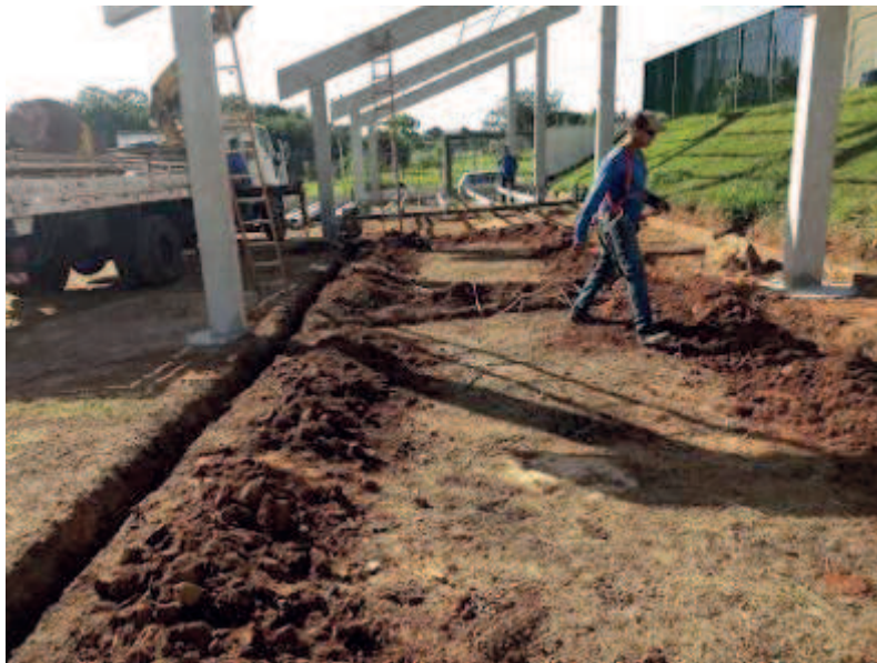
Abertura de valetas para o SPDA e detalhe dos materiais na obra
