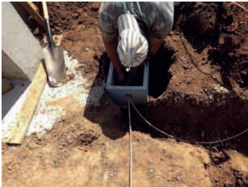
Detalhe das caixas de passagens e dos conectores nos cabos de cobre nu
