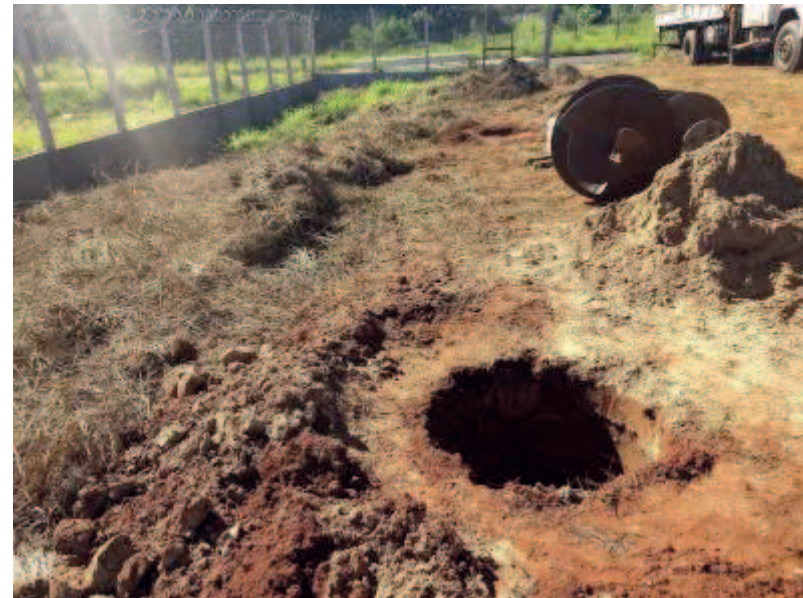
Detalhes das brocas, base de concreto e estaca escavada das fundações
