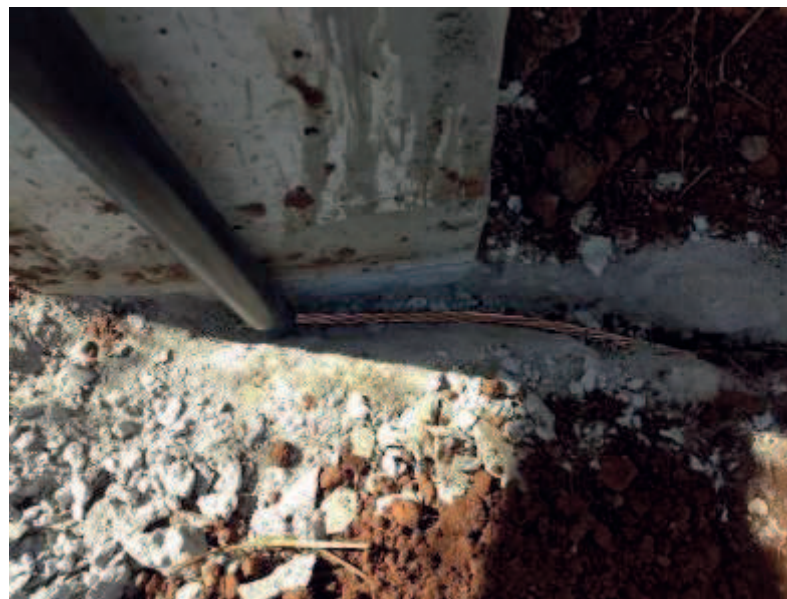
Detalhe da infraestrutura do aterramento nos pilares e a sua conexão nas caixas de passagens
