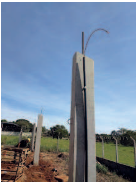
Detalhe da infraestrutura do aterramento nos pilares e a sua conexão nas caixas de passagens
