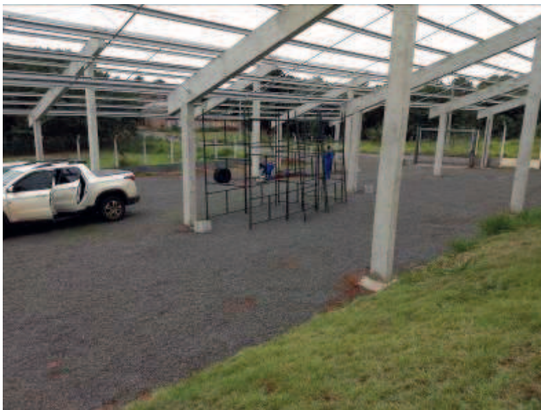
Detalhes da camada drenante com brita 3, regularizada com “bobcat”
