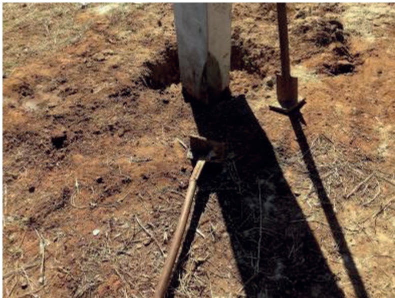
Detalhe da fixação dos pilares (aterramento, compactação e concretagem)
