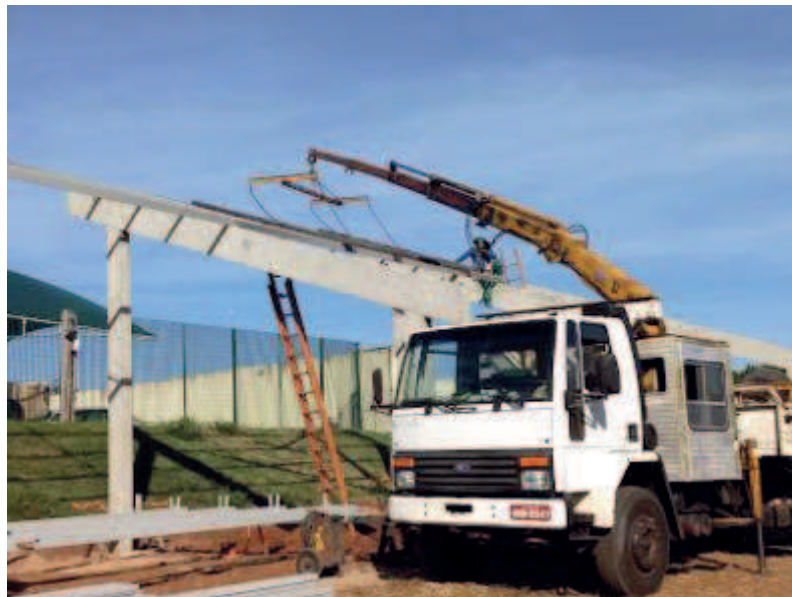
Detalhe do terçamento
