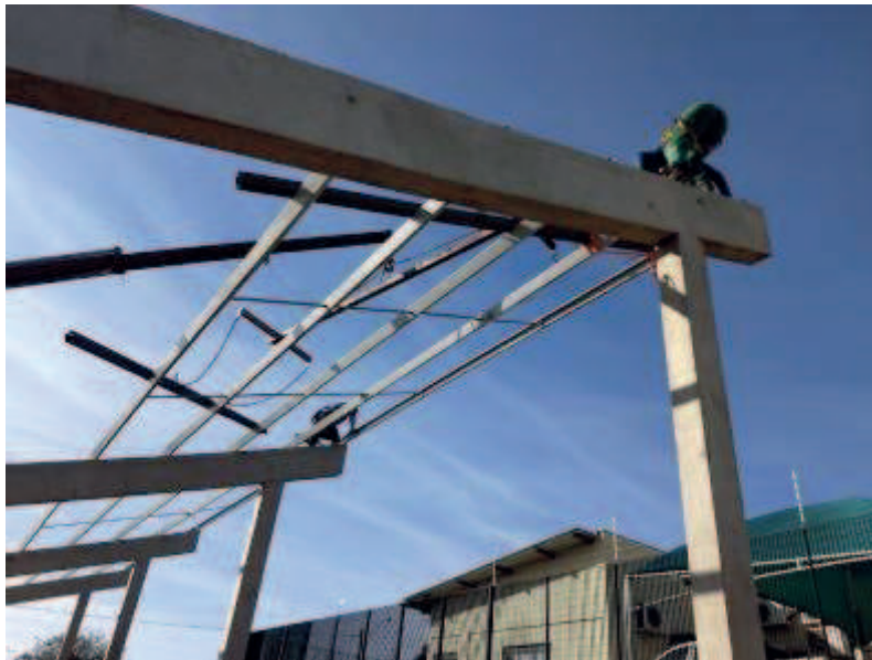
Detalhe da pintura das terças
