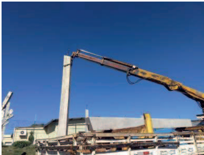
Detalhe do içamento da estrutura e do seu posicionamento
