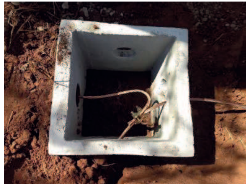
Detalhe das caixas de passagens e dos conectores nos cabos de cobre nu
