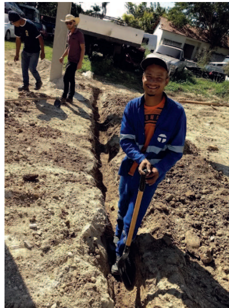
Detalhes da valeta, lançamento dos cabos de cobre nú e hastes de aterramento com conector
