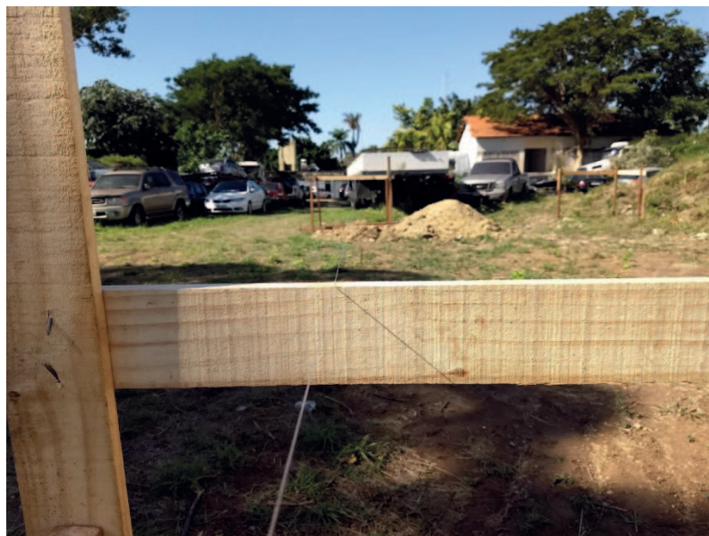
Detalhe da locação (linha de eixo das fundações) e instalação do portão provisório
