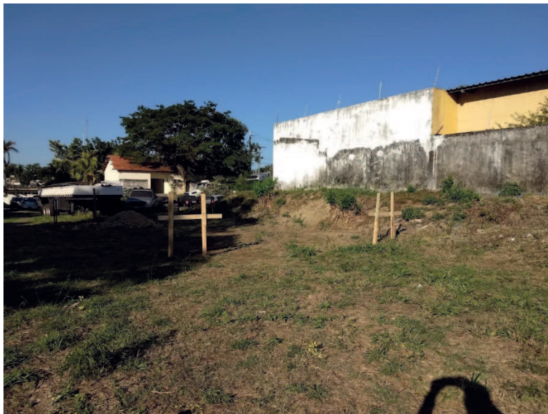
Detalhe da locação da obra, gabarito e estaqueamento
