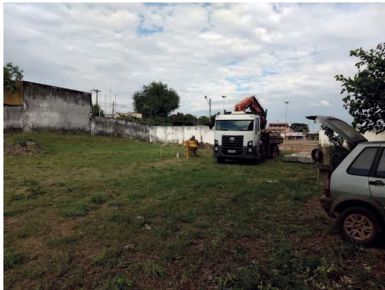
Detalhe da mobilização de máquina e mão de obra
