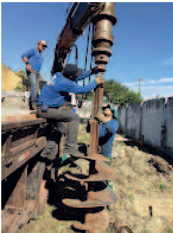
Detalhe da montagem da perfuratriz e início das perfurações
