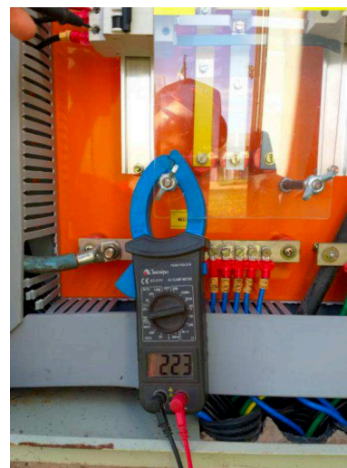
Medida realizada no novo disjuntor (Tensão Fase Fase): Tensão dentro do padrão (223 V)
