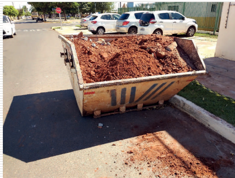
Aluguel de caçamba para retirada de entulho.
