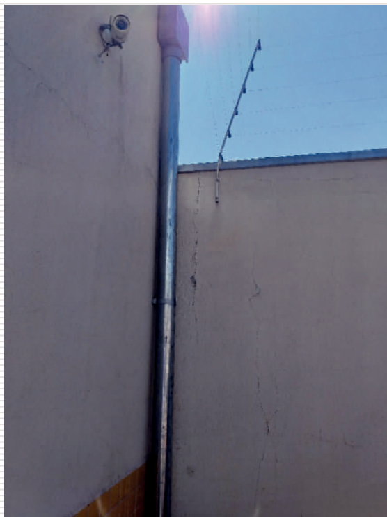
Detalhe da infraestrutura de interligação dos painéis com os inversores
