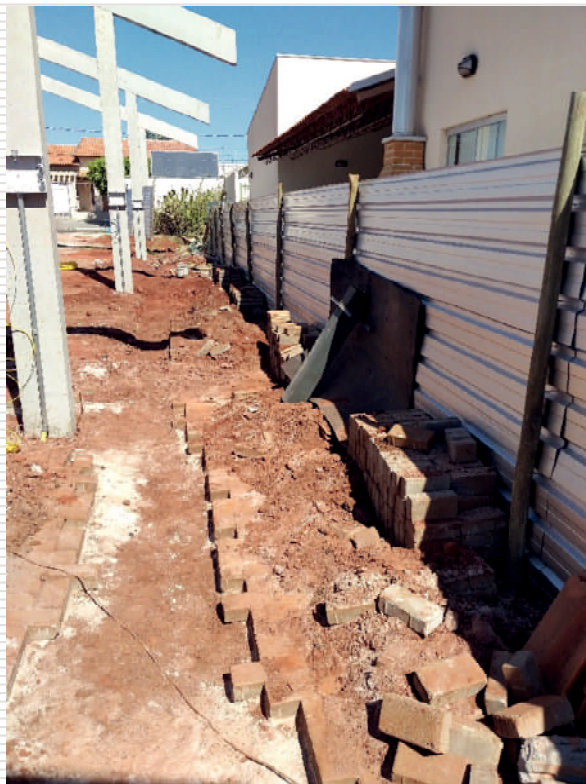
Detalhe da demolição e reaproveitamento do pavimento intertravado (subitem 8.5)
