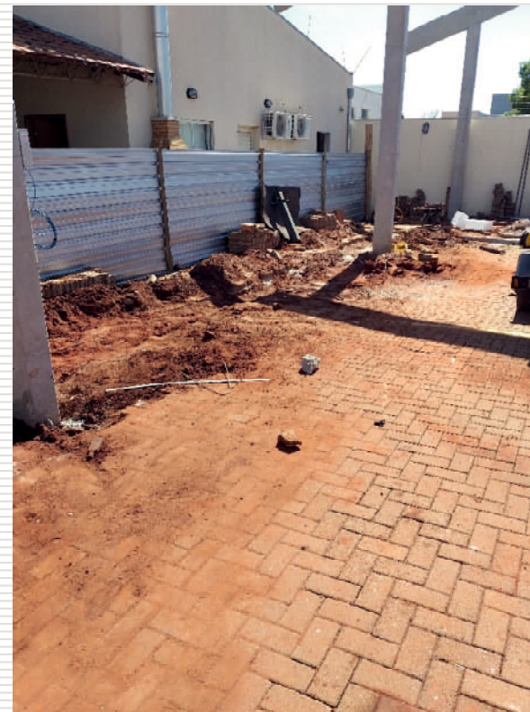
Detalhe da demolição e reaproveitamento do pavimento intertravado (subitem 8.5)
