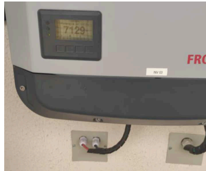
1.1 Detalhe da instalação das inversoras da marca Fronius
