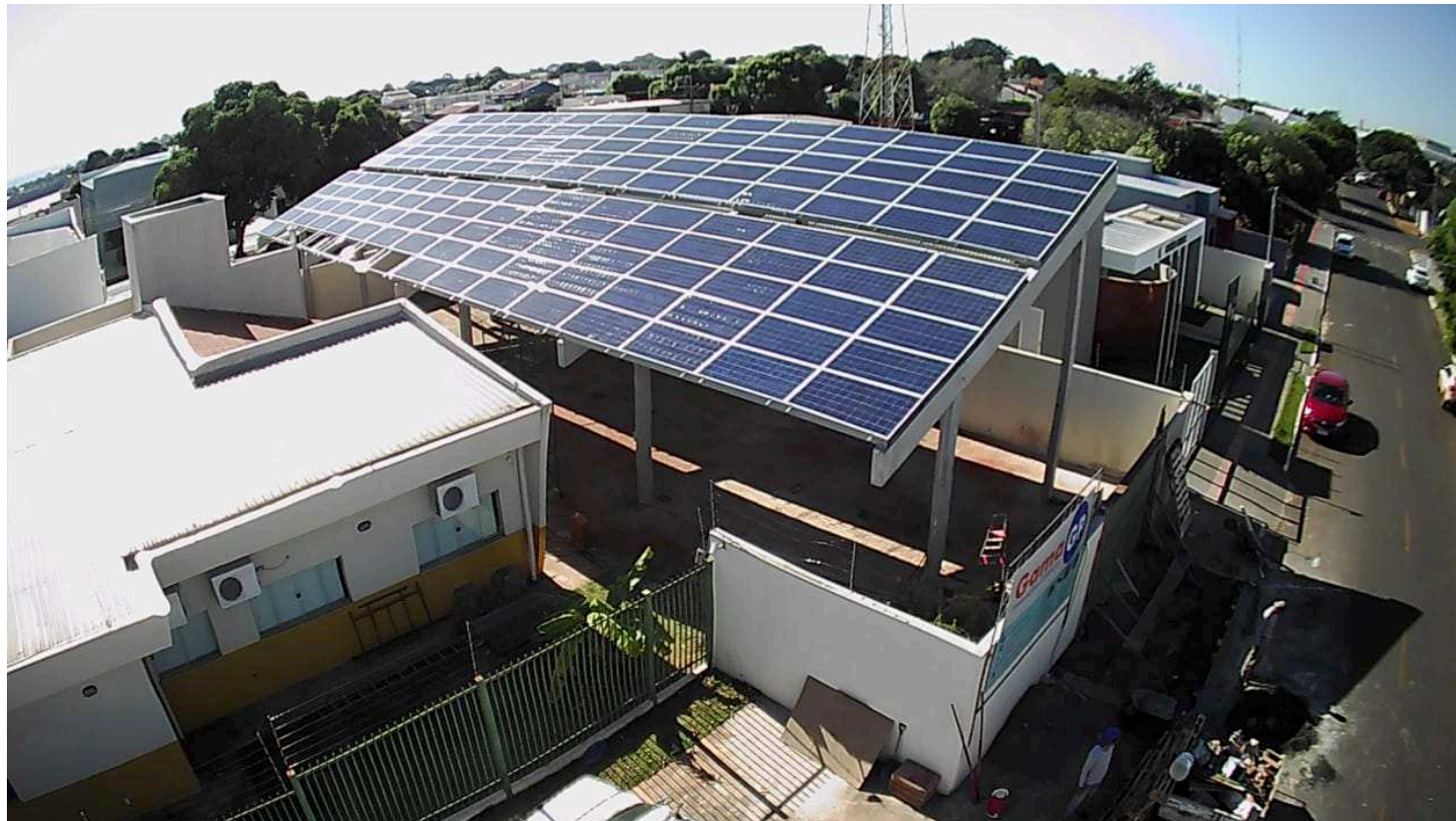
1.2 montagem dos painéis solares concluídos
