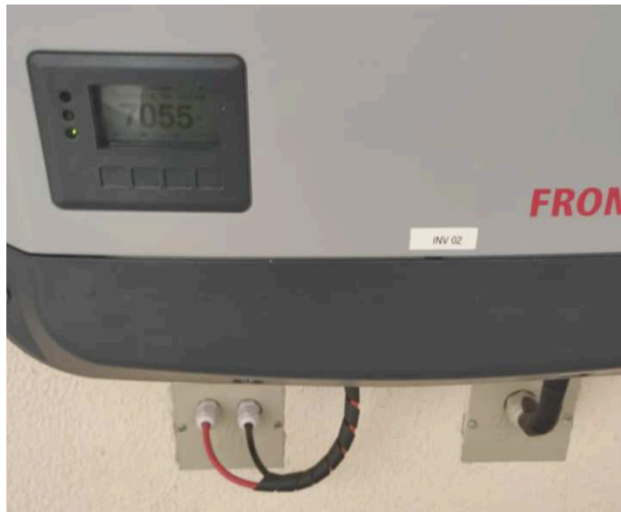
1.1 Detalhe da instalação das inversoras da marca Fronius
