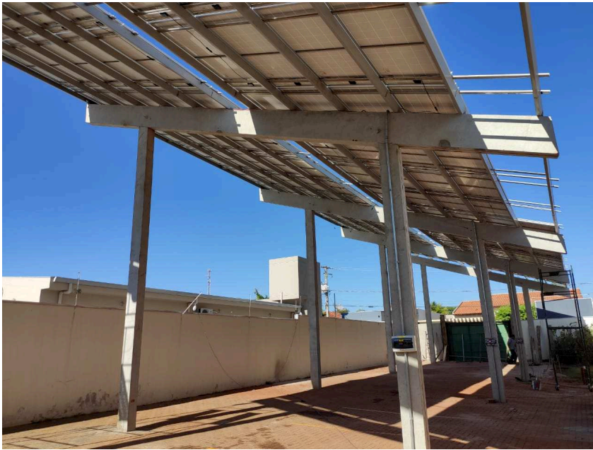
3.1 Detalhe do "stringbox" concluído
