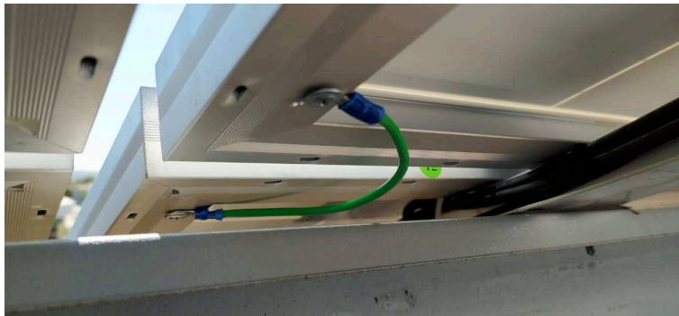
Detalhe do aterramento dos painéis
