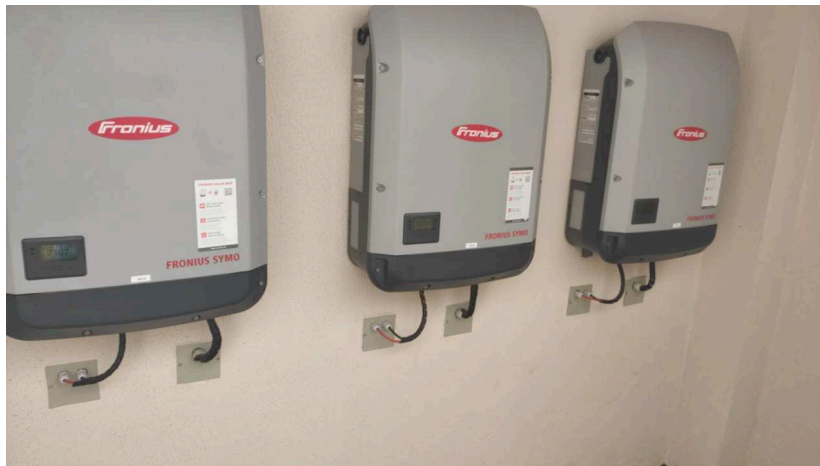
1.1 Detalhe da instalação das inversoras da marca Fronius
