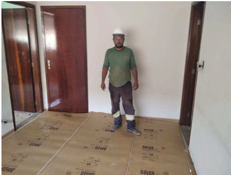
Detalhe da instalação do salva piso e do encarregado da obra. Ao lado as calhas retiradas.
