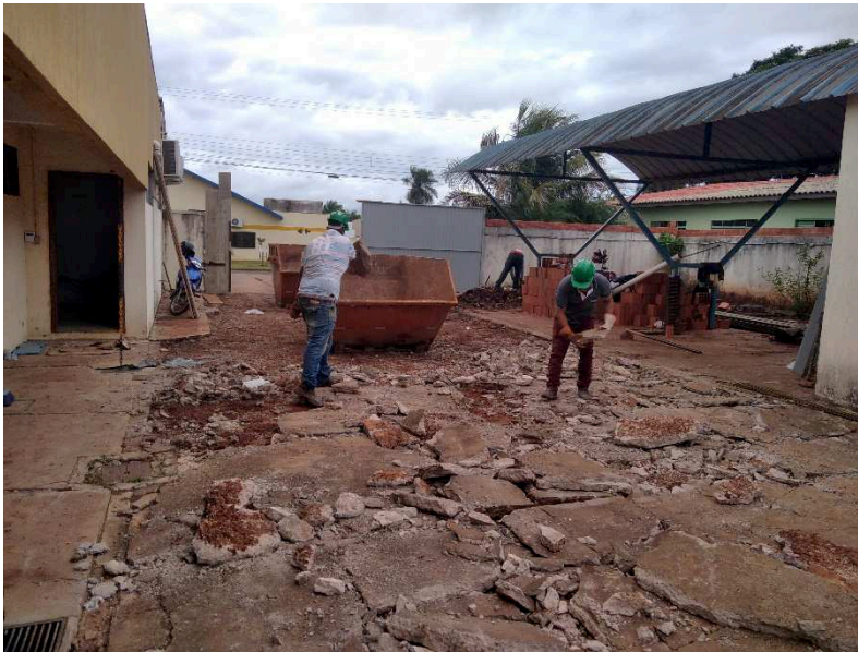
Detalhes das caçambas, demolição do piso de concreto, limpeza do corredor lateral, retirada de árvores e material lenhoso.
