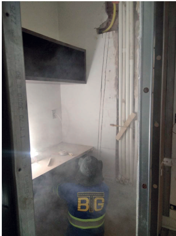
Detalhe da ampliação da infraestrutura para o novo rack.
