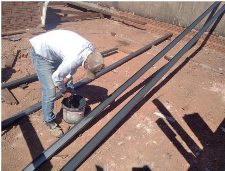
Pintura da estrutura com fundo antioxidação e início da montagem das tesouras
