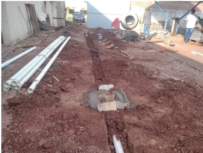
Detalhe da caixa de passagem e do rasgo na rampa de concreto para a ampliação do sistema de drenagem
