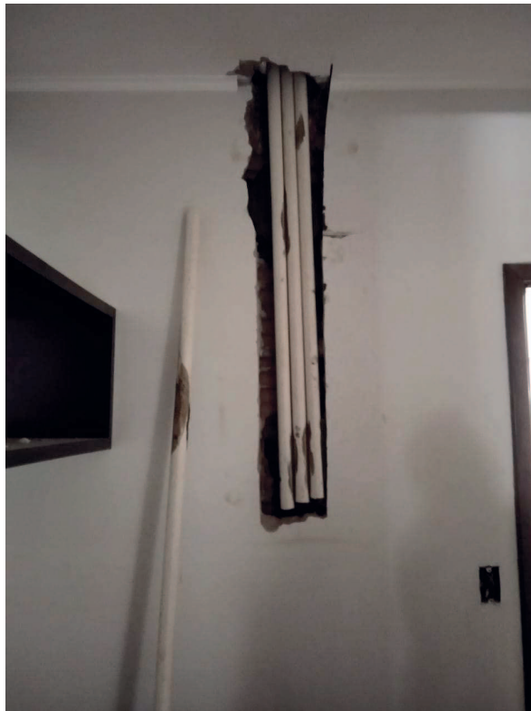
Detalhe da nova infra de lógica e a reinstalação do Rack com seus ativos
