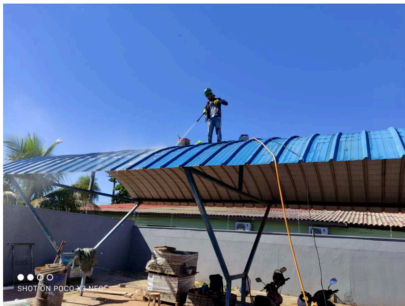
Lavagem do telhado do estacionamento com jato de pressão
