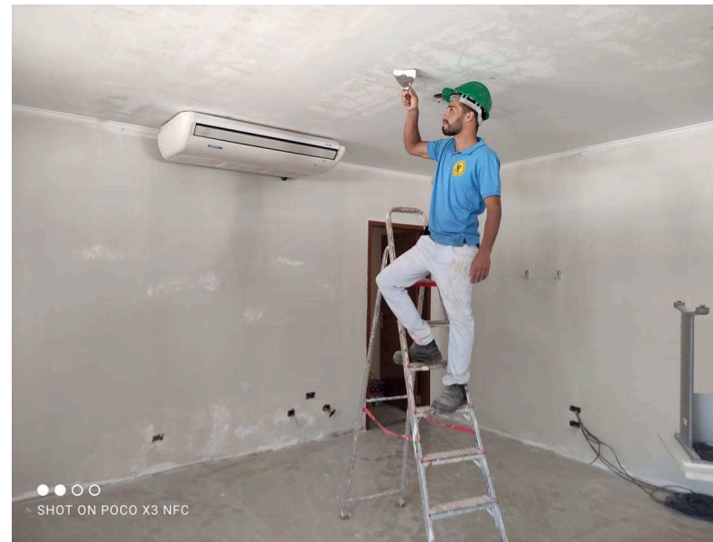
Detalhe do emassamento interno
