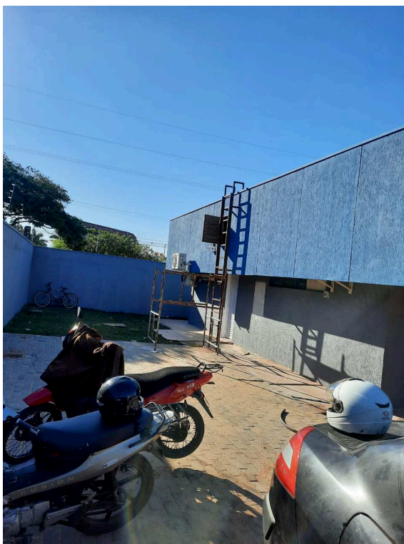
Detalhe da pintura externa do fundo e do piso ecológico intertravado
