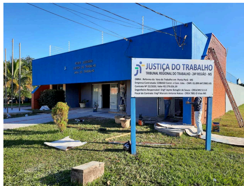
Detalhe da pintura externa
