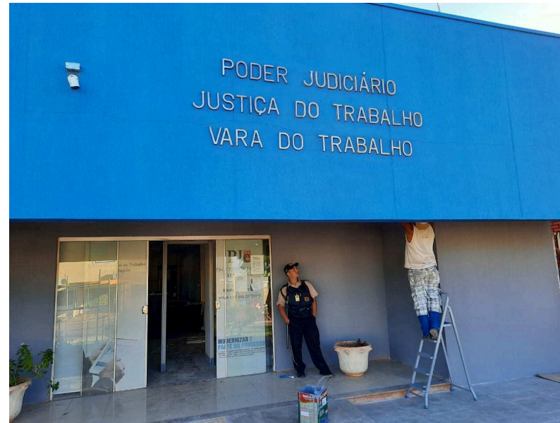
Detalhe da pintura externa
