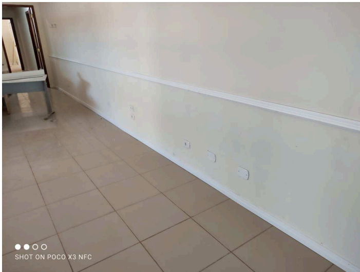
Detalhe do rodameio e rodapé instalados e as paredes internas pintadas
