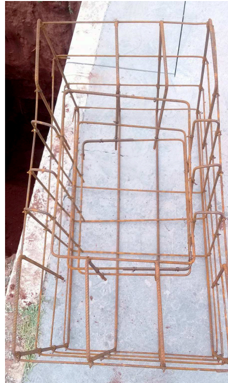
ARMAÇÃO DE BLOCO, VIGA BALDRAME OU SAPATA UTILIZANDO AÇO CA-50 DE 8 MM - MONTAGEM. AF_06/2017
