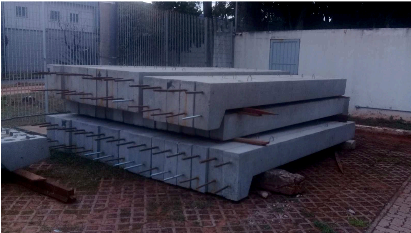
FORNECIMENTO E MONTAGEM DE ESTRUTURAS PRÉ-MOLDADAS DE CONCRETO
