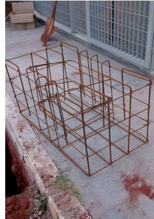
ARMAÇÃO DE BLOCO, VIGA BALDRAME OU SAPATA UTILIZANDO AÇO CA-50 DE 8 MM - MONTAGEM. AF_06/2017
