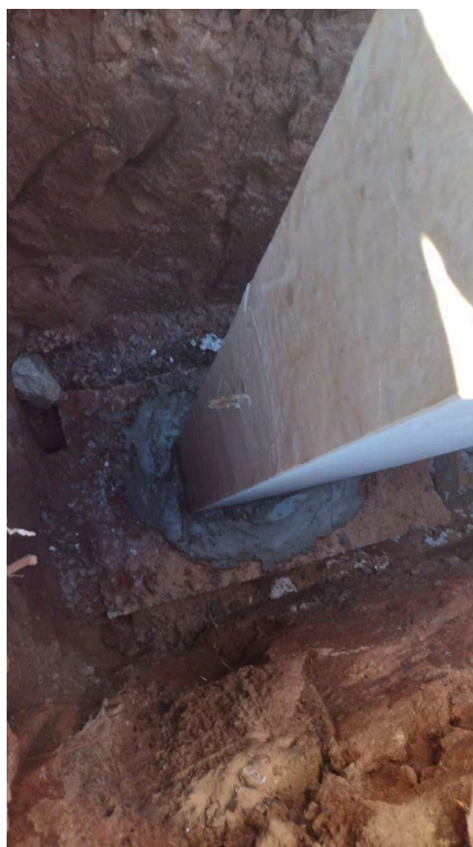
ESTACA BROCA DE CONCRETO, DIÂMETRO DE 20CM, ESCAVAÇÃO MANUAL COM TRADO CONCHA, COM ARMADURA DE ARRANQUE. AF_05/2020
