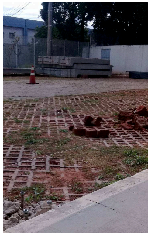
DEMOLIÇÃO DE PAVIMENTO INTERTRAVADO
