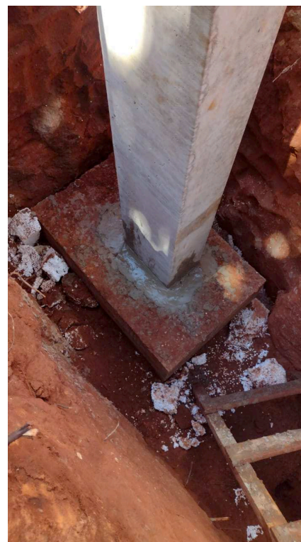
ESTACA BROCA DE CONCRETO, DIÂMETRO DE 20CM, ESCAVAÇÃO MANUAL COM TRADO CONCHA, COM ARMADURA DE ARRANQUE. AF_05/2020
