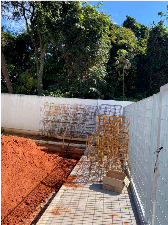
ARMAÇÃO DE BLOCO, VIGA BALDRAME OU SAPATA UTILIZANDO AÇO CA-50 DE 8 MM - MONTAGEM. AF_06/2017
