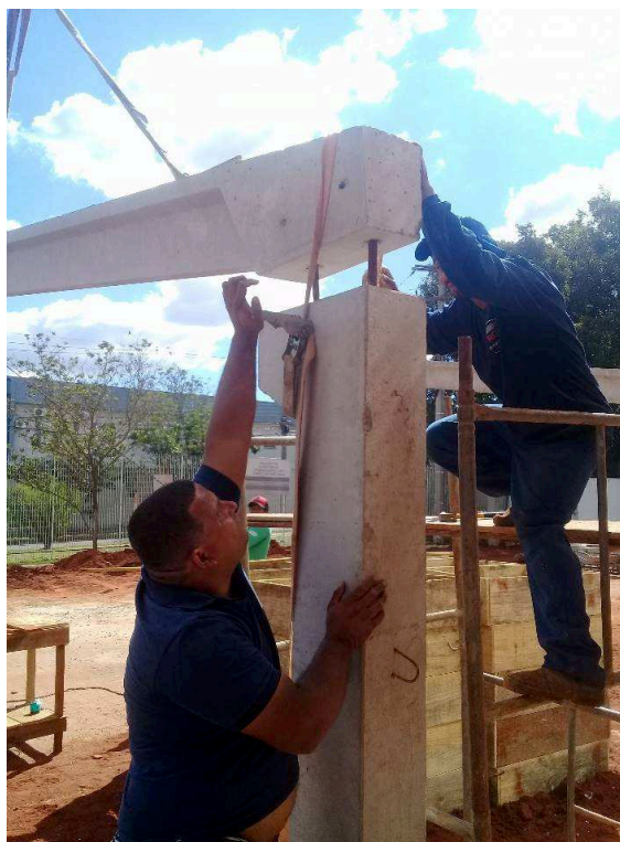
Na foto, engenheiro civil Paulo visitando a obra
