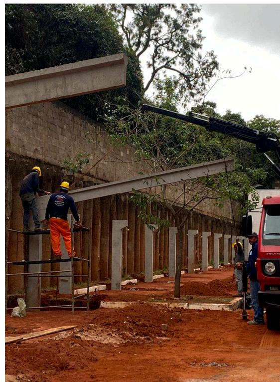
FORNECIMENTO E MONTAGEM DE ESTRUTURAS PRÉ-MOLDADAS DE CONCRETO ARMADO, 9.98 X 30.28M. INCLUSIVE TRANSPORTE, MOBILIZAÇÕES, FUNDAÇÕES E TERÇAS METÁLICAS 127X50X20 – ENRIJECIDAS – CHAPA 13 – FUNDO OXIDO, CONFORME ORÇAMENTOS
