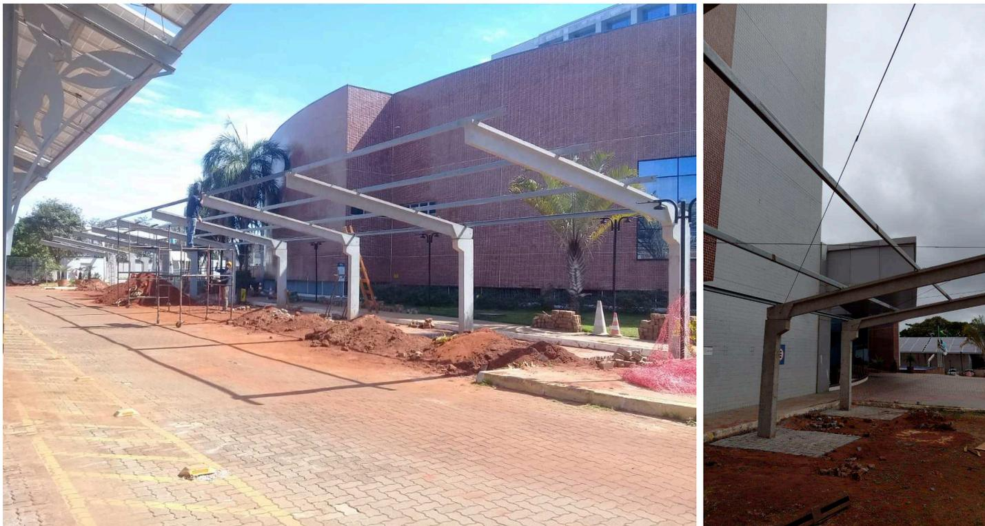
FORNECIMENTO E MONTAGEM DE ESTRUTURAS PRÉ-MOLDADAS DE CONCRETO ARMADO, 9.98 X 30.28M. INCLUSIVE TRANSPORTE, MOBILIZAÇÕES, FUNDAÇÕES E TERÇAS METÁLICAS 127X50X20 – ENRIJECIDAS – CHAPA 13 – FUNDO OXIDO, CONFORME ORÇAMENTOS
