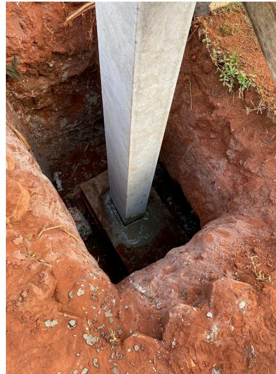
ESTACA BROCA DE CONCRETO, DIÂMETRO DE 20CM, ESCAVAÇÃO MANUAL COM TRADO CONCHA, COM ARMADURA DE ARRANQUE. AF\_05/2020
