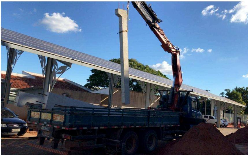
CARGA, MANOBRA E DESCARGA DE POSTE DE CONCRETO EM CAMINHÃO CARROCERIA COM GUINDAUTO (MUNCK) 11,7 TM. AF\_07/2020
