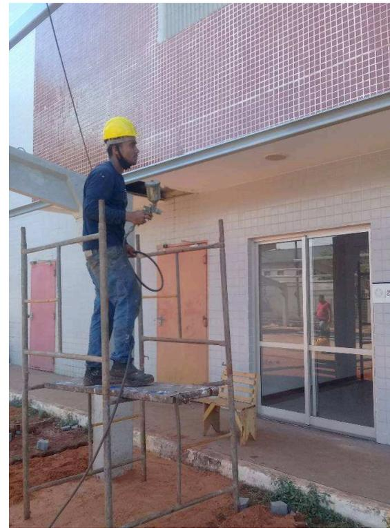
LOCAÇÃO DE ANDAIME METALICO TUBULAR DE ENCAIXE, TIPO DE TORRE, COM LARGURA DE 1 ATE 1,5 M E ALTURA DE \*1,00\* M
