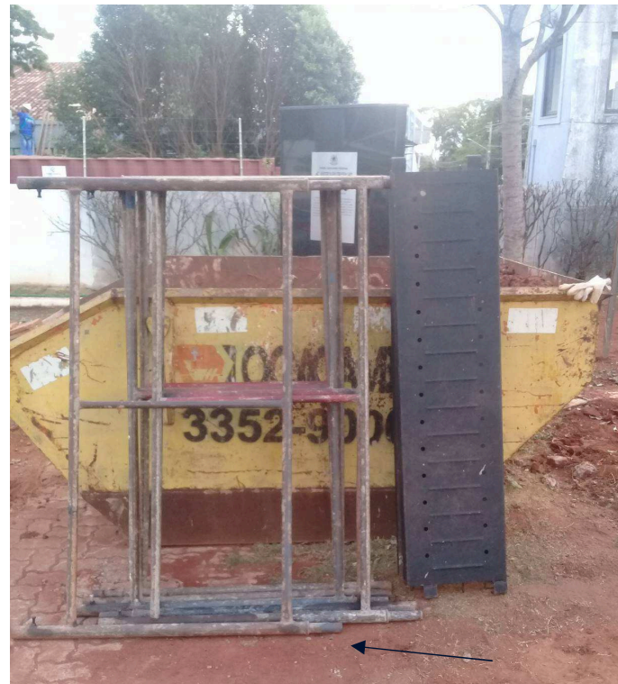
MONTAGEM E DESMONTAGEM DE ANDAIME TUBULAR TIPO TORRE (EXCLUSIVE ANDAIME E LIMPEZA). AF_11/2017
