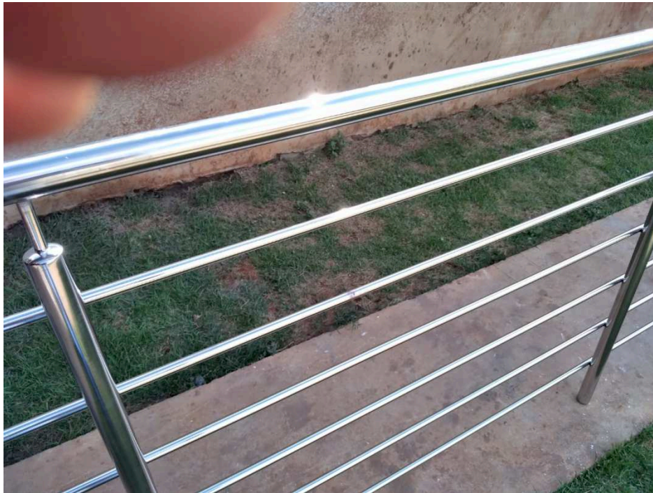
Detalhe do guarda corpo e corrimão
