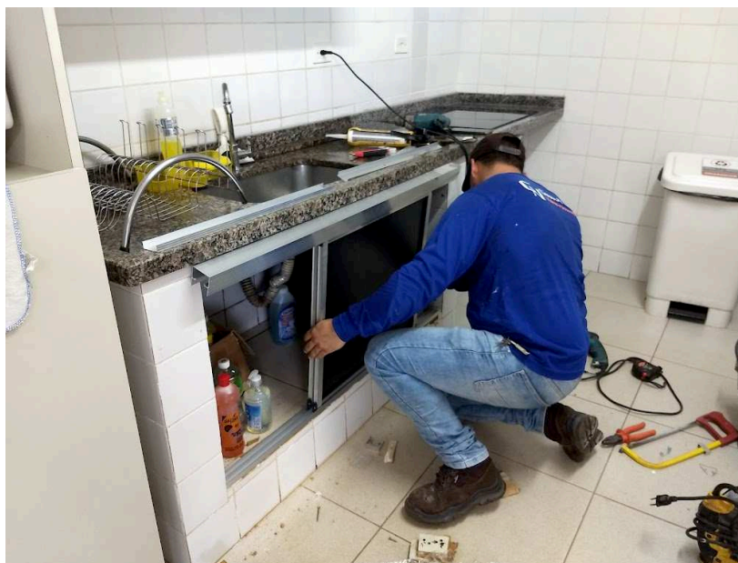
Detalhe da montagem das portas do armário e bancada de granito já com o fogão e forno elétrico instalados
