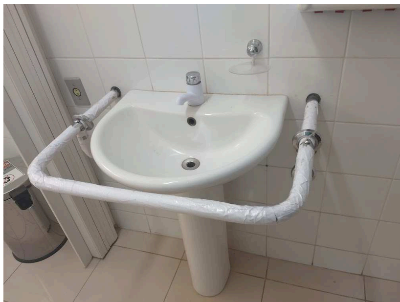
Detalhe do lavatório com barra de apoio no WC adaptado
