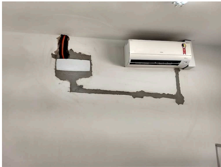
Detalhe da infraestrutura do ar condicionado com elétrica, tubulação frigorígena e caixa de passagem
