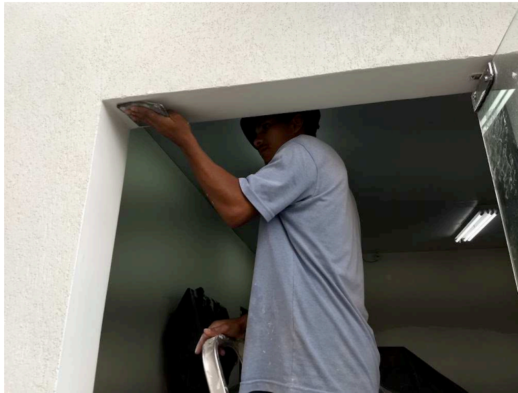
Emassamento e lixamento de pintura interna
