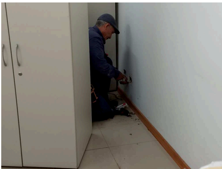
Detalhe de substituição de tomadas
