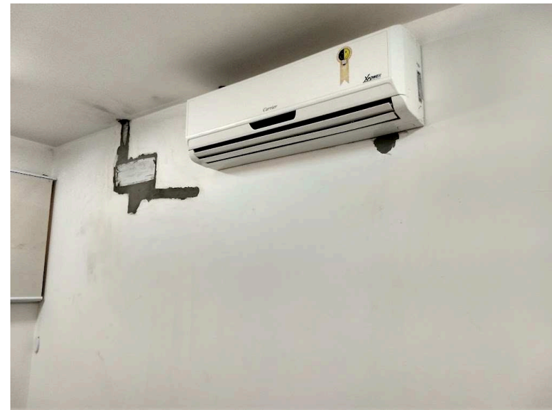
Detalhe da infraestrutura do ar condicionado com elétrica, tubulação frigorígena e caixa de passagem
