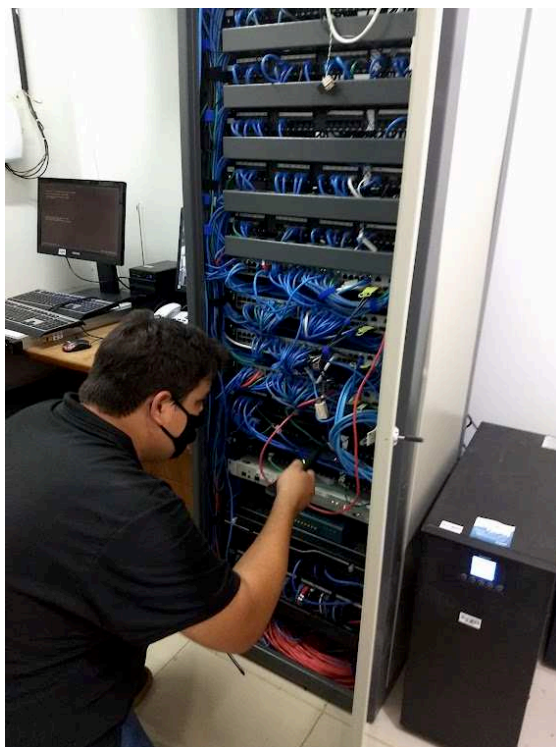
Detalhe da identificação e certificação dos novos pontos de lógica
