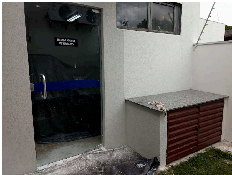
Detalhe da porta de vidro, mola, soleira de granito e abrigo da gás
