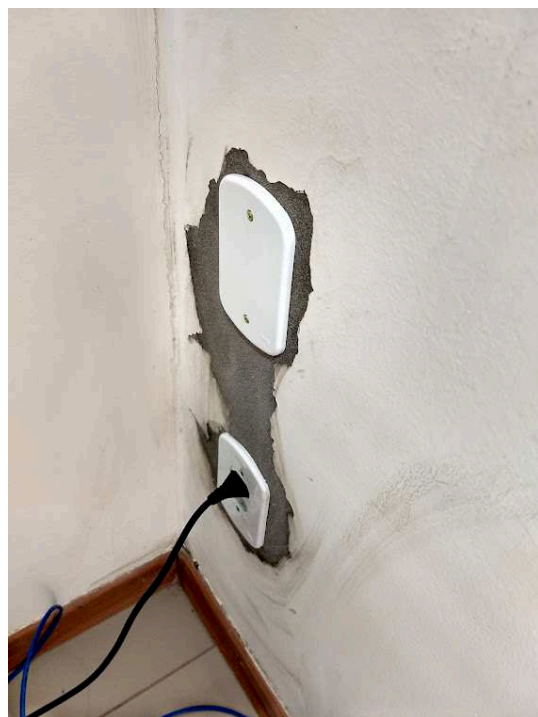
Detalhe de tomadas embutidas e substituídas
