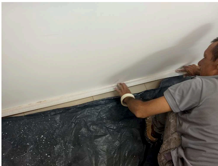
Detalhe do fitamento e do recorte para pintura
