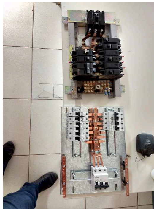
Detalhe do quadro antigo antes de ser trocado e do novo quadro a ser instalado
