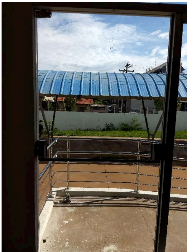
Detalhe da porta de vidro com fechadura antipânico e painel de vidro
