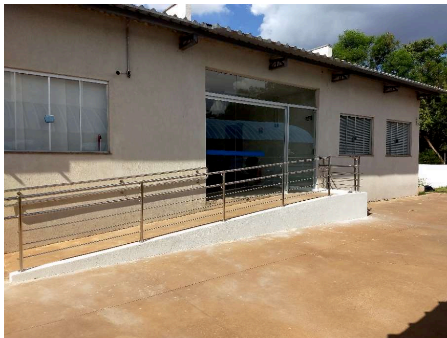
Detalhe dos guarda-corpos com corrimão nas rampas de rota de fuga
