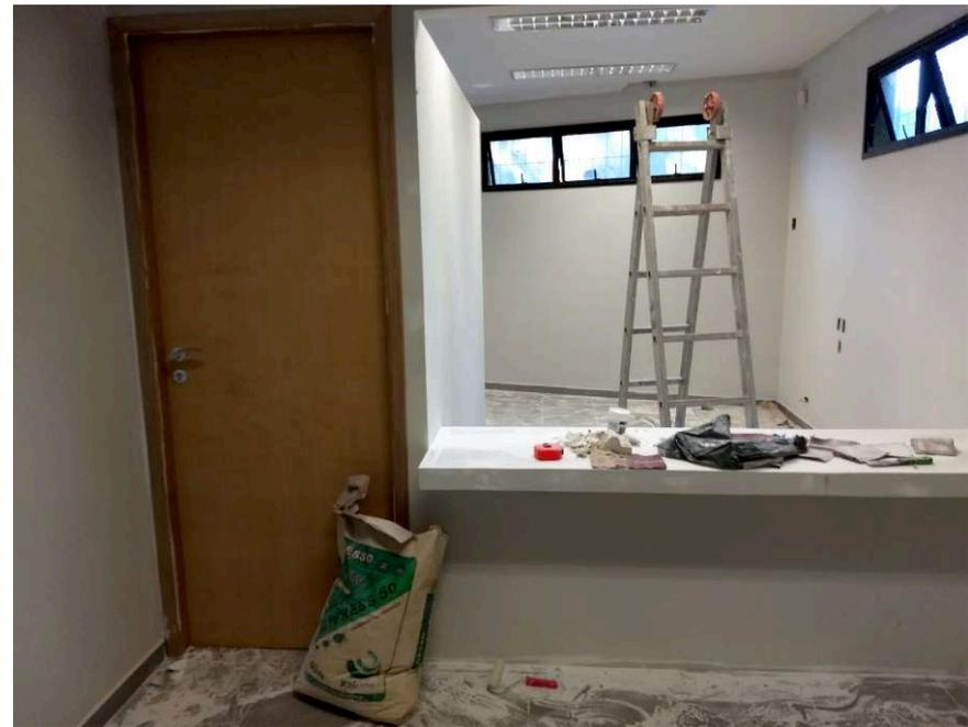
Detalhe da demolição de alvenaria e do balcão de gesso acartonado de dupla face
