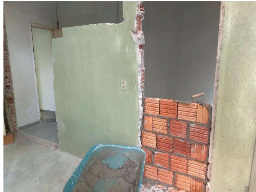
Detalhe de parede de gesso acartonado simples e alvenaria de bloco de oito furos
