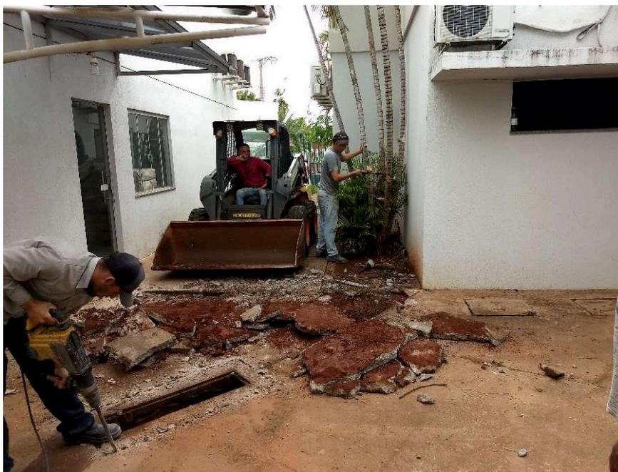
Retirada de calçamento de concreto para passagem da nova galeria de águas pluviais
