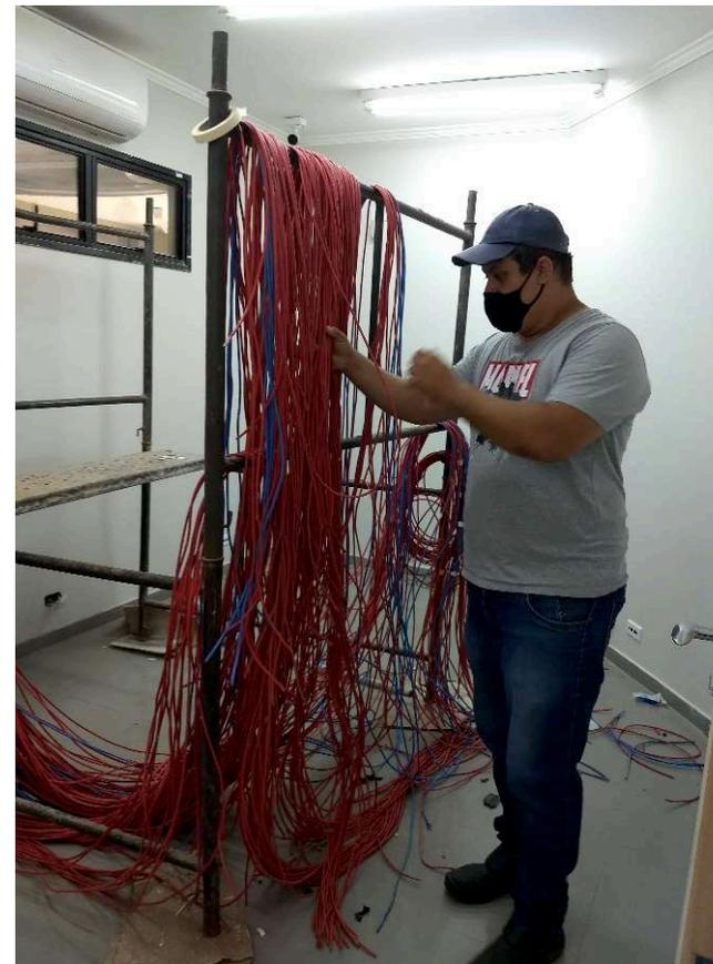
Detalhe de prumada e caixa de passagem de lógica e identificação dos cabos
