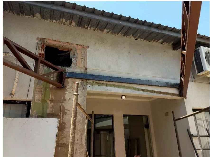
Detalhe da execução de treliça metálica e parte da estrutura montada com suporte metálico fixado com “parabolt”
