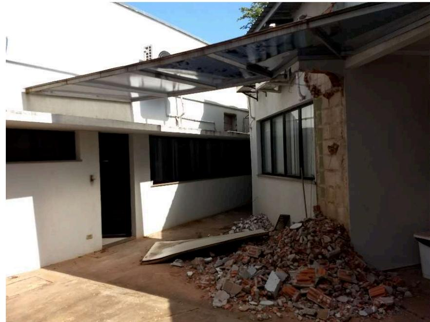
Demolição de caixa de ar condicionado e mudança de condensadora
