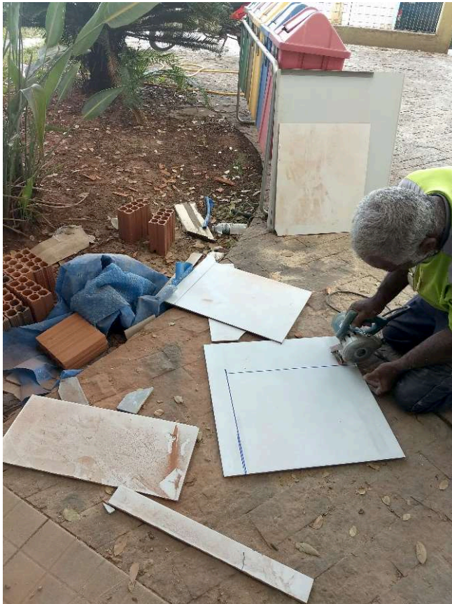
Detalhe do corte de cerâmica e o revestimento sendo aplicado no banheiro
