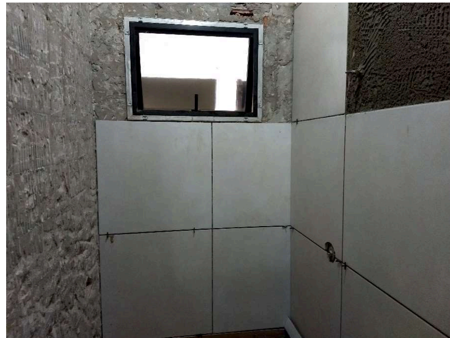
Detalhe do corte de cerâmica e o revestimento sendo aplicado no banheiro
