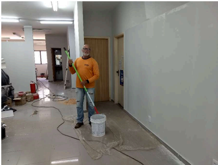
Detalhe da pintura e lixamento de parede
