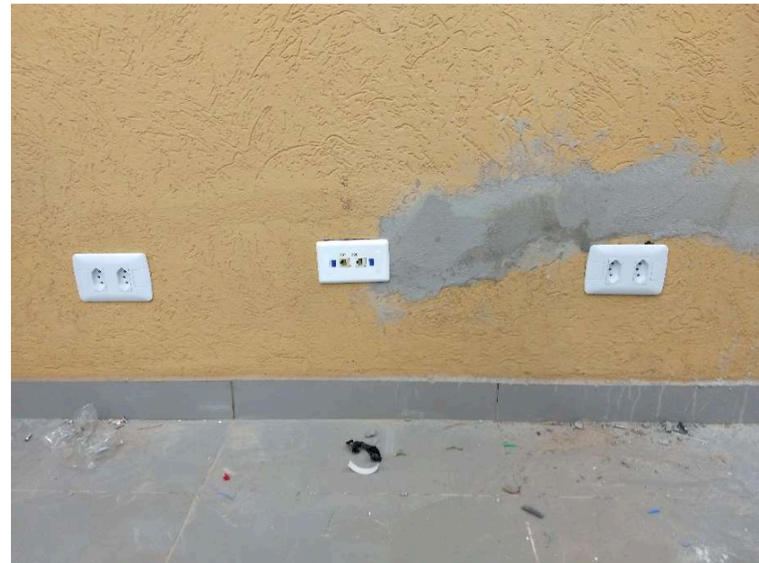
Detalhe das tomadas padrão brasileiro e das tomadas de lógica RJ45 Fêmea
