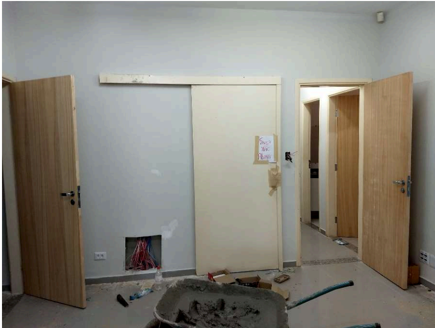
Detalhe de portas instaladas com as fechaduras de alavanca em alto tráfego
