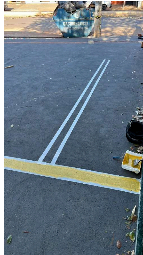
Detalhe de pintura e demarcação de piso com tinta epóxi.
