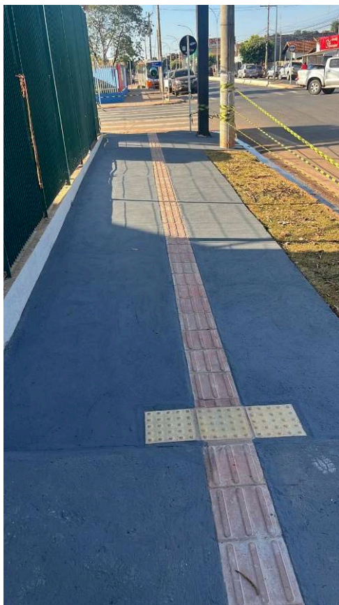
Detalhe do piso podotátil de concreto, assentado no passeio público.
