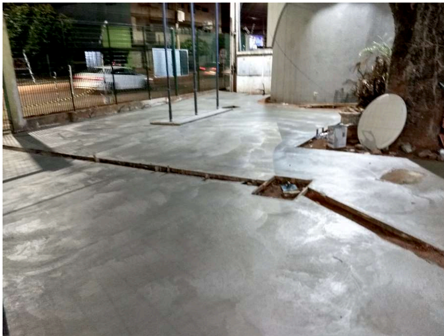
Detalhe do acabamento polido para piso de concreto.
