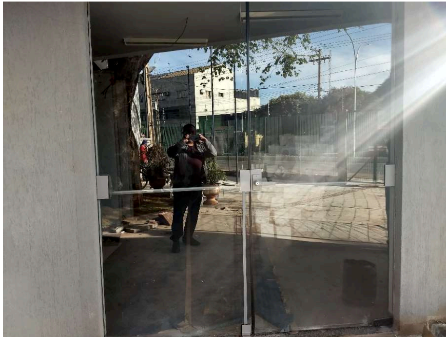
Detalhe da porta de abrir com mola hidráulica, em vidro temperado.
