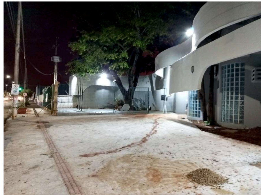
Detalhe da execução de passeio com concreto moldado "in loco".
