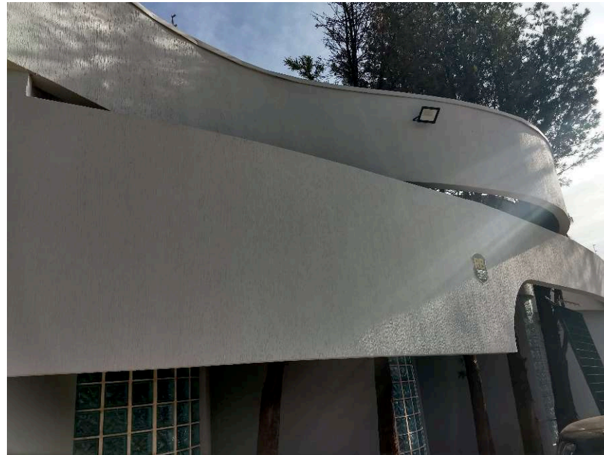
Detalhe da aplicação de textura acrílica em parede.
