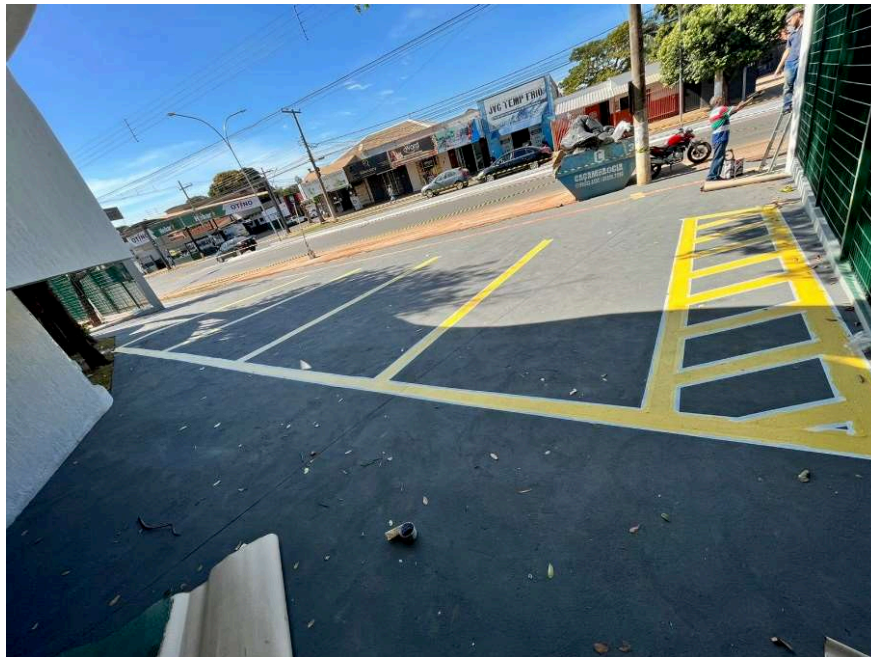
Detalhe de pintura e demarcação de piso com tinta epóxi.
