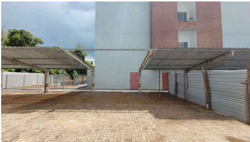
Retirada das telhas metálicas
