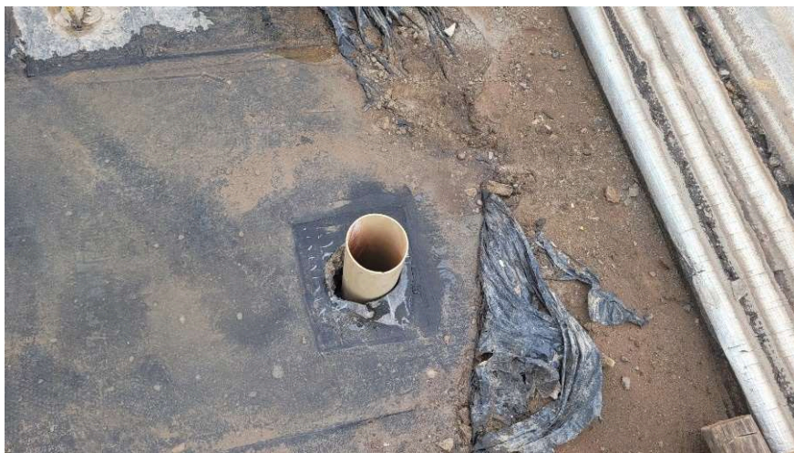
Ampliação do sistema de drenagem através da instalação dos novos ralos
