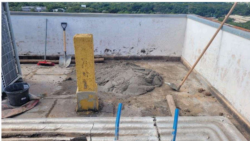
Contra piso do berço (sóculo) do ar condicionado em argamassa
