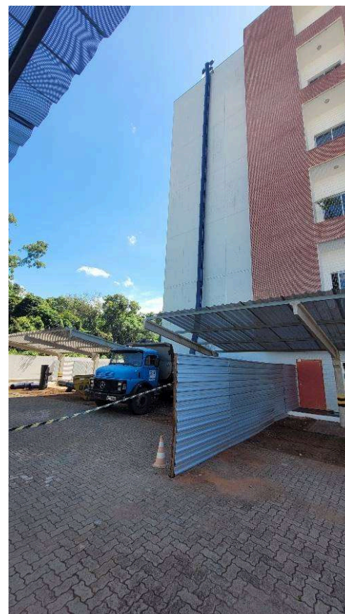
Instalação duto coletor de entulho, por gravidade
