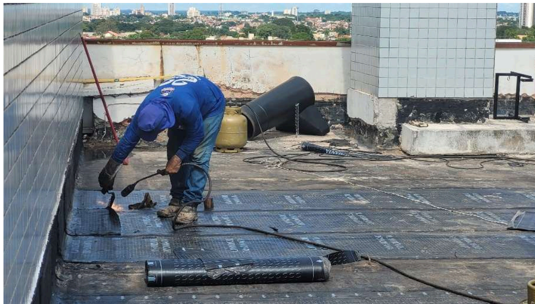
Impermeabilização de superfície com manta asfáltica
