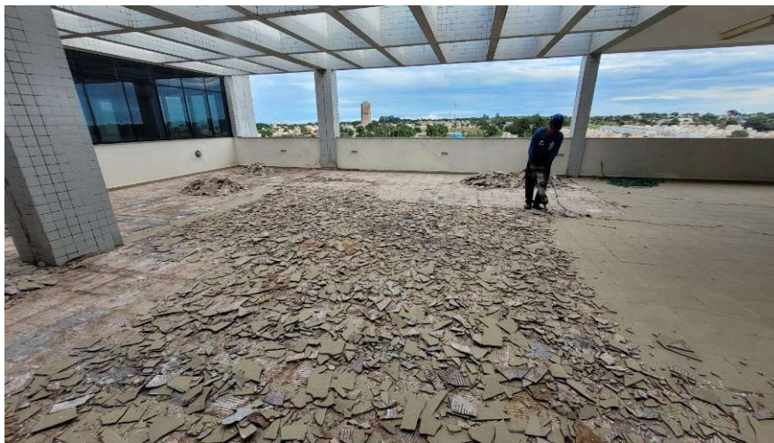
Demolição da regularização (mecanizada com martelete pneumático)
