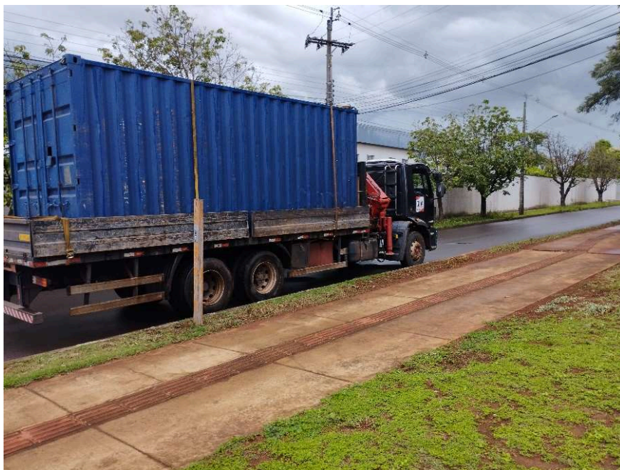
Mobilização do container
