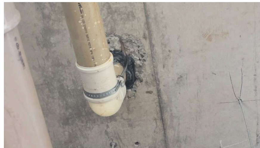
Ampliação do sistema de drenagem através da instalação dos novos ralos
