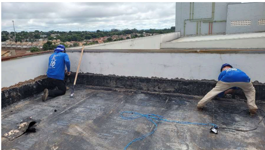
Retirada de impermeabilização flexível
