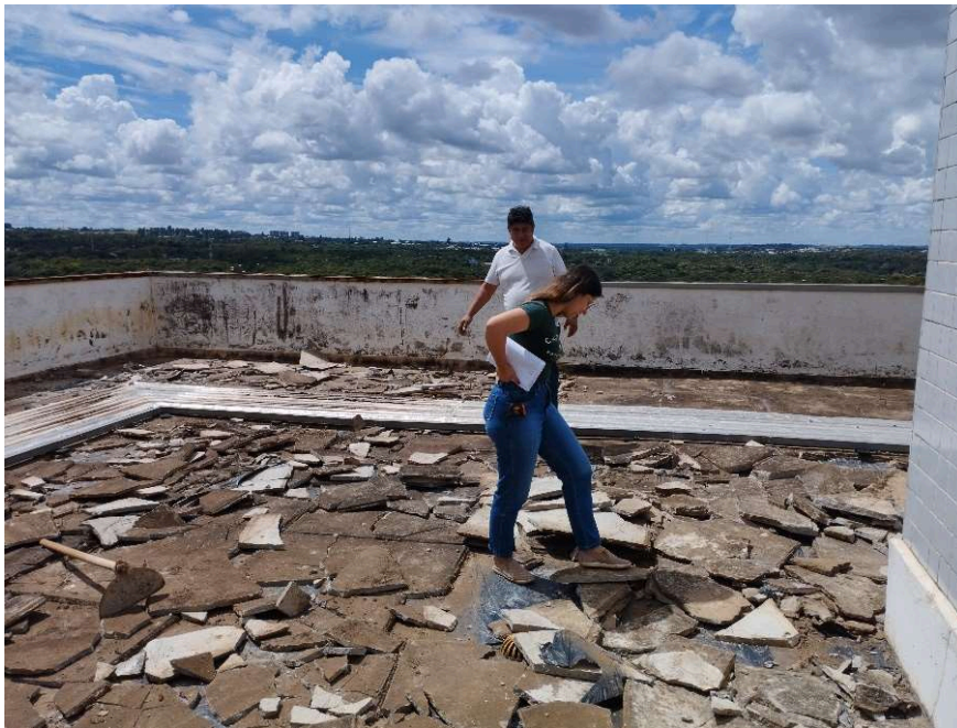
Foto da engenheira e o técnico do ar-condicionado
