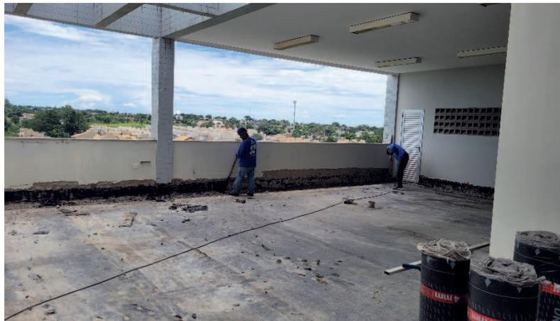
Retirada de impermeabilização flexível
