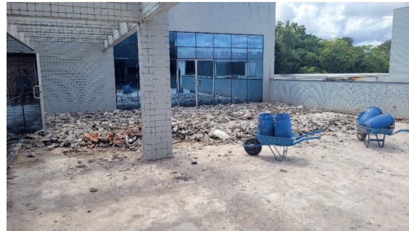
Demolição da regularização de forma mecanizada (martetele pneumático)
