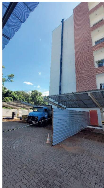
Instalação de duto coletor de entulho por gravidade
