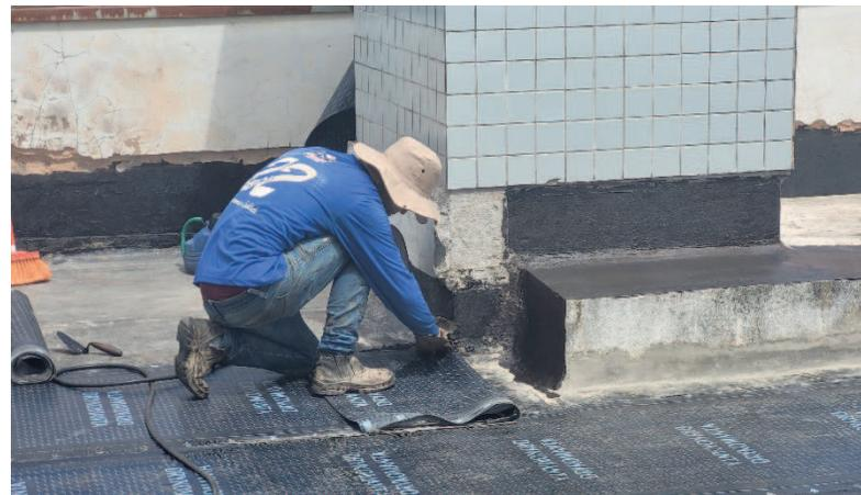
Impermeabilização de superfície com manta asfáltica
