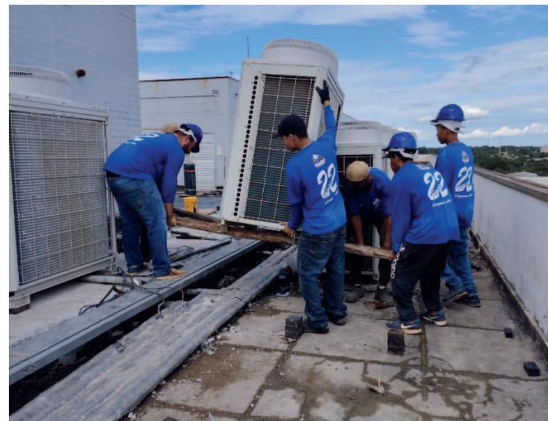
Retirada das condensadoras para a impermeabilização do sóculo
