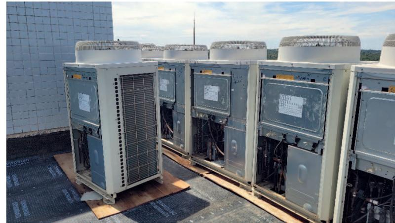
Desmontagem, transporte no mesmo pavimento e remontagem de 34 condensadoras do sistema vrf
