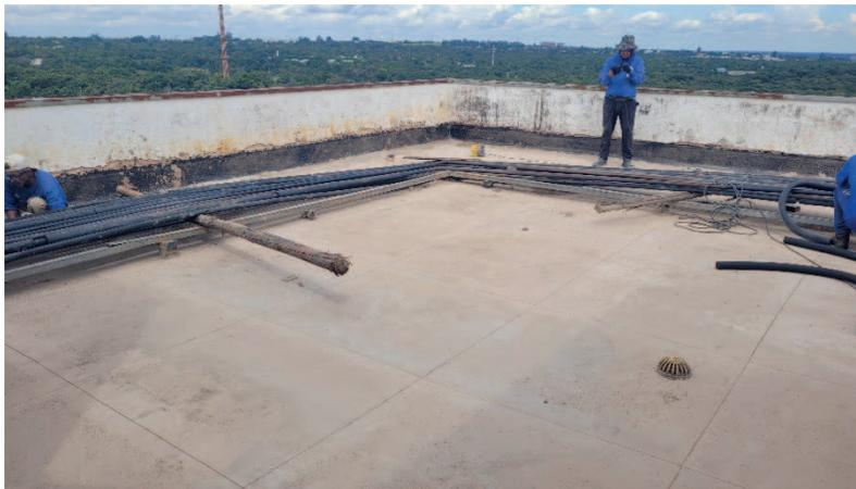
Detalhe das juntas de dilatação na proteção mecânica
