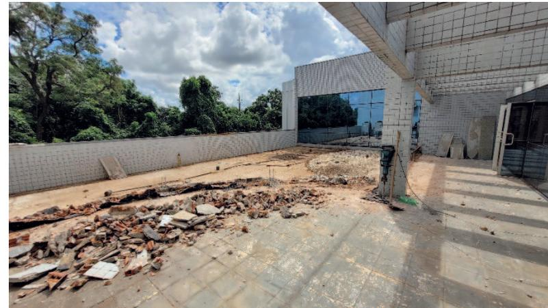
Demolição de mureta de alvenaria no terraço do 1º andar
