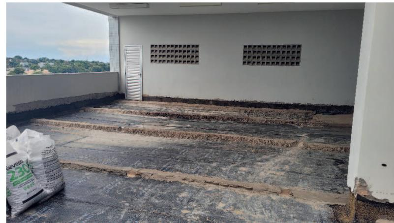
Taliscamento e barramento para o lançamento da argamassa bombeada no terraço do 5º pavimento
