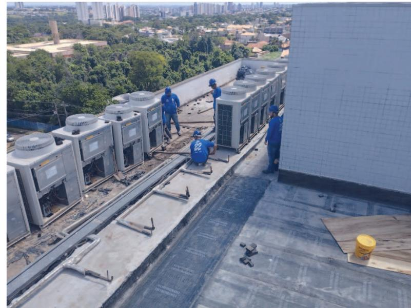
Desmontagem, transporte no mesmo pavimento e remontagem de 34 condensadoras do sistema vrf
