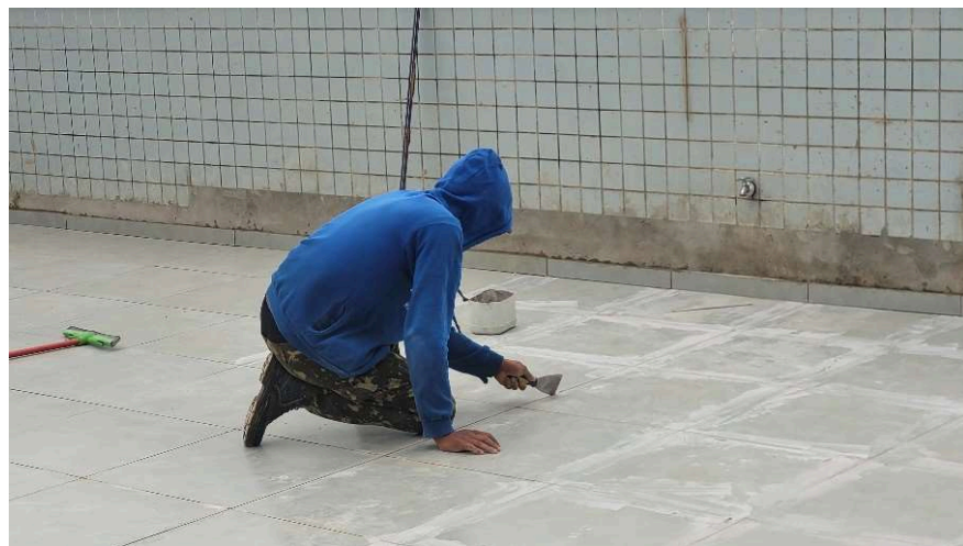
Aplicação de rejunte
