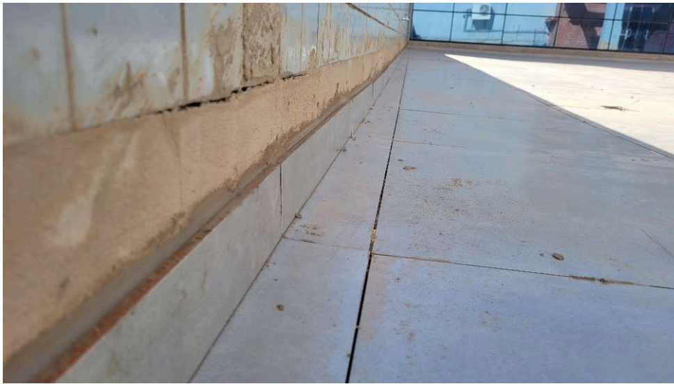
Instalação do rodapé em porcelanato
