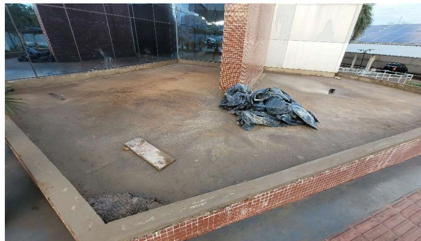
Proteção mecânica do espelho d'água com argamassa de cimento e areia
