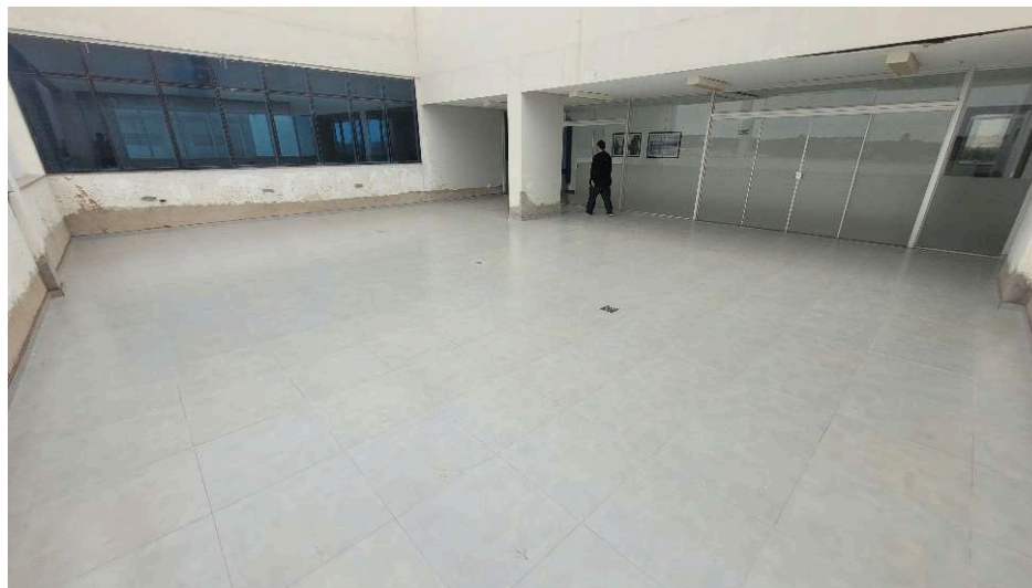
Instalação do piso porcelanato no 5º andar
