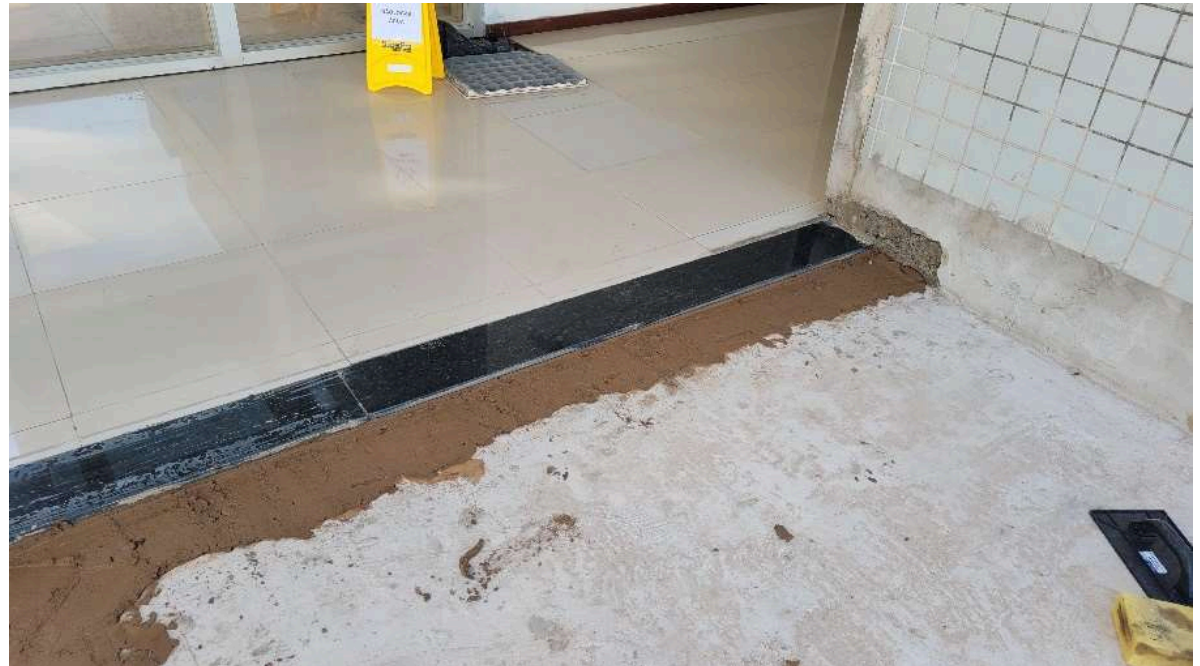
Proteção mecânica e assentamento do granito
