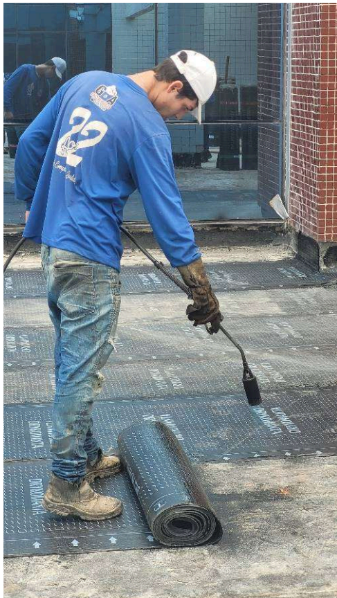
Aplicação de manta asfáltica no terraço
