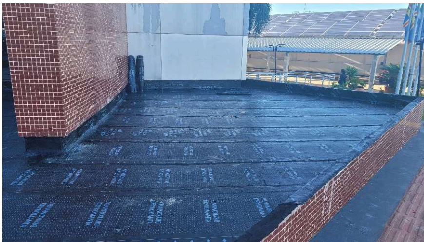
Aplicação do prime e impermeabilização do espelho d'água com manta asfáltica
