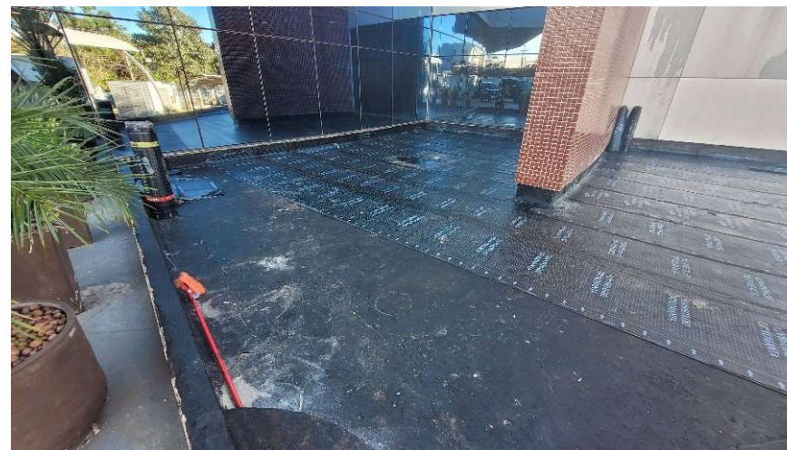
Aplicação do prime e impermeabilização do espelho d'água com manta asfáltica
