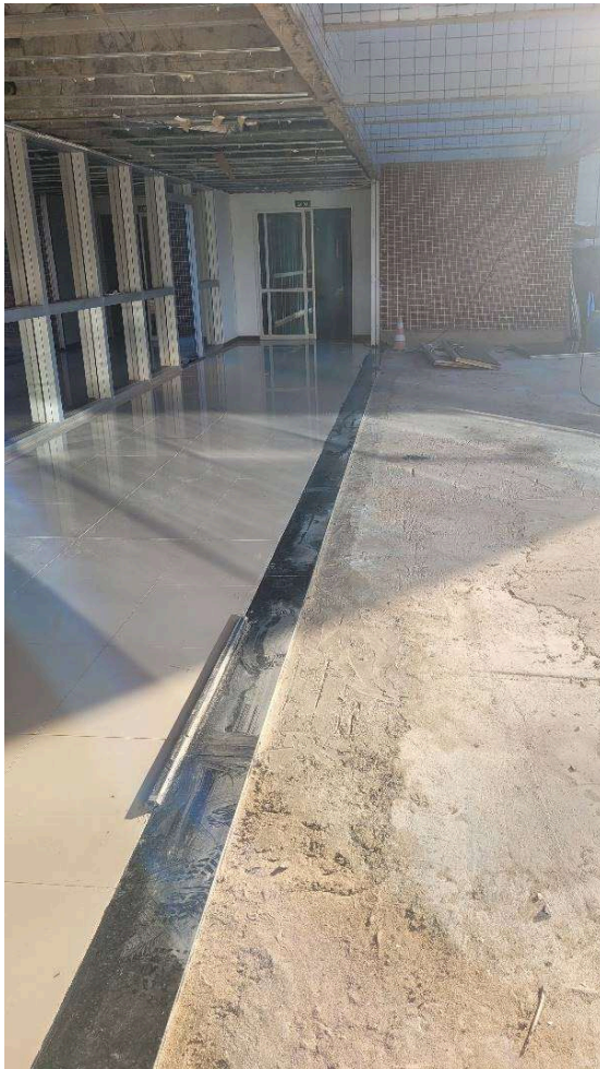
Proteção mecânica e assentamento do granito
