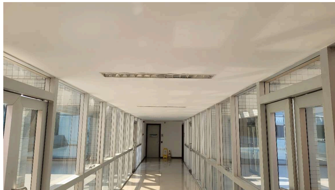
Reinstalação do forro de gesso e luminárias
