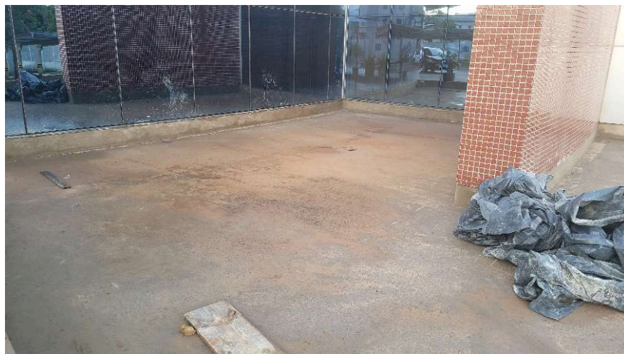
Proteção mecânica do espelho d'água com argamassa de cimento e areia
