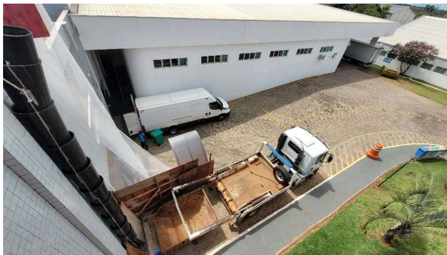
Caçamba de entulho e lixoduto
