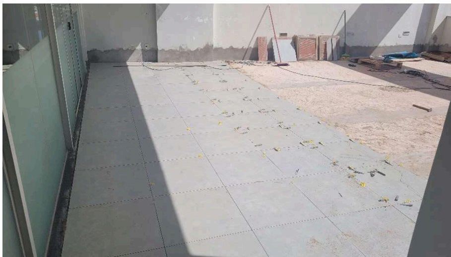
Instalação do piso porcelanato no 5º andar
