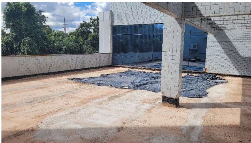
Proteção mecânica com argamassa no terraço
