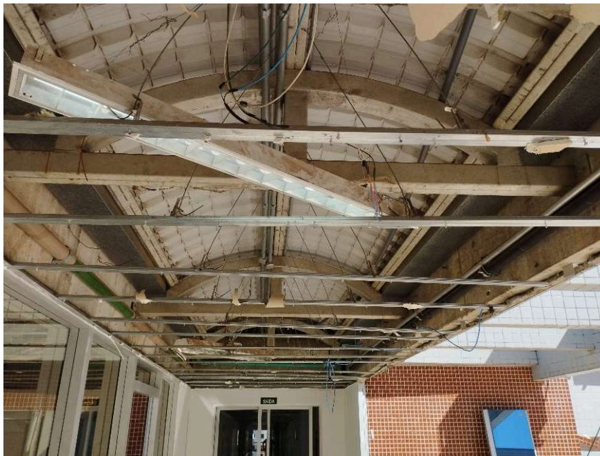
Remoção de luminárias e forro de gesso
