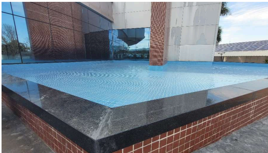
Instalação de soleira em granito
