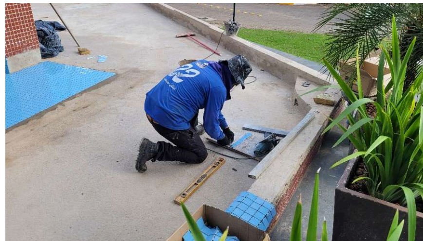
Revestimento cerâmico em pastilhas (5x5cm) aplicadas no espelho d'água
