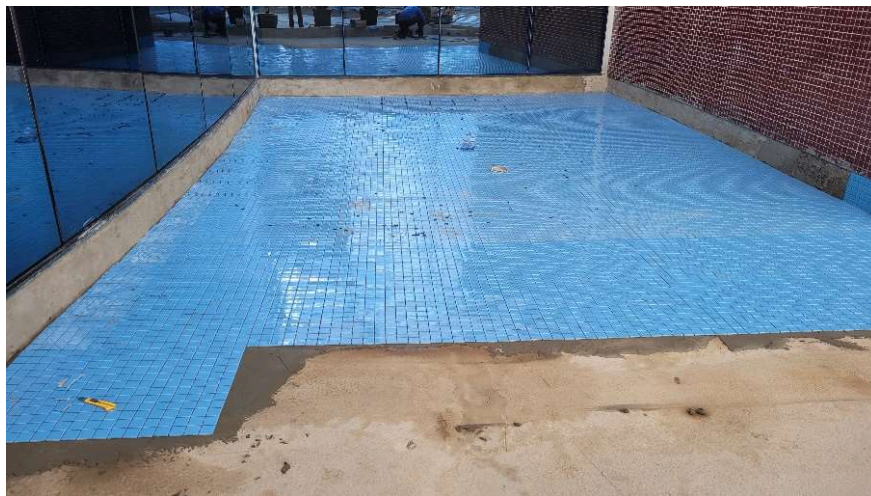
Revestimento cerâmico em pastilhas (5x5cm) aplicadas no espelho d'água
