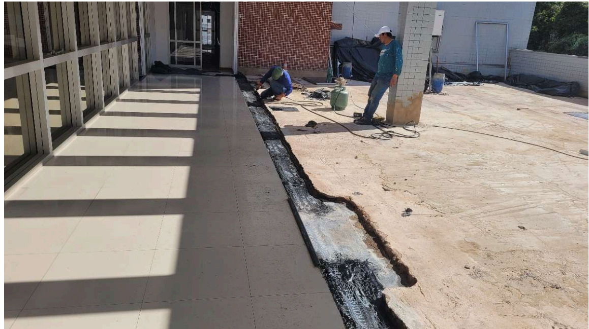
Impermeabilização com manta asfáltica
