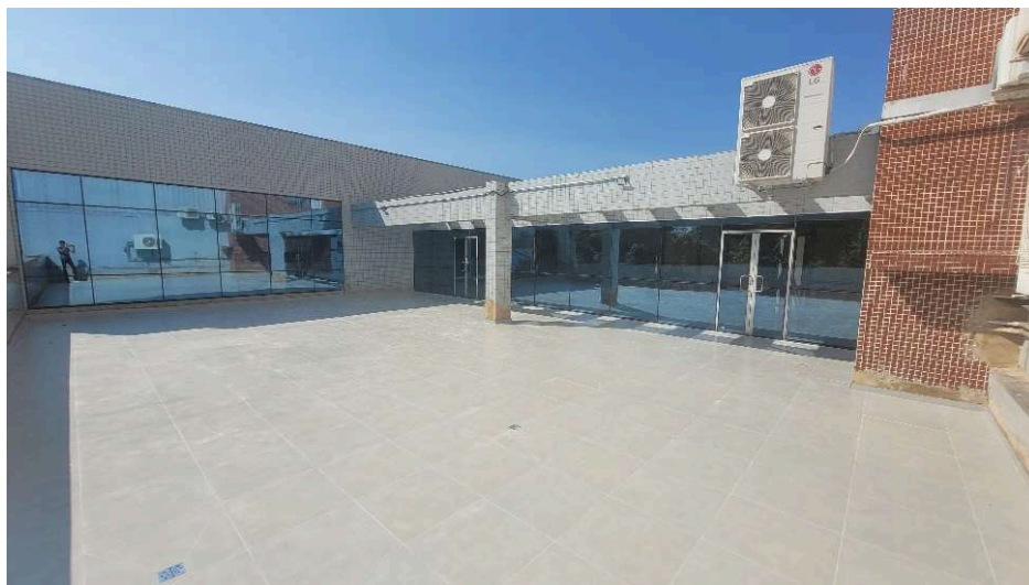
Instalação do piso porcelanato no térreo
