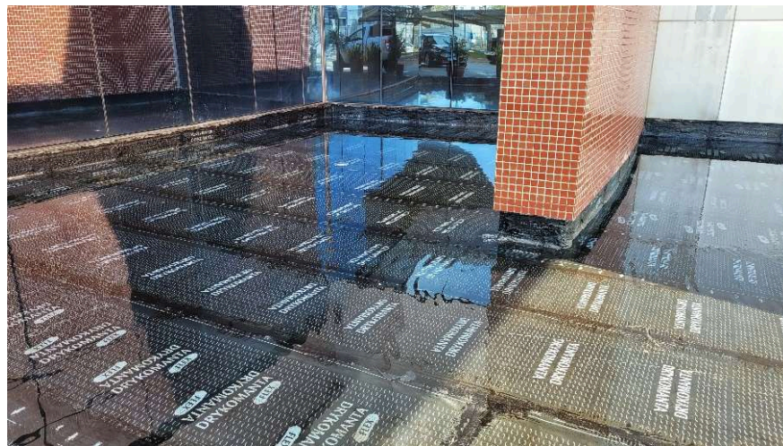
Teste de permeabilidade da manta asfáltica no espelho d'água
