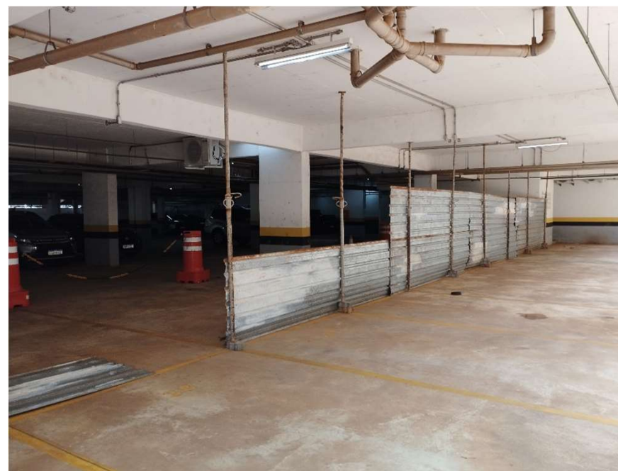
Montagem do tapume metálico
