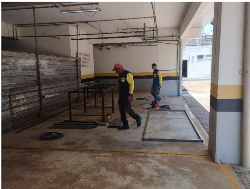
Montagem das bancadas de usinagem do ACM
