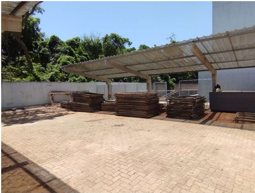
Locação de andaime fachadeiro e montagem
