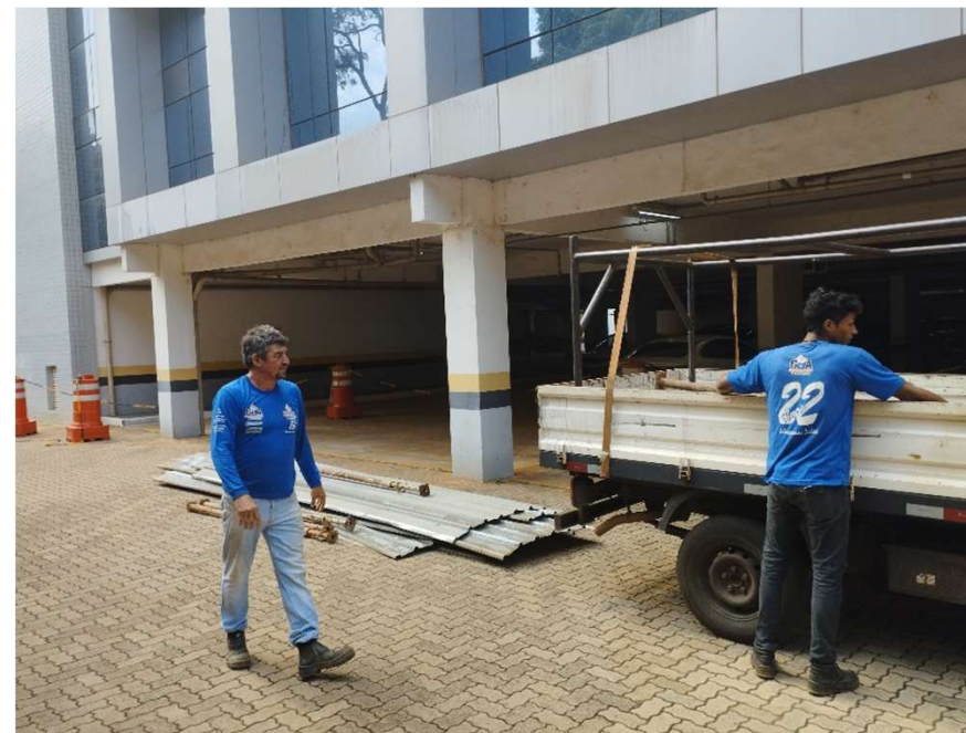
Mobilização de canteiro
