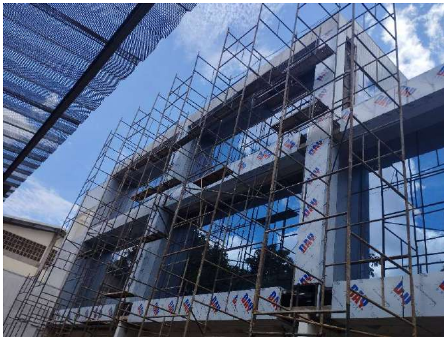
Substituição e instalação do ACM - prumada 4
