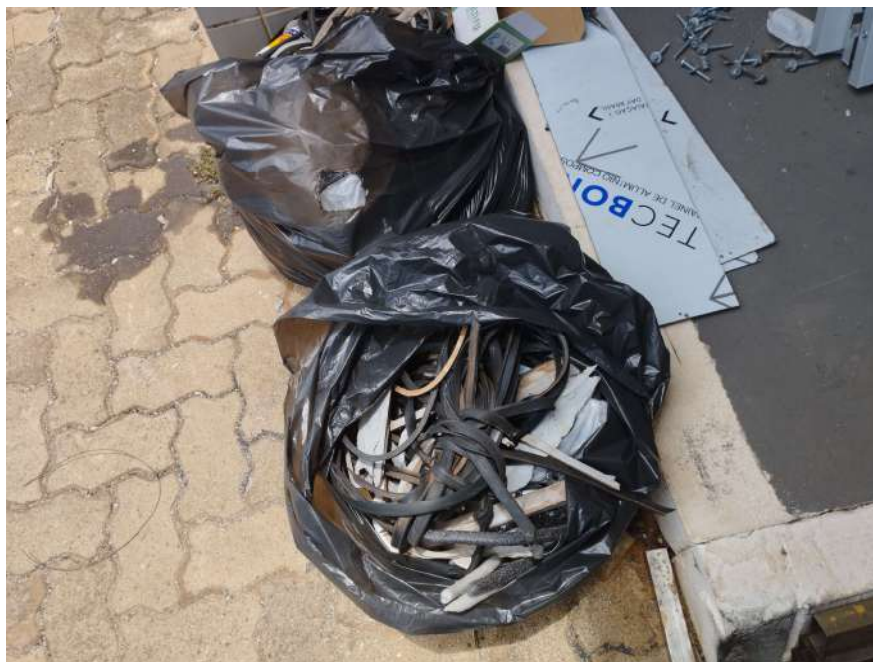
Retirada da borracha existente dos caixilhos
