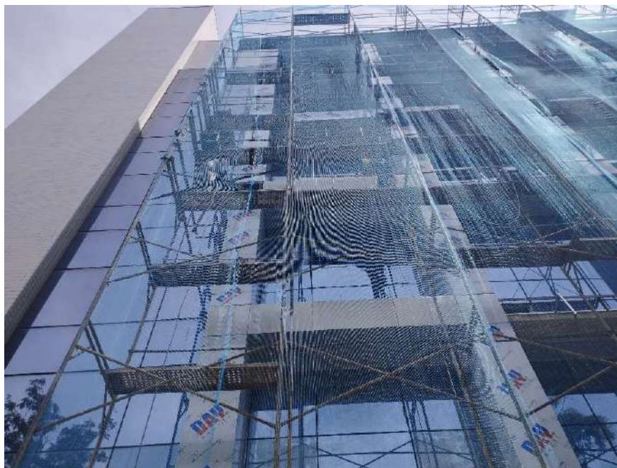
Substituição e instalação do ACM prumadas 2 e 3
