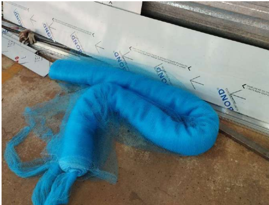
Colocação de tela em andaime
