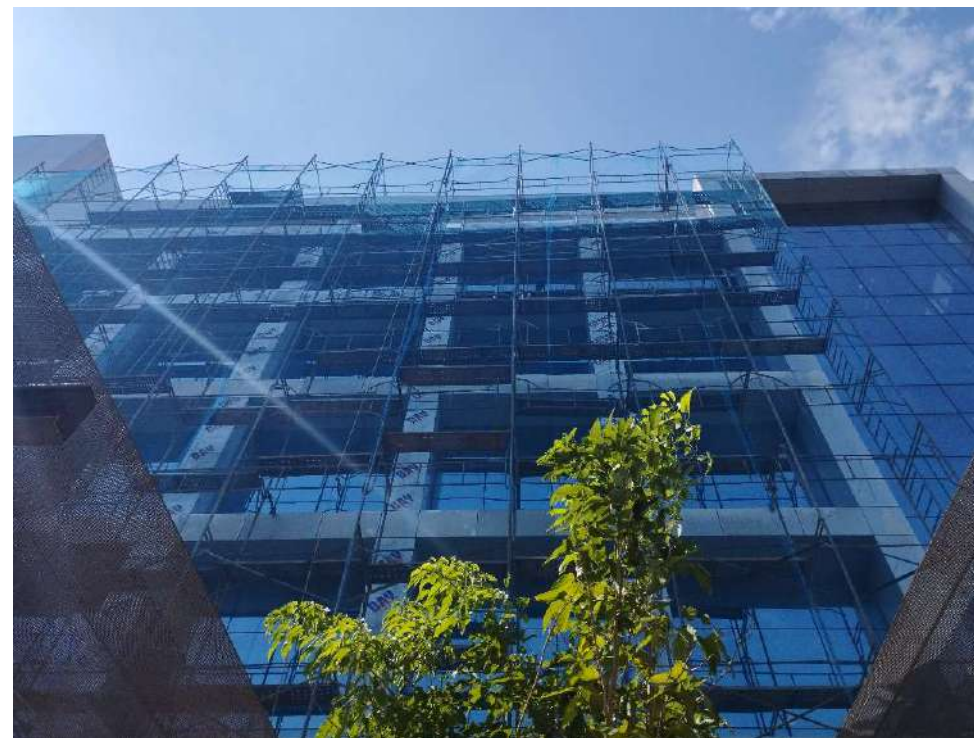
Locação de andaime
