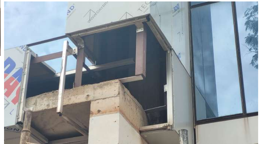
Substituição da estrutura metálica para o suporte do ACM
