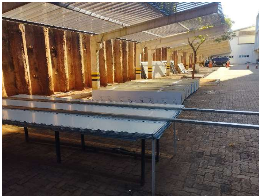
ACM já usinado pronto para instalar
