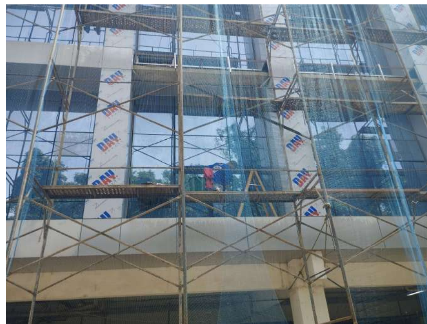
Instalação da nova borracha dos caixilhos
