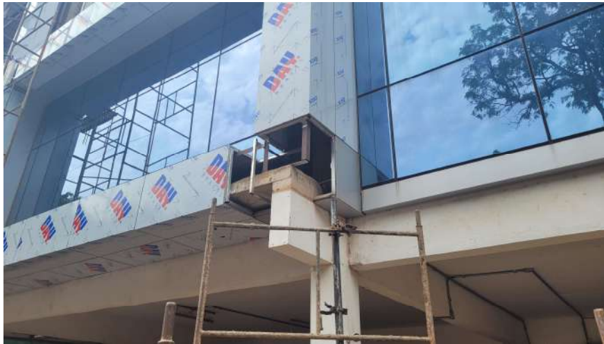
Substituição da estrutura metálica para o suporte do ACM
