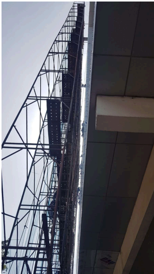
Locação de andaime
