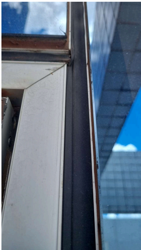
Instalação de novas borrachas dos caixilhos
