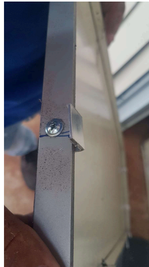
Detalhe do perfil do ACM
