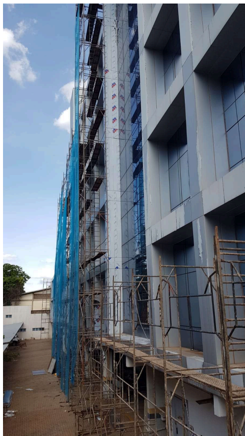
Tela em andaime fachadeiro
