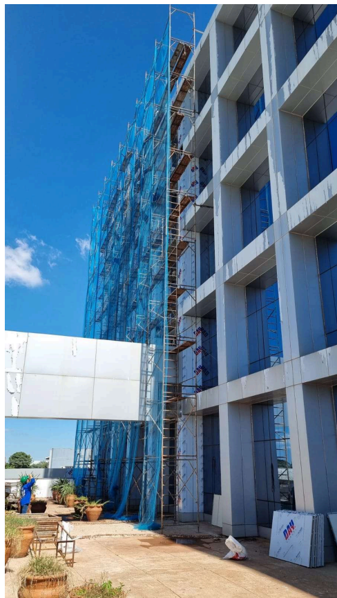
Tela em andaime fachadeiro
