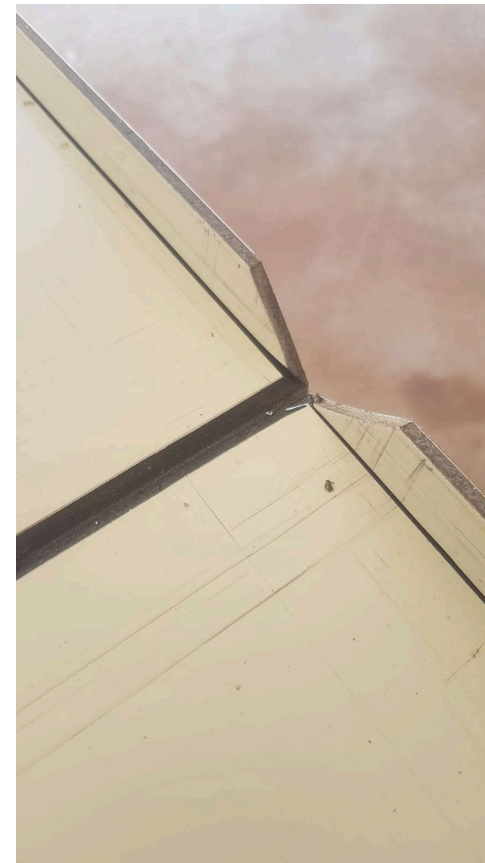
Detalhe do perfil do ACM
