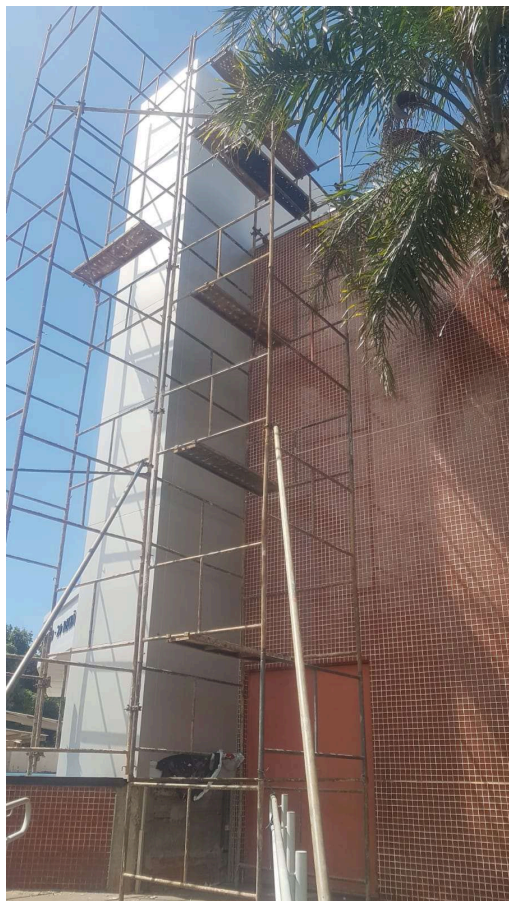
Substituição e instalação do ACM na fachada
