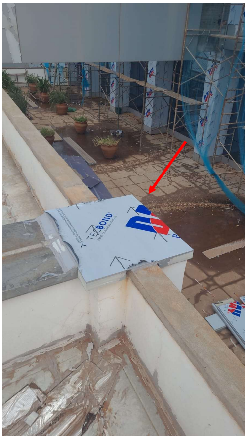
Acabamento do ACM – topo do pilar
