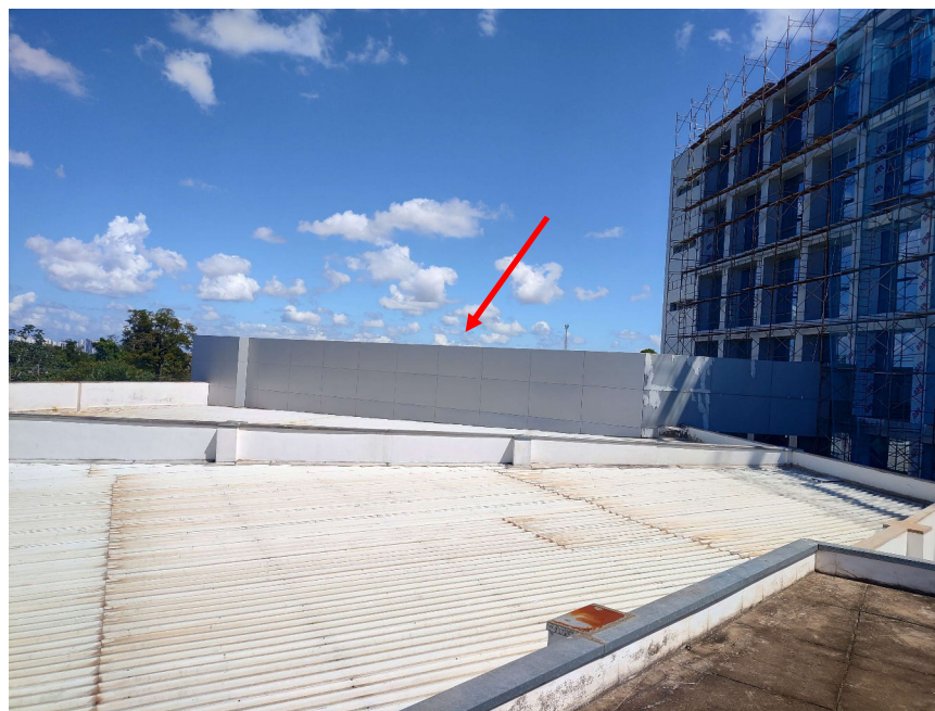
Substituição e instalação do ACM – posterior da platibanda
