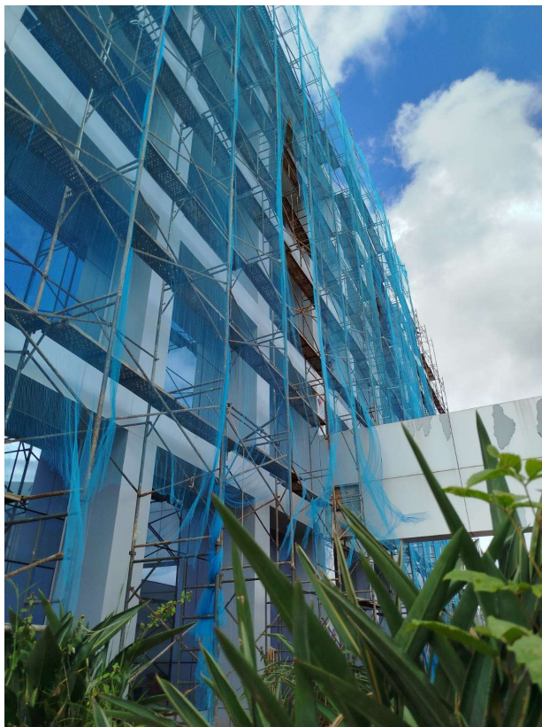
Locação de andaime
