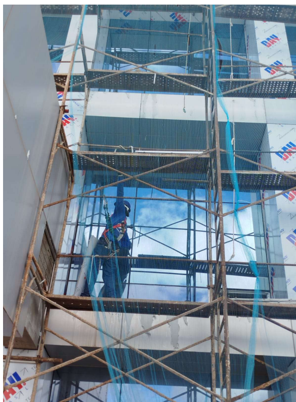
Tela em andaime fachadeiro e EPI para funcionários
