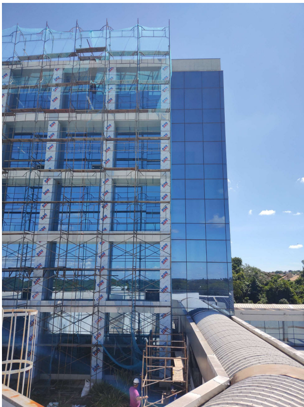
Substituição e instalação do ACM (fachada sul)
