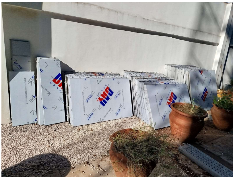
Placas de ACM armazenadas
