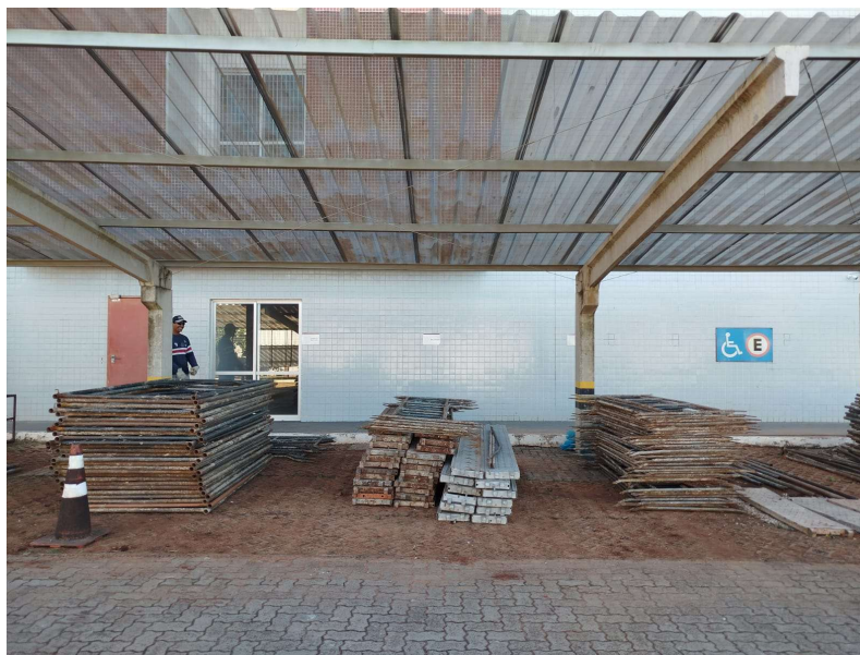
Andaimes armazenados para desmobilização e limpeza do canteiro de obras
