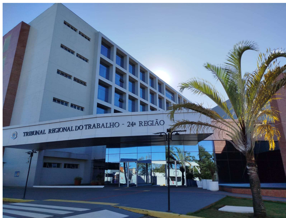
Fachada principal – ACM totalmente substituído
