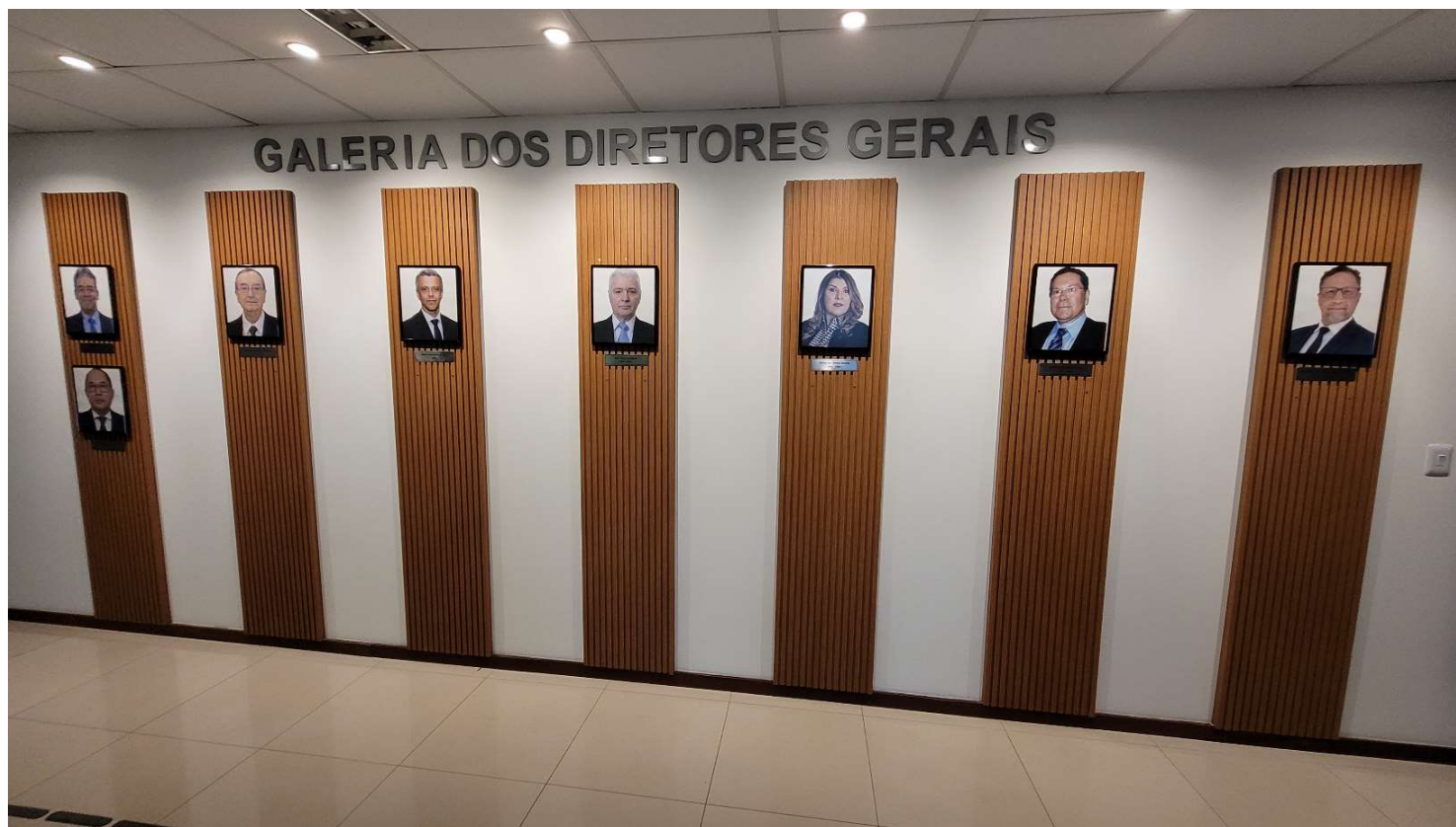
Galeria dos diretores gerais concluída conforme o projeto
